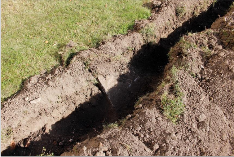
Figur 10. Söder om långhuset påträffades en flathuggen sten i schaktet. Möjligen har den hört till det rivna vapenhuset. Foto mot NÖ.
