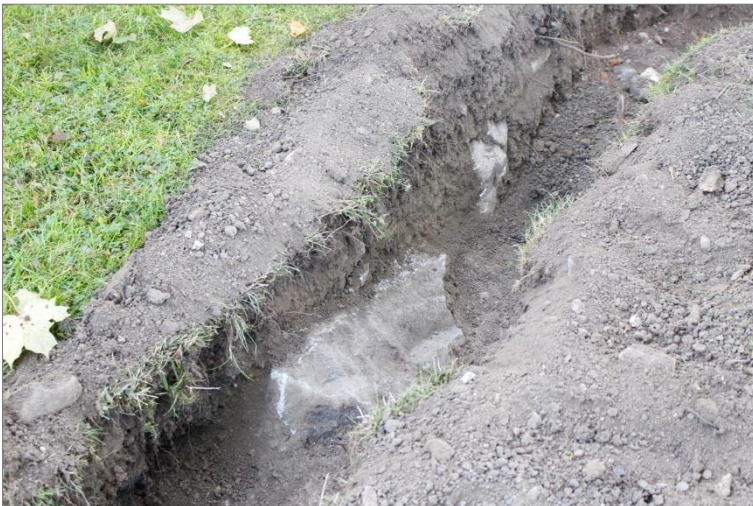
Figur 7. Strax väster om sakristian fanns i schaktet en 0,6 m stor sten samt en 0,2 m stor sten i schaktkanten. Foto mot NÖ.
