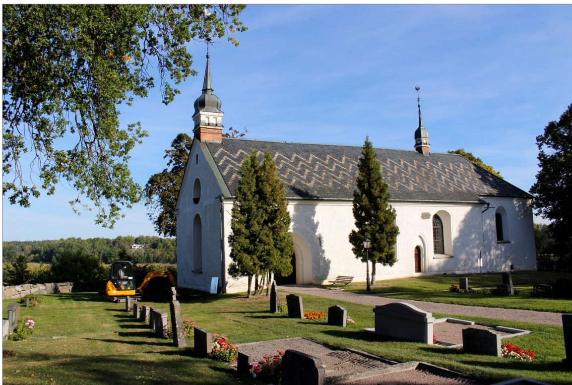
Figur 4. Pågående schaktningsarbeten vid Dalby kyrka i september 2016. Foto mot N-NÖ.
