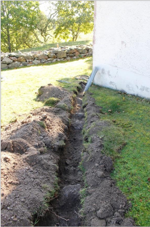
Figur 6. Murresterna A fanns vid korets norra sida och bestod av gråsten och kalkbruk. Foto mot SÖ.
