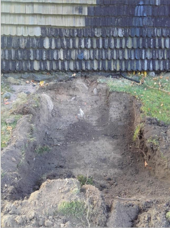
Figur 14. Schakt för plåt på klockstapelns östra sida. Foto mot V.
