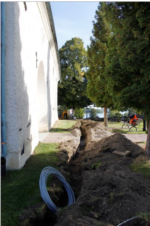
Figur 11. Schaktet längs långhusets södra sida. Foto mot Ö.
