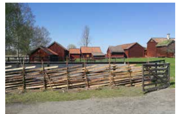
Under 2021 gjordes de sista kompletteringarna med ny gårdsgård intill dansbanan i anslutning till den nya entrén på Disagården. Foto Sverker Larsson.
