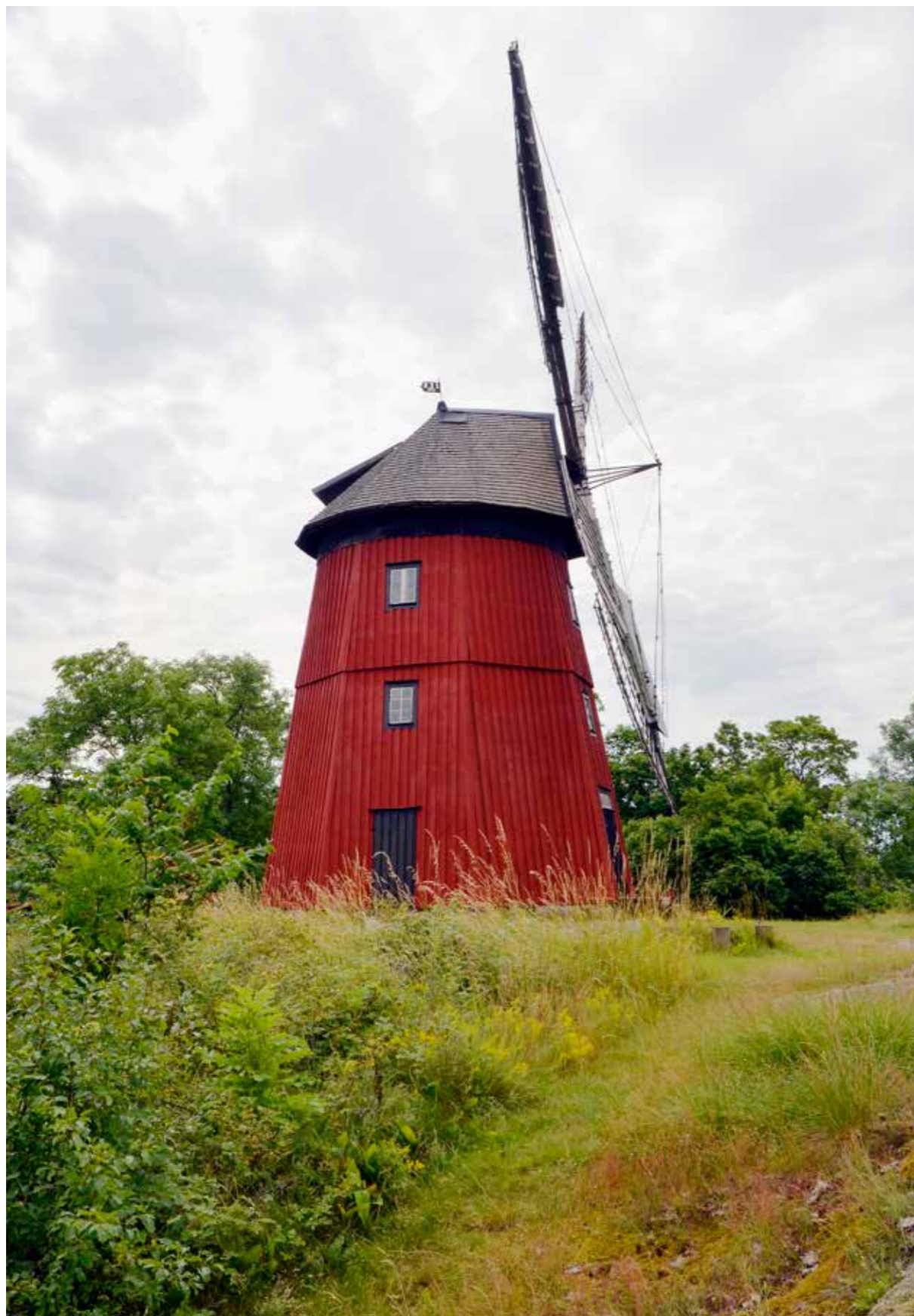
Väsby kvarn har ett exponerat läge på Kvarnbacken i Lagga. Kvarnen är en bolländare, med fast byggnad men vridbar hätta. Kvarnen uppfördes 1876 och drevs kommersiellt fram till 1946. Kvarnen har nu restaurerats och fått ny panel. Foto Agnetha Pettersson.
