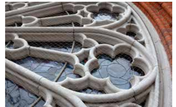
Nyttillverkade skyddsglas inom blyspröjs har monterats innanför masverket i Faderns fönster på Uppsala domkyrka. Skyddsglasen ska fungera som klimatskydd för de bemålade ursprungliga glasen. Foto Olle Norling.
