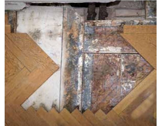
Vid årets stora VVS-renovering av Viks slott i Balingsta socken upptäcktes ett gammalt bemalat 1700-talsgolv under ekparketten från första hälften av 1900-talet. Foto Per Lundgren.
