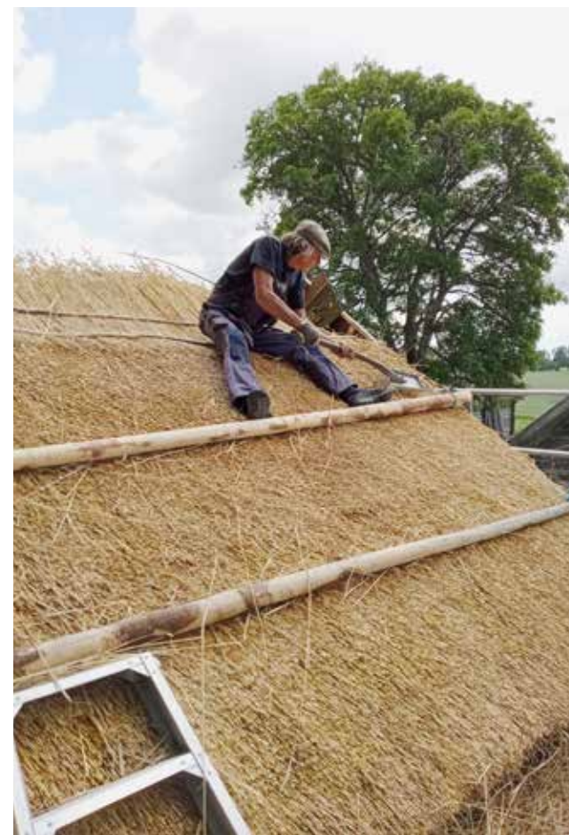
Halmtakläggare Eje Arén lägger om halmtaket med tröskad långbalm av råg på spannmålsboden på Kvekgården. Foto Göran Ulväng
