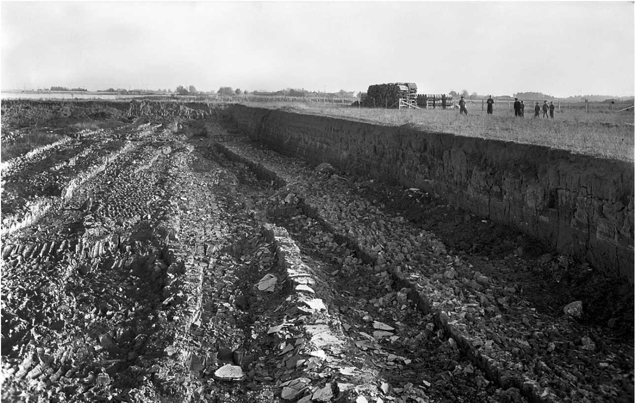
Fig. 8. Lera i meter efter meter. Av leran tillverkas byggnadstegel, taktegel, dräneringsrör, kakelugnar och konstgods. Vaksala tegelbruks lertäkt, Fålhagen i Uppsala, 1947. Foto: Gunnar Sundgren, Upplandsmuseet.
