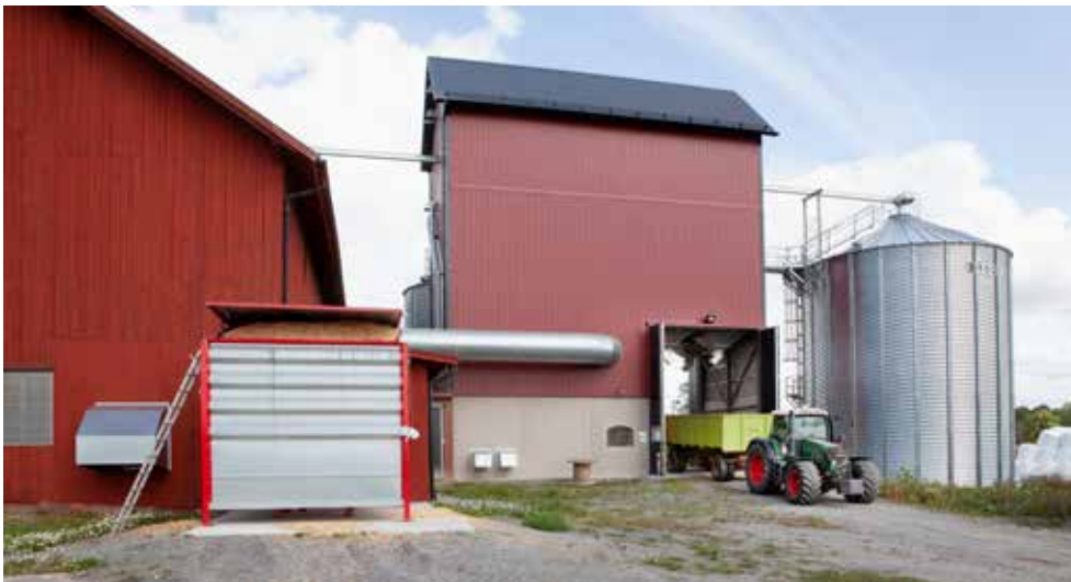
Sörgårdens nya panna och tork. Till vänster flis som driver pannan. Till höger silos för förvaring av spannmål.
