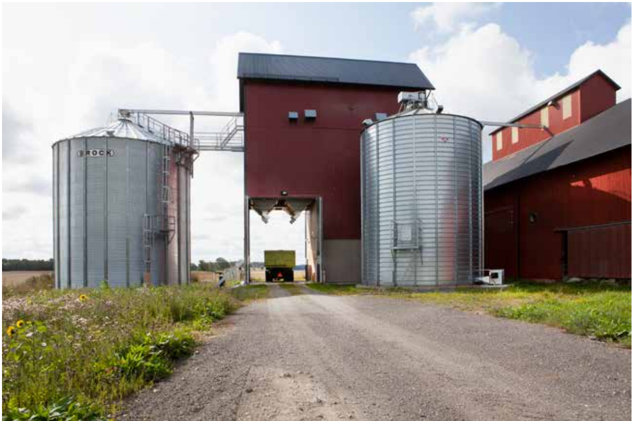
Förbättrad logistik på Sörgården. Lastbilarna kan ta bakvägen och behöver inte åka över gårdsplanen.
