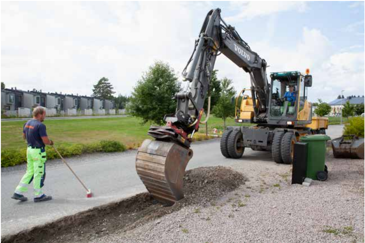
Norrgårdens Christer i grävmaskinen har gått från bonde till lönearbetare.
