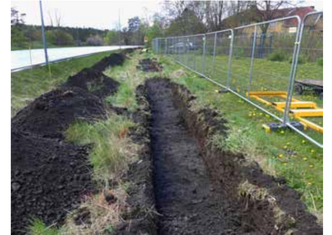
Figur 9. Schakt i den norra yttre delen av den stora boplatssytan, grävda år 2020 inför byggnation av cykelväg. (L1941.2286/Uppsala 487:1). Till vänster syns Hågavägen i schaktens botten kan det mörka kulturlagret anas. I det borte schaktet (nr. 154) påträffades obrända ben av får/get som kunde dateras till yngre bronsålder, 1050–850 f Kr (2 sigma, Ua 66836). Foto mot SV, H. Göthberg (Ur Göthberg 2020a, fig. 9).
