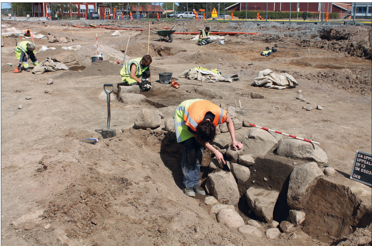
Figur 6. I förgrunden syns den rensade sektionen genom ett stolpfundament där en av de större skoningsstenarna ser ut att ha rasat in i utrymmet efter den avlägsnade stolpen. Stolpfundamentet direkt norr härom hade en stratigrafisk relation till ett grophus och i stolpfundamentet norr om detta, invid ett större markfast stenblock, hittades ett komplett hundskelett som deponerats under destruktionskedet. Foto: Jonas Wikborg, SAU.
