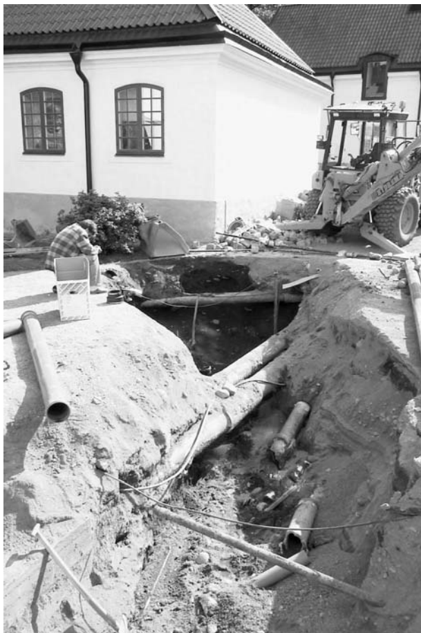
Figur 12. Schakt 2. Servisanslutning upp mot Ärkebiskopsgården. Trots ett stort antal tidigare VA-schaktningar kunde en sektion på schaktet dokumenteras.
