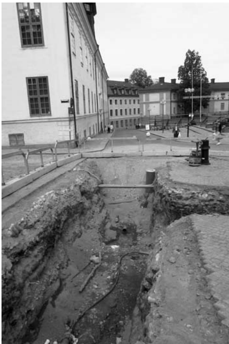
Figur 4. Schakt 1 vid starten i korsningen mellan Biskopsgatan och Akademigatan.
