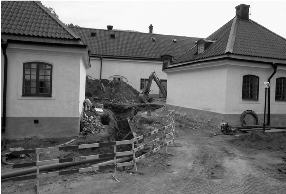
Figur 25. Ett av schakten på ärkebiskopsgården, sedan en del av schakten har återfyllts. Inom området har en stor del äldre schaktningar skett för VA, el och tele.
