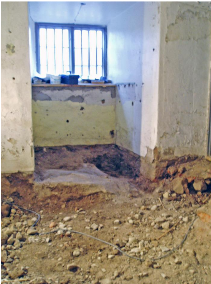
Figur 13. Första fönsternischen från söder längs med östra ytterväggen. Delvis i denna fanns en större flat håll.
