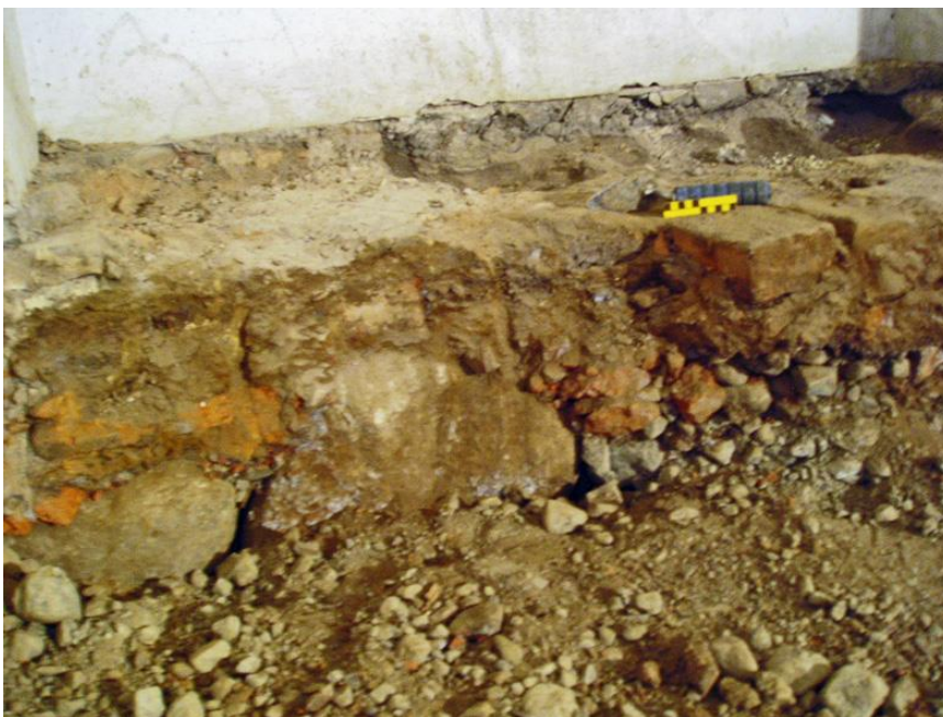
Figur 11. Detalj av ovanstående foto med grundstenar längs med västra väggen med rester efter ovanliggande tegelgolv.
