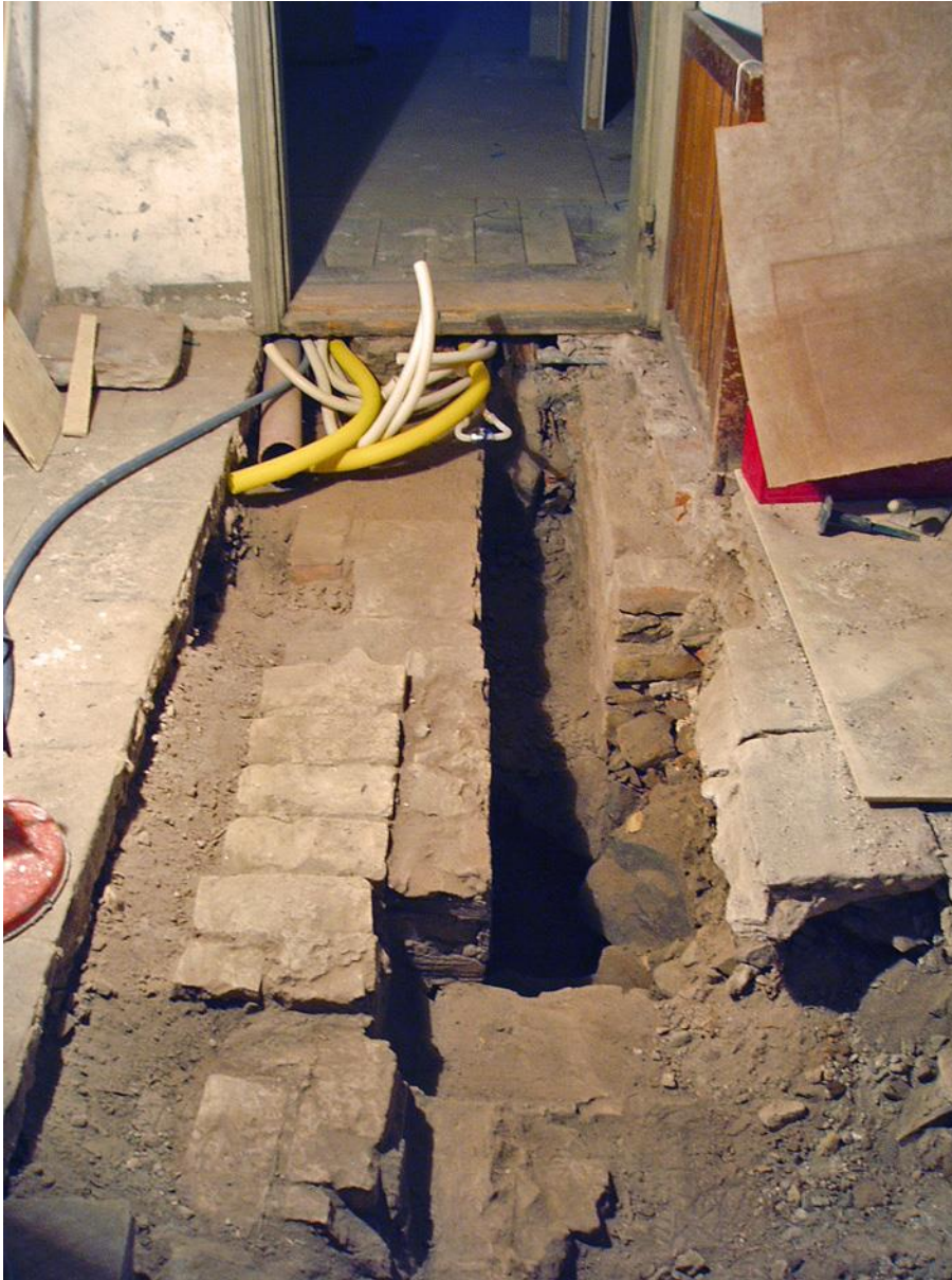
Figur 7. Ledningsschaktet genom rum 208, med den tidigare källartrappans västra mur synlig direkt under det på bilden borttagna kalkstensgolvet. Till höger i bild syns räcket till nuvarande källarnedgång.
