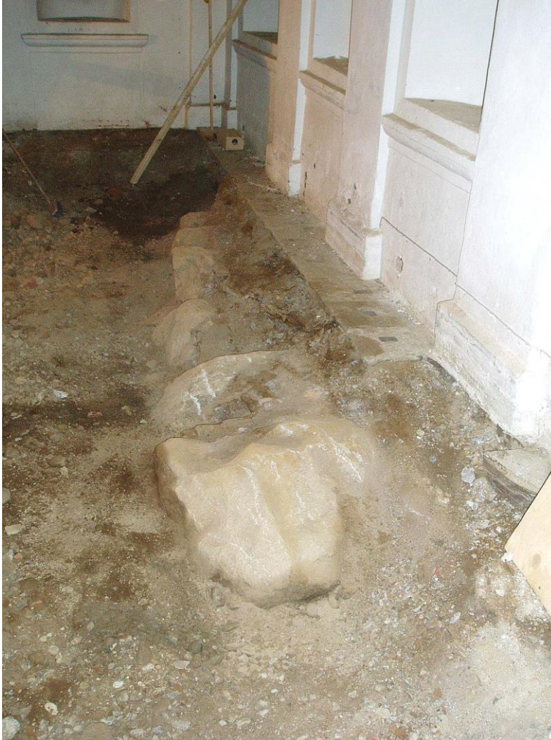
Figur 23. Den av kraftiga stenar bestående grundmuren intill östra vägglinjen i rum 222, vinterträdgården.
