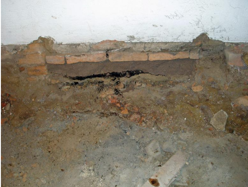
Figur 32. En igensatt öppning i rum 224 (C). Här i nederkanten fanns inga grundstenar, utan här låg väggens tegelstenar endast på ett jordlager som hade en kolhorisont i nederkanten.
