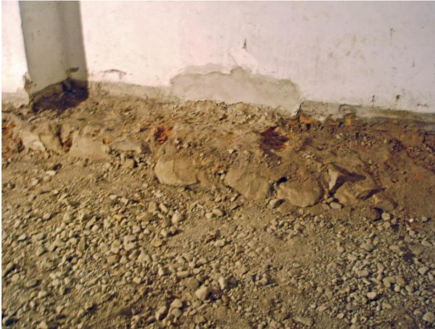
Figur 12. Grundstenarna längs med den södra väggsidan.
