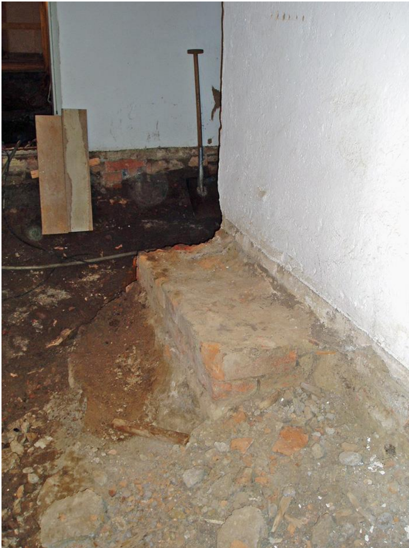
Figur 33. I norra kanten av rummet fanns en mindre tegelklack (D).
