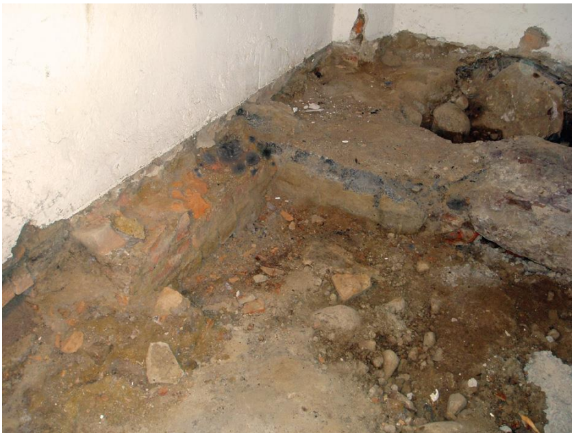
Figur 31. Grundmur (A) i rum 224 och den i öster intilliggande tegelklacken (B).
