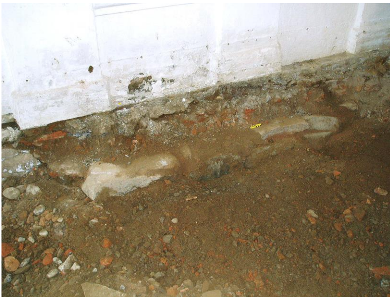
Figur 24. Den tydligt markerade grundmuren längs med västra vägglinjen i rum 222.
