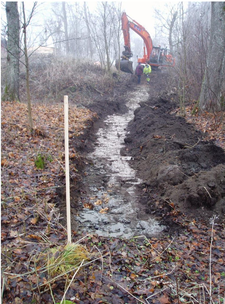
Figur 49. Efter schaktning framkom leran direkt under myllan. Inga konstruktionsrester kring vallgravens mynning fanns.
