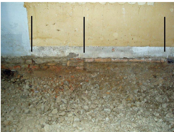
Figur 19. Foto mot västra väggen och de skillnader som iaktogs i grundens uppbyggnad markerade med tre svarta streck.
