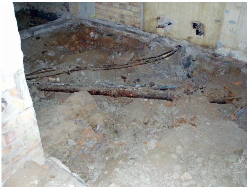
Figur 17. I rum 220 fanns en av rördragningar förstörd grundmur som sträckte sig mellan södra yttermuren och murstocken i norra delen av rummet.
