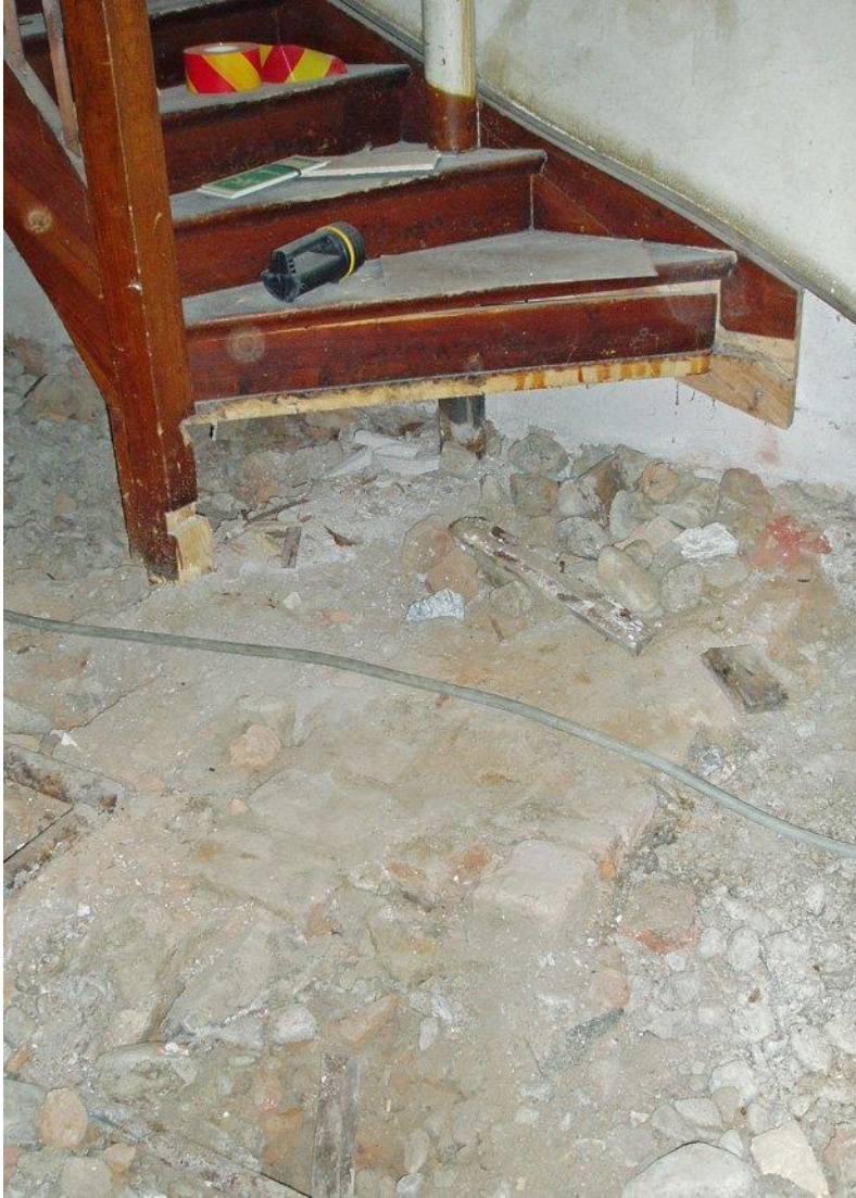
Figur 15. Detalj av bevarat tegelgolv invid trappan mot övervåningen.
