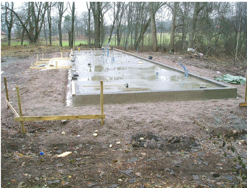
Figur 46. Plattan till servicebyggnaden är gjuten och klar.
