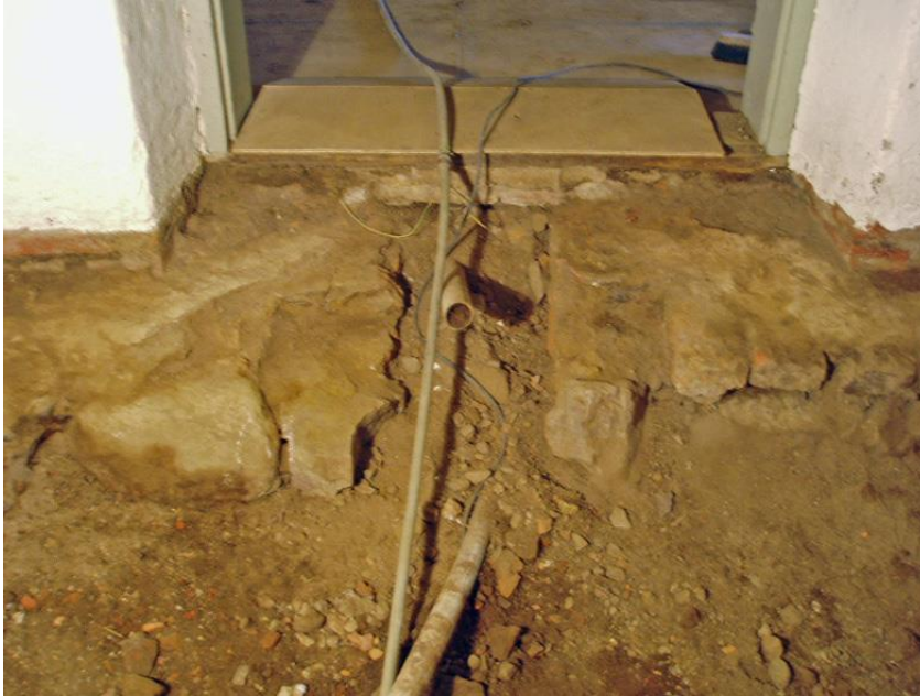
Figur 28. Invid dörröppningen mot öster framkom grundstenar med ovanliggande tegelstenar.
