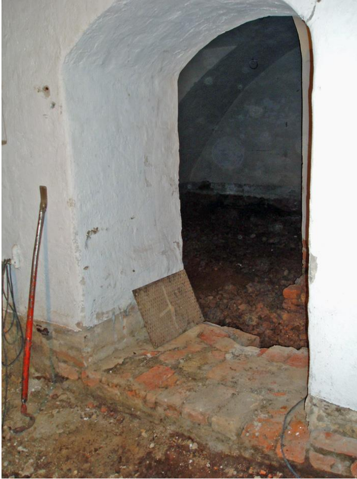
Figur 34. I dörröppningen in mot rum 225/226 fanns spår efter ett tidigare tegelgolv (E).
