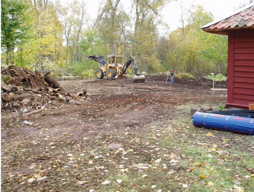
Figur 45. Påbörjad schaktning för servicebyggnaden. Schaktningsdjupet varierade mellan 0,2-0,5 m under markytan.
