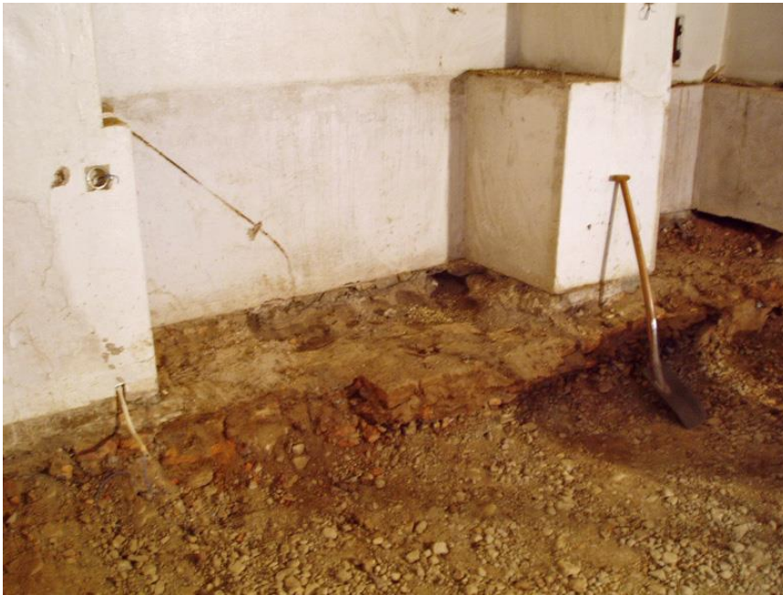
Figur 10. Grundstenar längs med västra väggen med rester efter ovanliggande tegelgolv.
