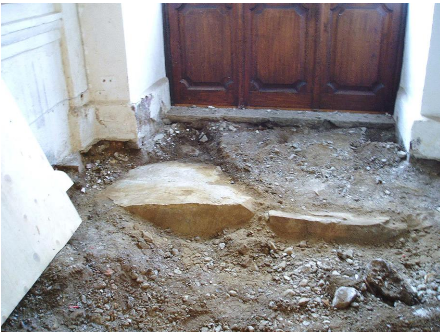
Figur 22. Längs med södra vägglinjen i rum 222, fanns under golvet en rad med grundstenar.
