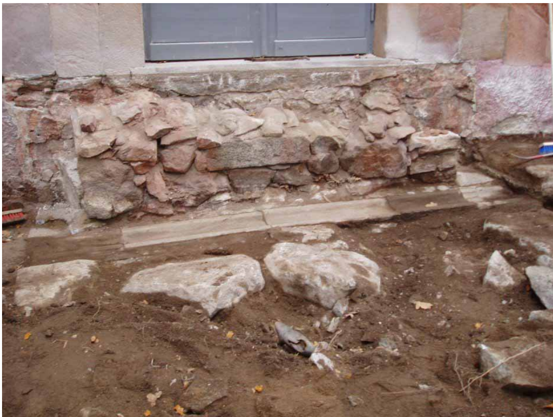
Figur 4. Detalj av avrinningsrännan under den gamla trappan.
