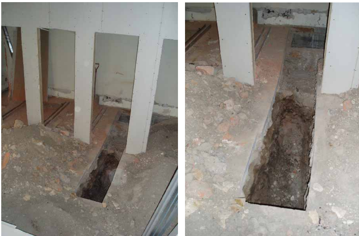
Figur 8-9. Schakt i golvet i kapprummet på bottenvåningen.
