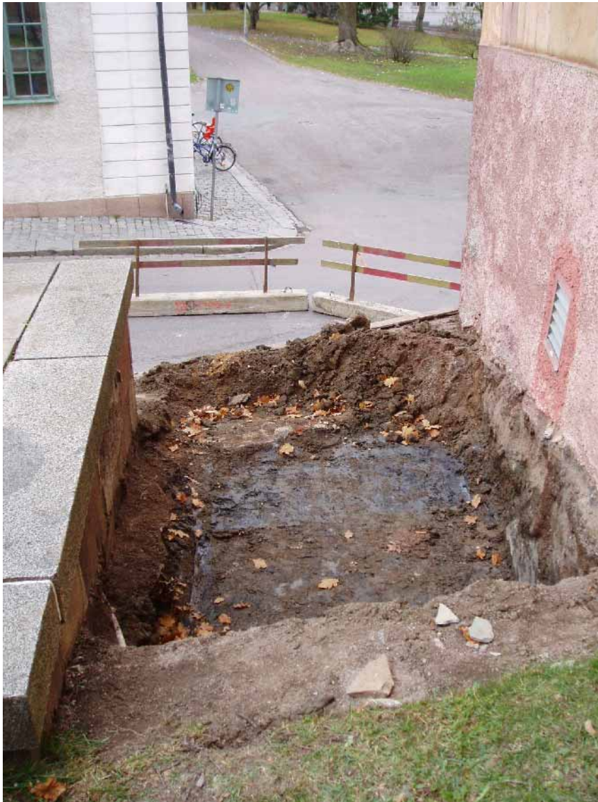
Figur 5. Gropen som togs upp för planerad nedläggning av fettavskiljare. Ca 1 m under marken framkom en grundplatta som lock för tidigare schaktningar. Foto från nordost.
