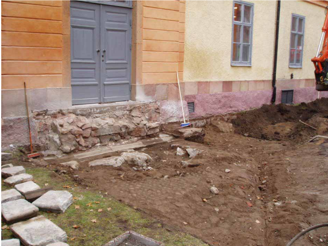
Figur 3. Översikt av schaktningarna för den nya trappan och rampen. I förgrunden syns den tidigare stenläggningen. Foto från norr.
