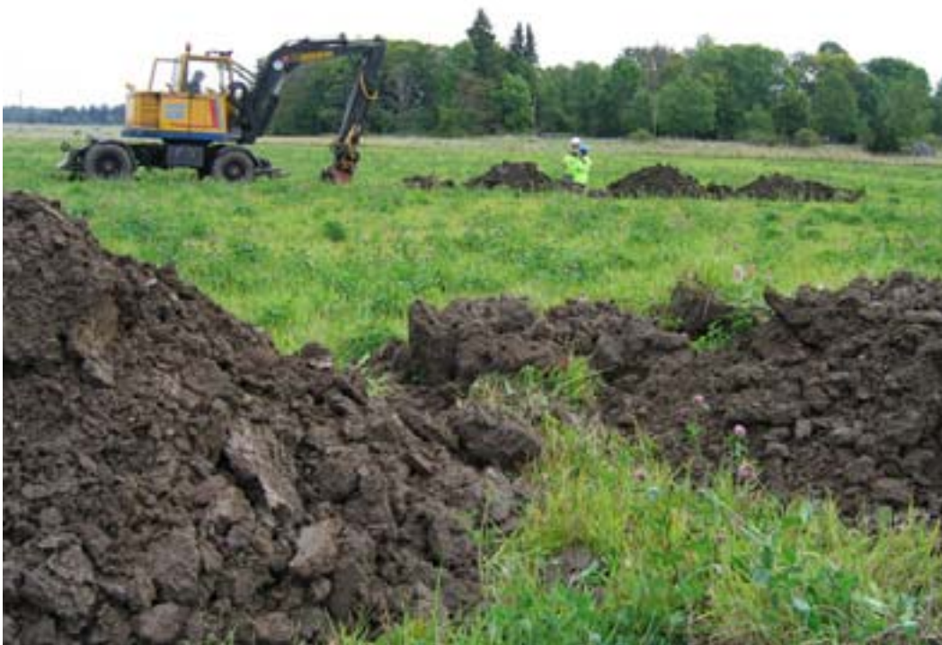
Figur 9. Schaktgrävning på lokal 14, från nordväst. Foto: Andreas Hennius, Upplandsmuseet.
