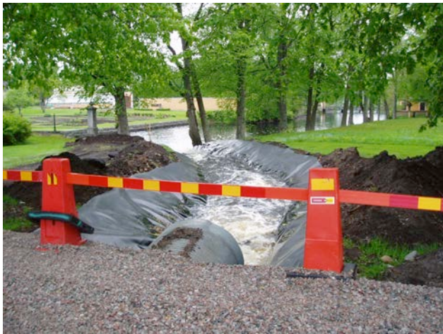
Figur 13. Vid schaktningarna vid den övre dammen leddes det uppdämda vattnet i en provisorisk ledning på den östra sidan om vatten fåran.
