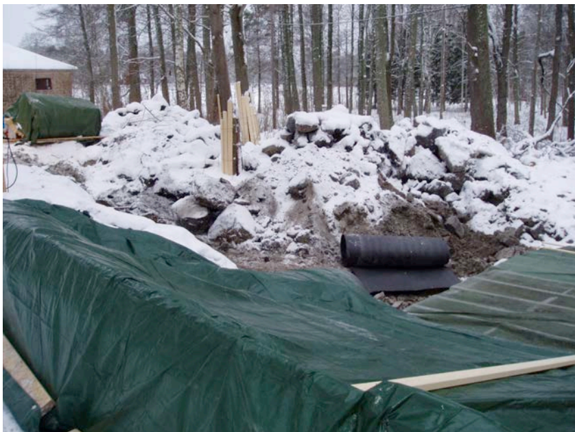
Figur 8. Schaktningar på västra sidan om kvarnen vid den nedre dammens norra ände. Foto från sydost.
