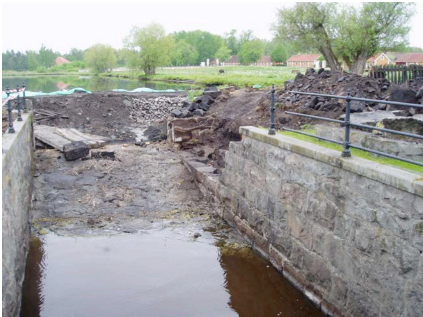
Figur 12. Schaktningar på norra sidan av övre dammen. Foto från norr .
