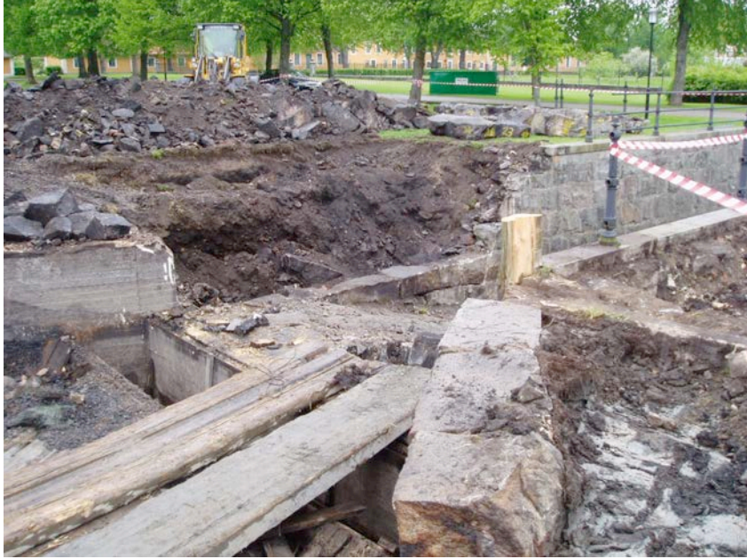
Figur 11. Schaktningar på norra sidan av övre dammen. Fyllnadsmassorna från schaktningarna har lagts upp på den västra sidan där det troligen finns lämningar efter de tidigare byggnaderna. Foto från sydost .
