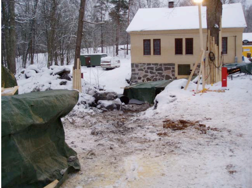
Figur 7. Schaktningar på västra sidan om kvarnen vid den nedre dammens norra ände. Foto från sydväst.
