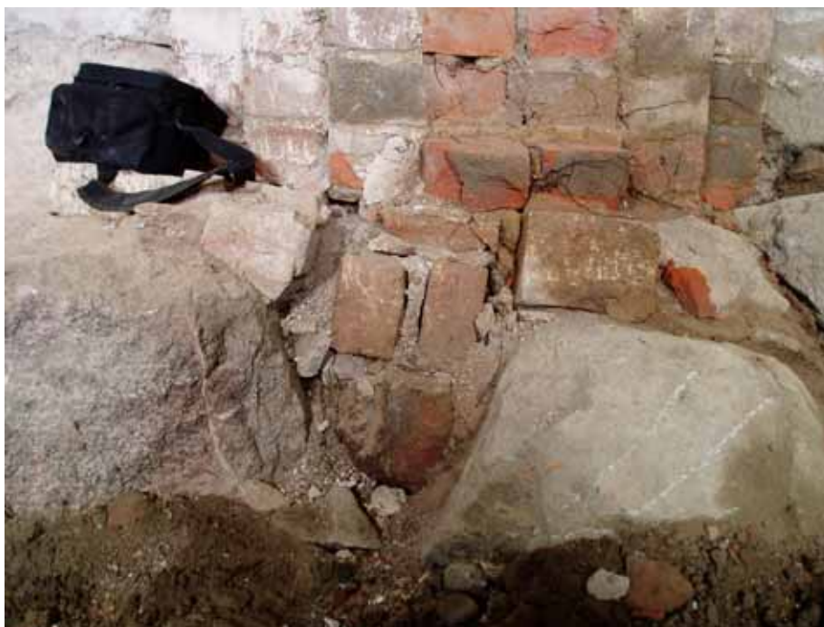
Figur 8. I bildens nedre del syns gravkammarens nordvästra hörn inklämt på snedden mellan pelarefundament och själva pelaren. Vy från söder.
