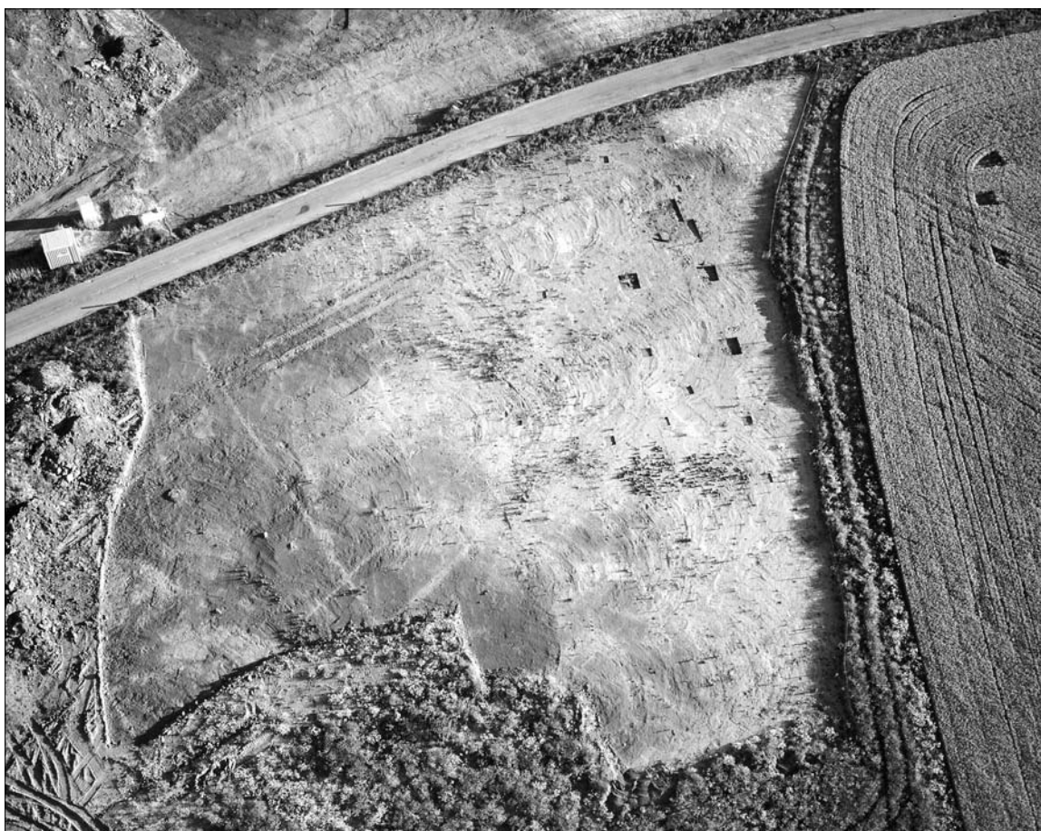
Figur 12. Flygfoto av delområde B efter schaktning. Foto: Hawkeye Flygfoto.
