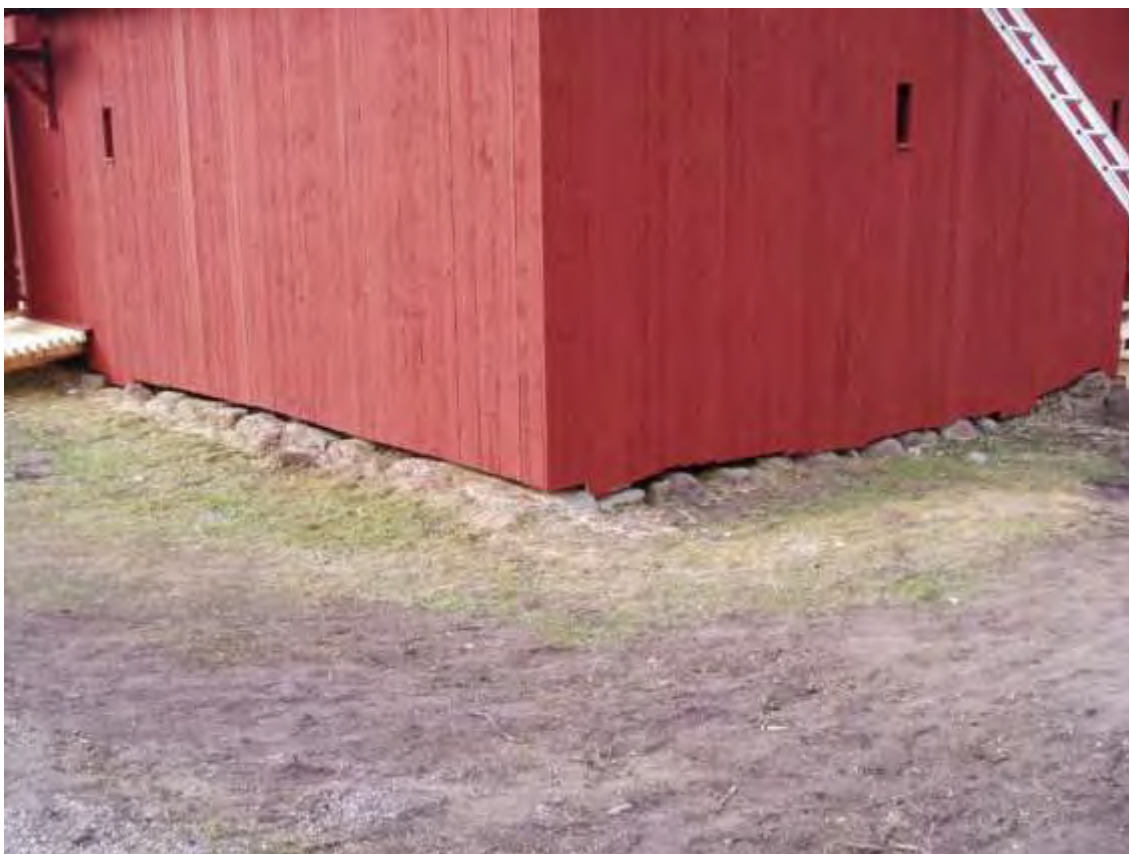
Figur 19. Byggnaden klar och rödfärgad. Grundläggningen på dolda plintar syns inte och byggnaden tycks ligga helt och hållet på den äldre stengrunden.
