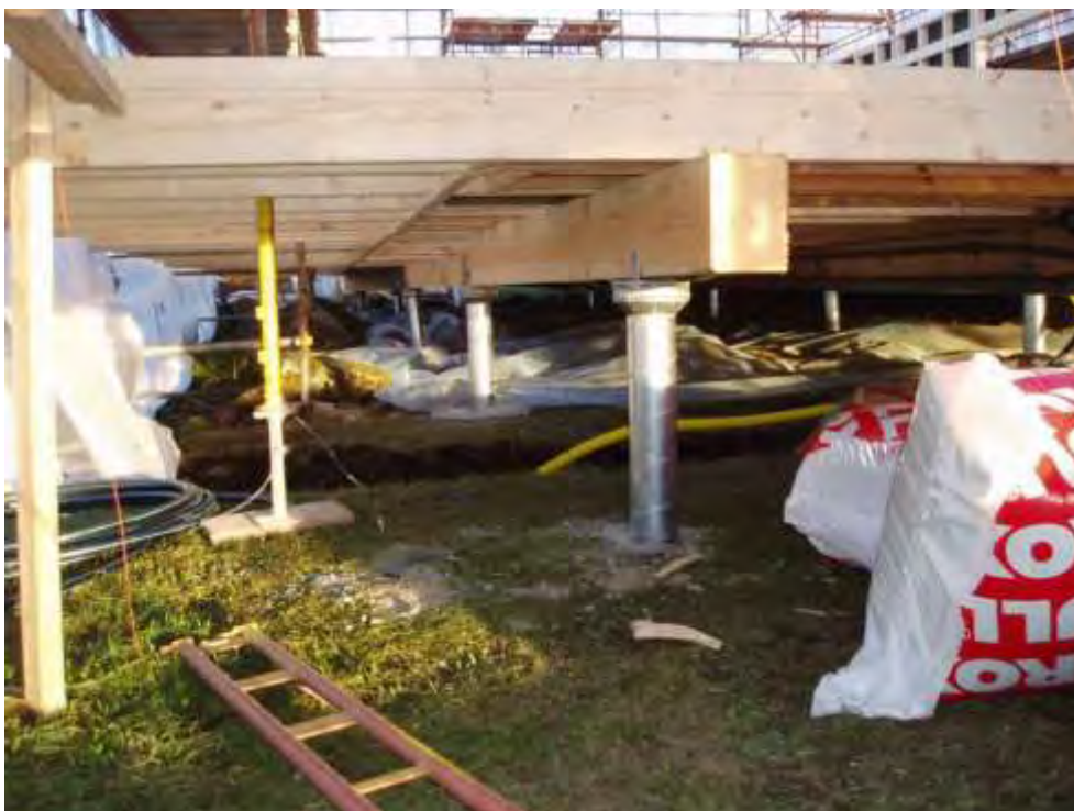
Figur 14. Krypgrunden under servicebyggnaden. Här syns tydligt hur huset vilar på de nya plintarna.
