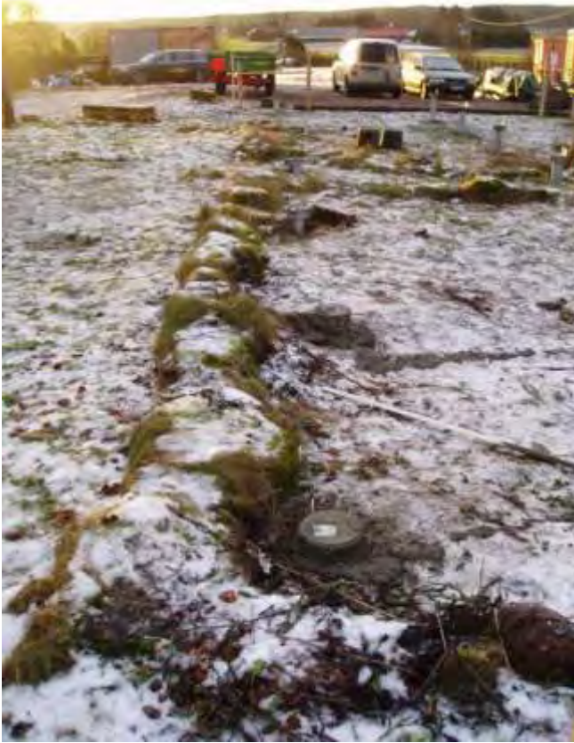
Figur 12. Östra långsidan med äldre grundmur och de nya plintarna placerade på insidan om dessa.
