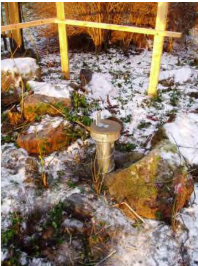
Figur 13. Nordvästra hörnet där en av plintarna hamnat mellan stenarna i den äldre grunden. Här som på alla andra platser genomfördes anläggandet av de nya plintarna varsamt utan att skada
