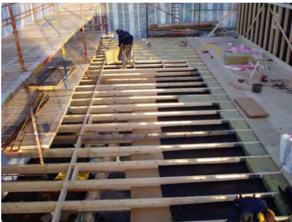
Figur 14. Krypgrunden under servicebyggnaden. Här syns tydligt hur huset vilar på de nya plintarna.
