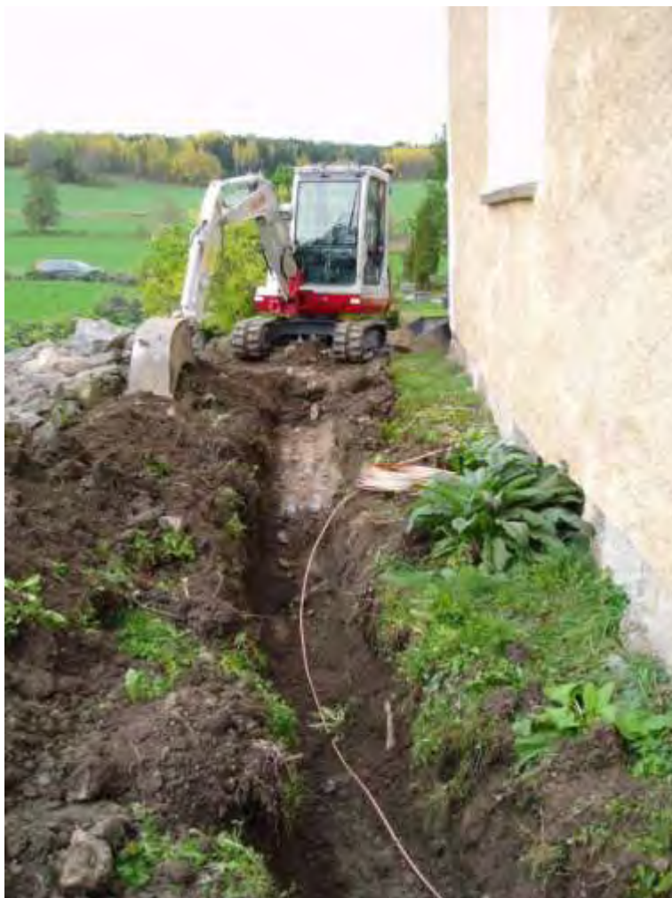
Figur 5. Schaktet för åskledare på östra sidan om kyrkan.
