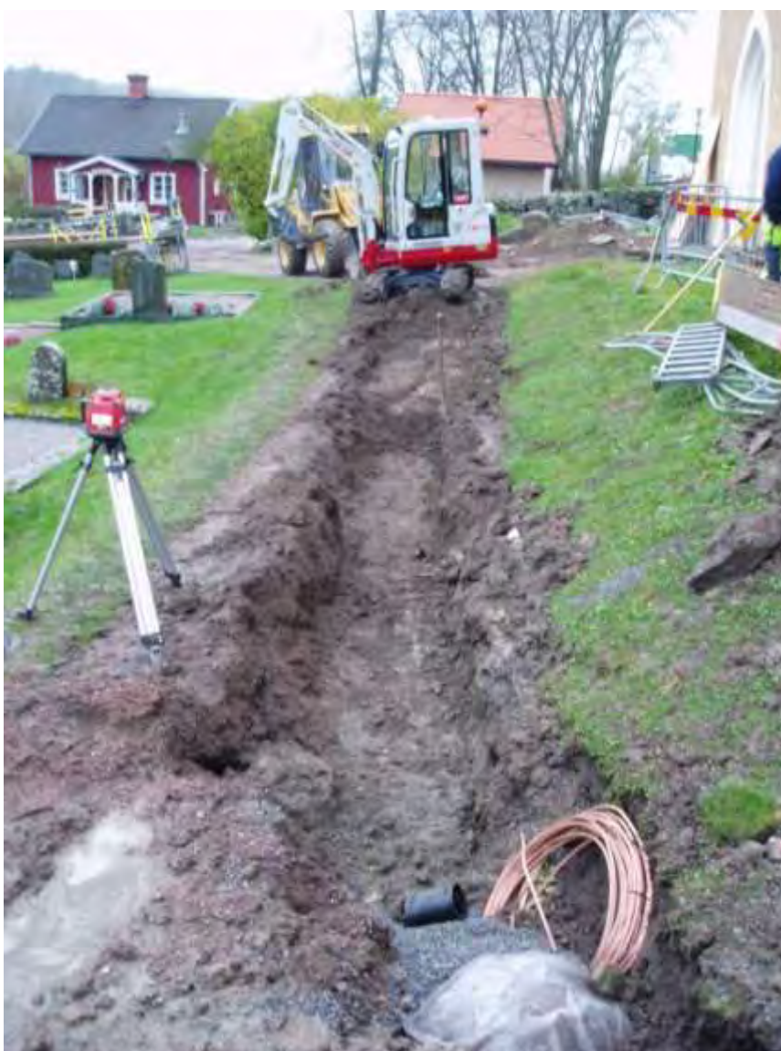
Figur 7. Dagvattenschaktet söder om kyrkan sett från öster. Strax bakom spaden finns ett antal av de stenar som utgjort begränsningen för den stödmur som varit yttre begränsning för jordbanken som ligger mot kyrkans sydvägg.
