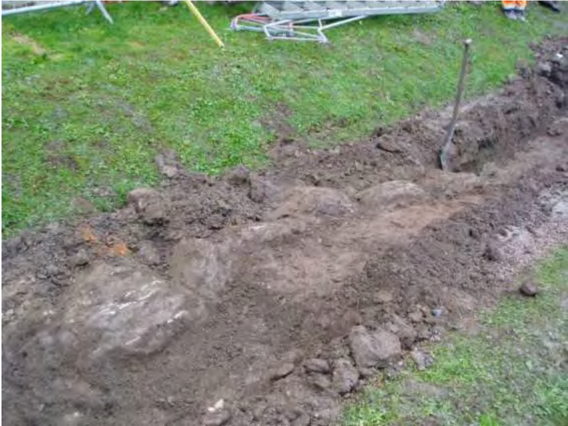
Figur 8. Detalj av stenarna i störmuren, sett från sydväst.
