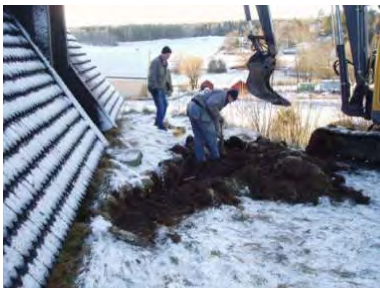
Figur 6. Den första delen av elschaktet från klockstapeln ner mot kyrkan. Klockstapeln ligger inom gravfältet Raä 71 , vilket medförde att även detta schaktningsarbete skedde under arkeologisk övervakning.
