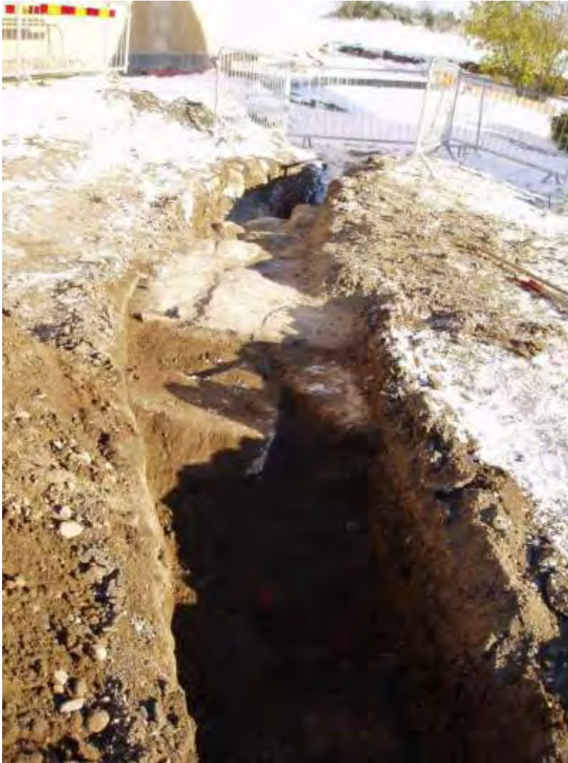
Figur 14. Samma schakt från sydväst. I förgrunden av schaktet åt väster fanns inga flera stenar som kan ha utgjort grunden till vapenhusets västra väggliv.
