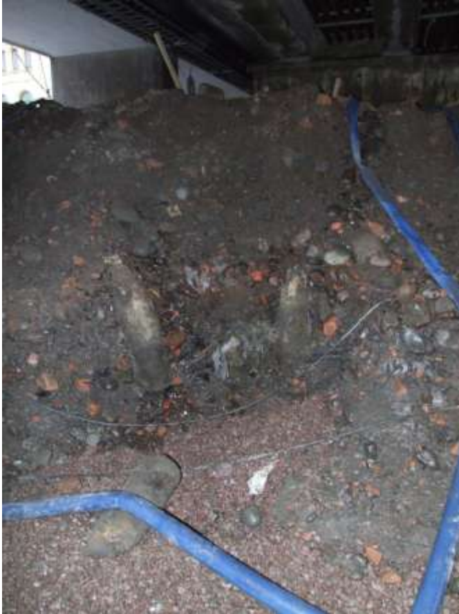
Figur 7. En av de mindre grupperingarna. Här syns hur stolphuvudet blivit skadat i samband med senare tids arbeten. Möjligen vid uppförandet av den nuvarande bron.
