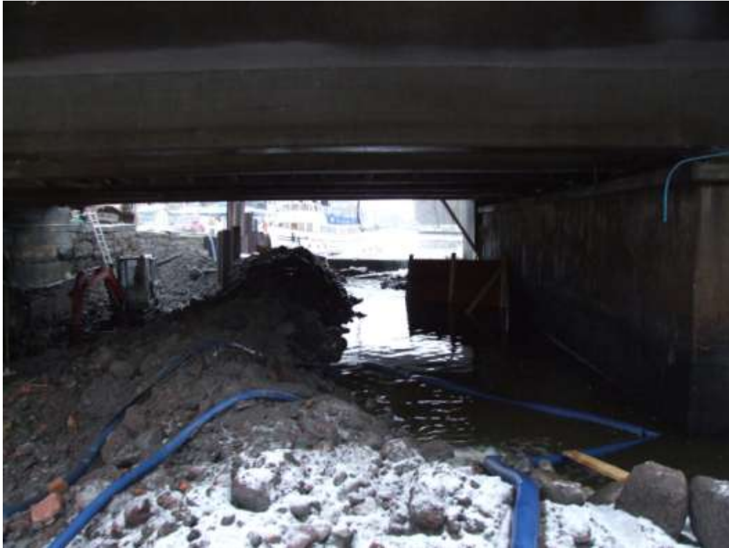
Figur 4. Schaktning och planering vid brofästets östra sida. Vattnet leds förbi arbetsplatsen efter det att spontning och tätning gjorts.
