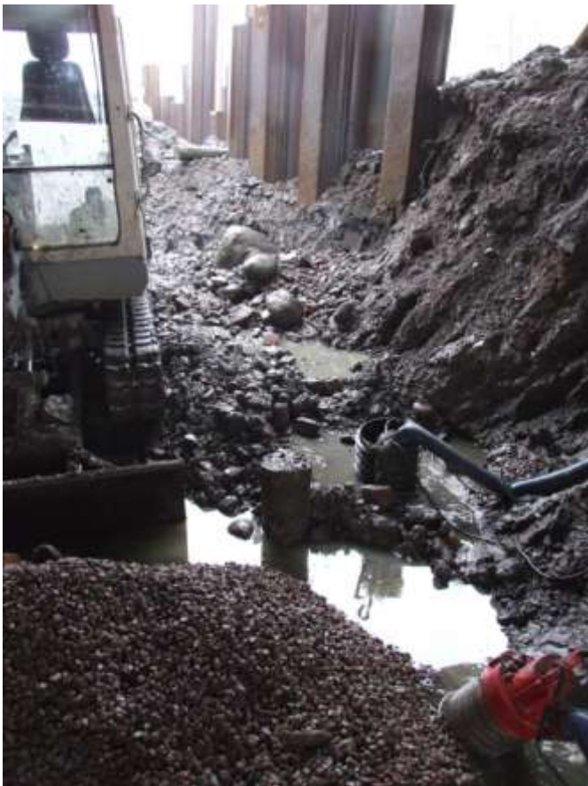
Figur 8. En fristående stolpe med avkapad plan topp.
