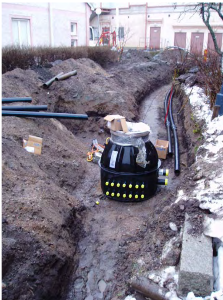
Figur 8. Foto av schaktet mot väster där schaktet utvidgades för att en fördelningsbrunn skulle få plats.
