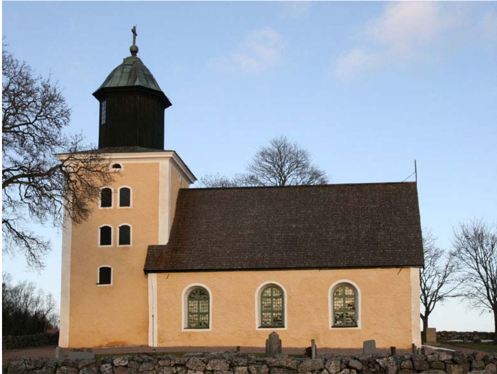
Kyrkan sedd från söder efter avslutad renovering.
