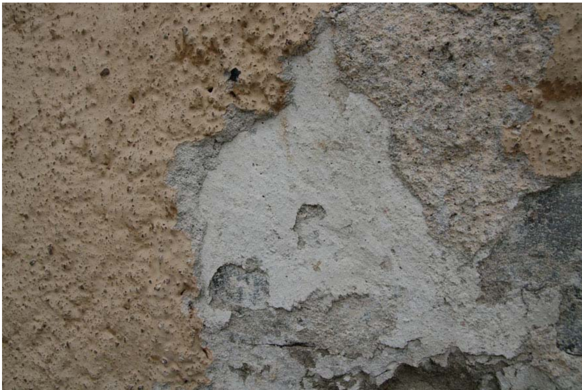
Under den nuvarande spritputsen finns ett äldre spritputsskikt med en svagt ockratonad färg. Här ses även en ljus slätputs under den äldre spritputsen.
