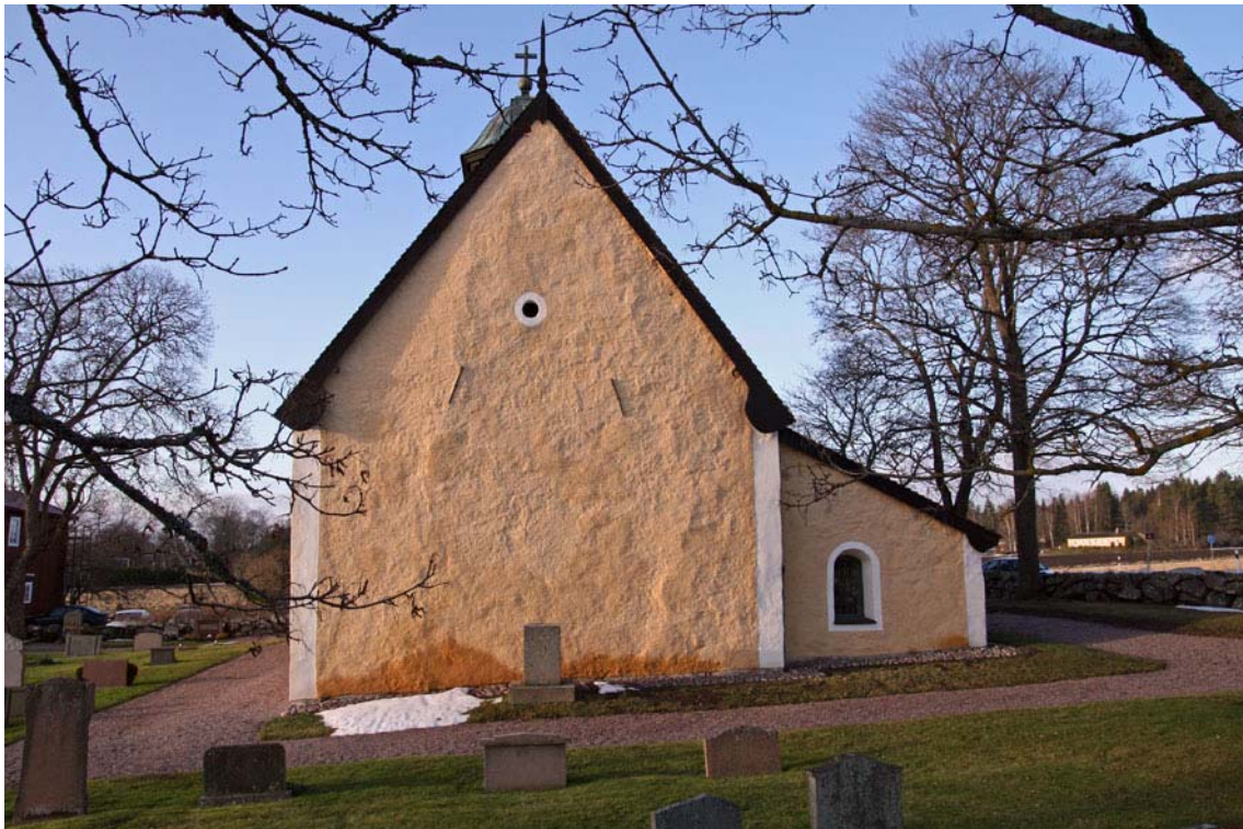
Kyrkans östra fasad efter avslutad renovering.
