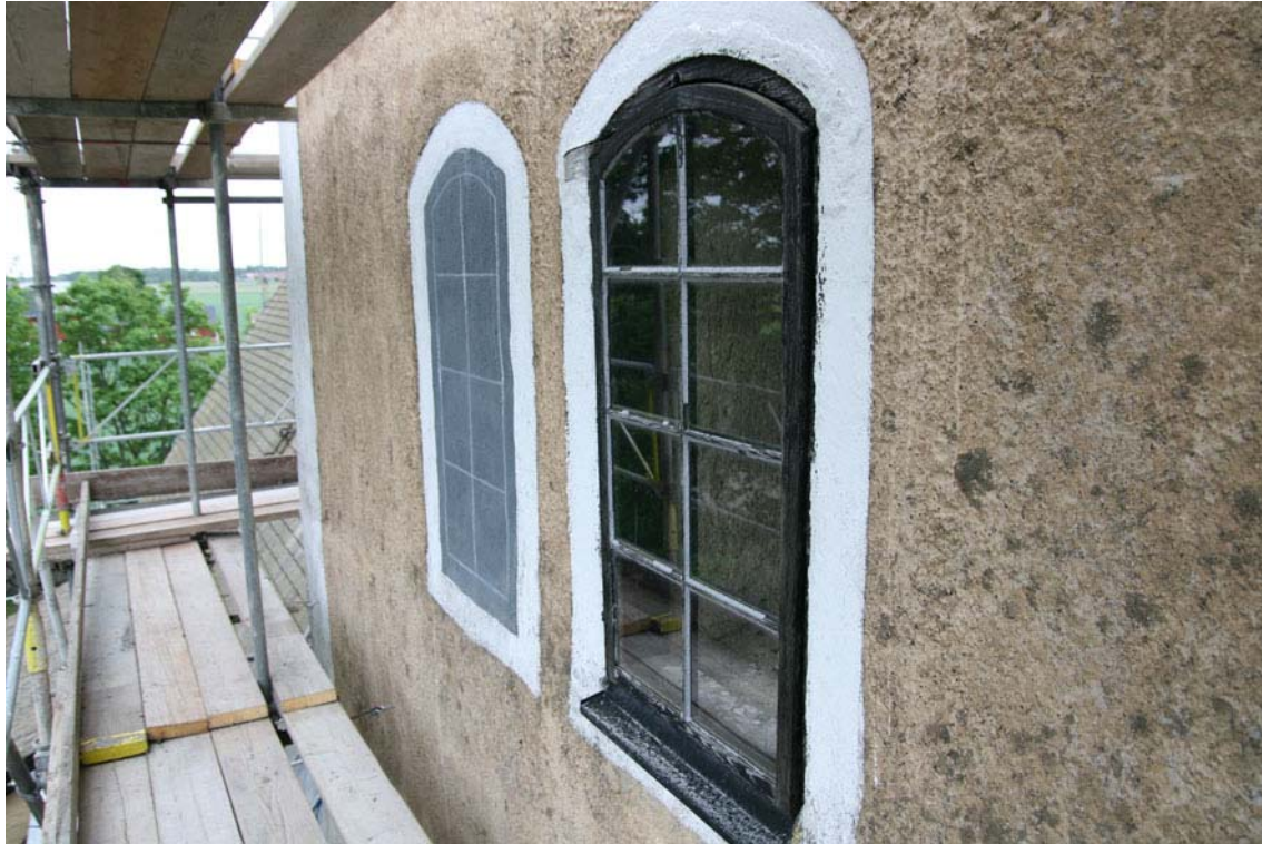
Blindfönster målat direkt på putsen samt tjärad fönsterbåge på tornets norra sida.
