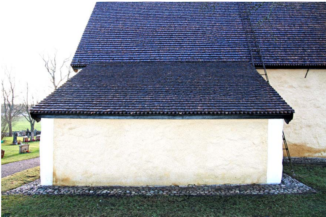
Spåntaket renoverades under november. Här ses sakristians tak och norra långhustaket med nylagda spån.
