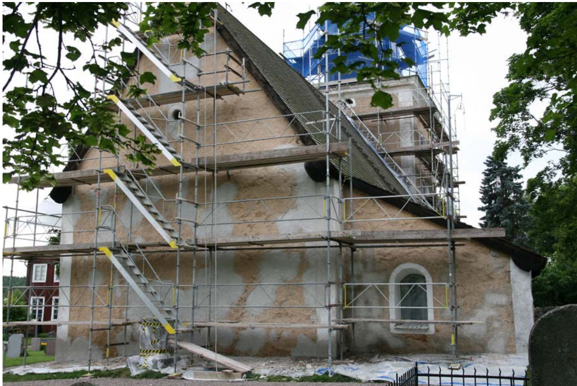
Bild av korgaveln och sakristians östfasad som visar omfattningen av putsläggningarna.
