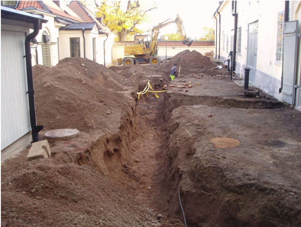
Figur 6. Dagvattenschaktet på stallgården. Från väster 2008-10-08.
