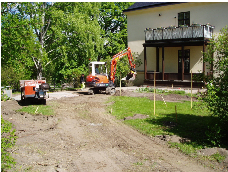
Figur 8. Anläggande av gräsrunnel i anslutning till verandan. Från sydväst 2009-05-14.
