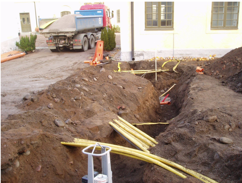
Figur 7. Dagvattenschakt mellan stallgården och östra flygeln. Från söder 2008-10-10.
