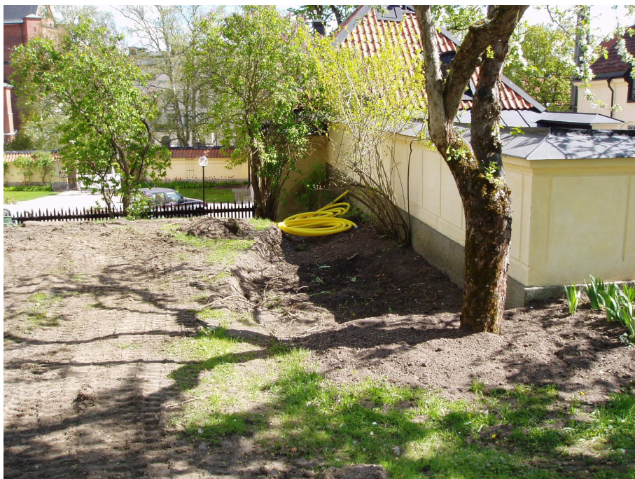
Figur 9. Nedläggning av elrör för belysning längs med muren mot stallgården. Från väster 2009-05-14.
