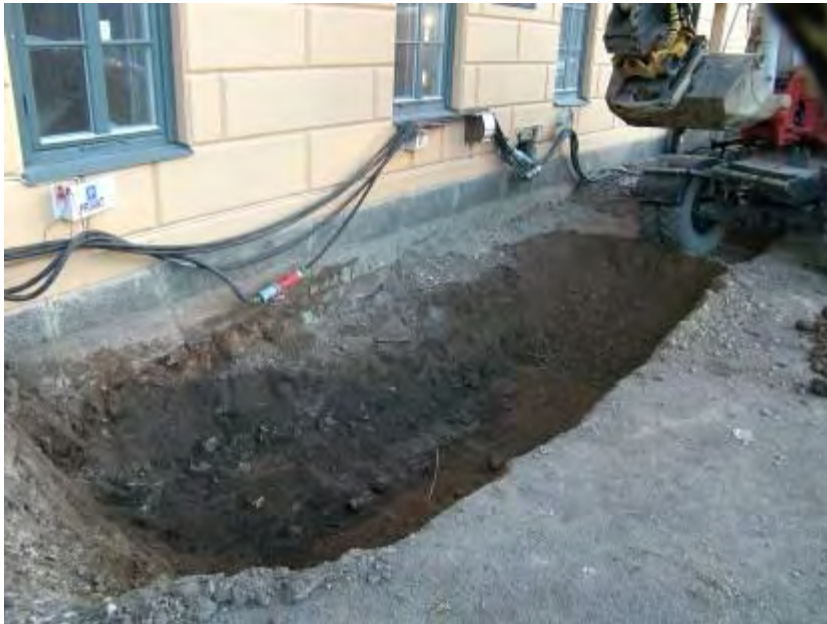
Figur 6. Den första etappen av de utvändiga schaktningarna. Foto från sydväst.
