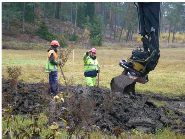
Figur 10. Lena Sundin och Robin Lucas under den mycket blöta schaktningen av yta 23. Vy från söder. Foto: Malin Lucas, Upplandsmuseet.
