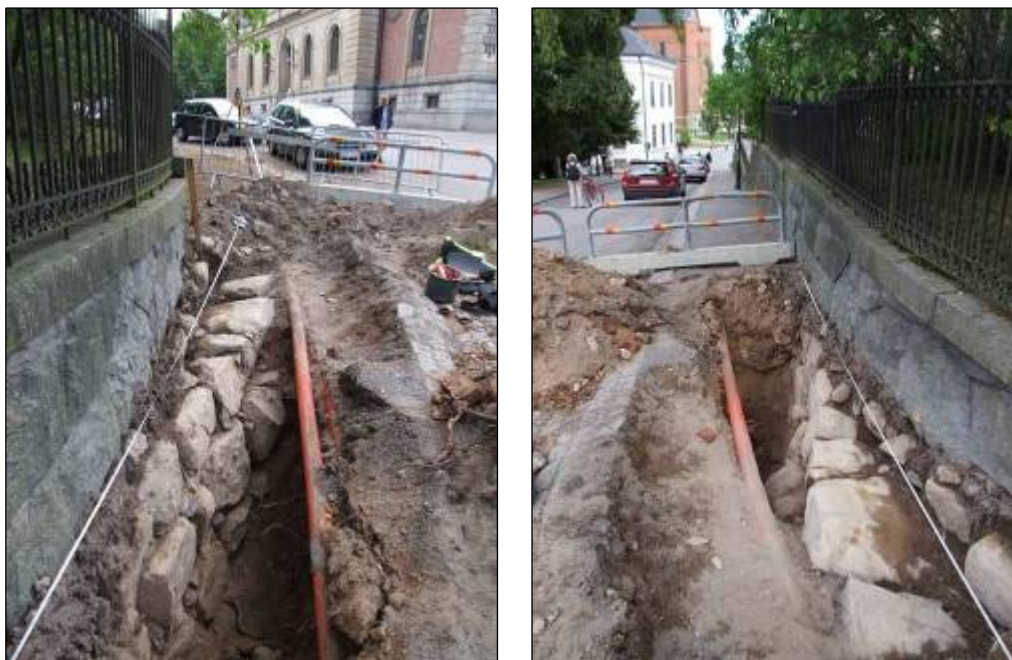
Figur 49 (tv). Påträffad mur i fundamentsgrop i schakt 9. Muren är troligen en del av ärkebiskopsborgens södra rundel. I bakgrunden skymtar universitetshusets södra gavel. Foto mot väster, Anna Ölund Upplandsmuseet.
