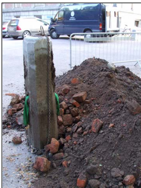
Figur 20. Betongfundament för belysningsstolpe vilka grävdes ned kring universitetshuset. Denna vid schakt 3. Foto mot norr, Anna Ölund, Upplandsmuseet.
