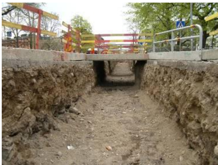
Figur 7. Den östra delen av ledningsschaktet. Moderna fyllnadsmassor och omrörda lager syntes längs schaktväggarna. Foto från sydväst.
