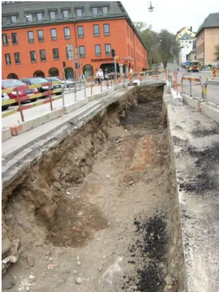
Figur 8. Översiktsbild över den västra delen av schaktet. Foto från nordöst.
