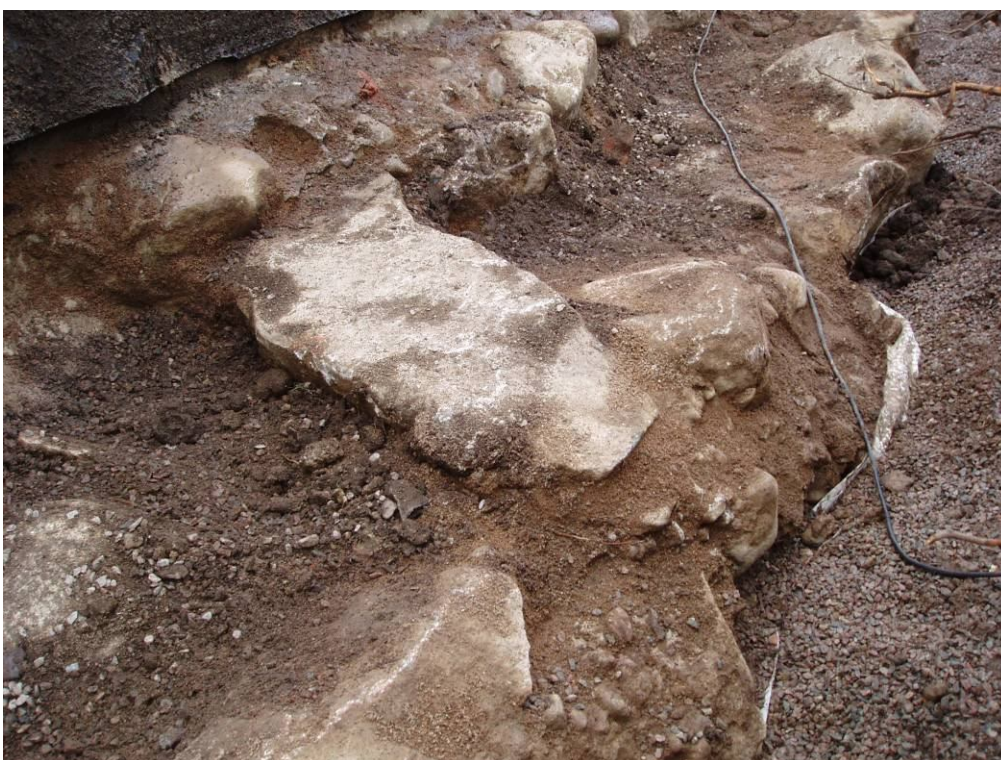
Figur 15. Detalj av grundmuren vid 9 meter.
