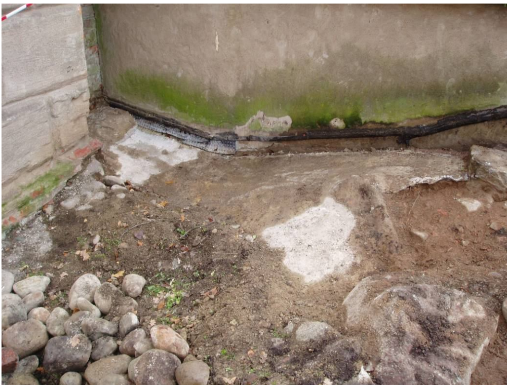
Figur 14. Södra delen med kvarvarande betongsula.
