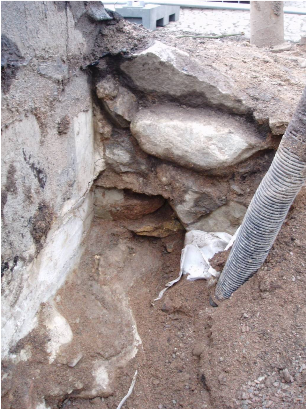
Figur 17. Detalj av den tvärgående muren vid 19 meter. Till vänster i bild syns ett dräneringsrör som troligen ligger parallellt under gruset öster om grundmuren.
