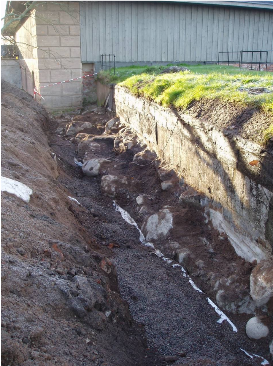
Figur 6. Den 1 november schaktades resterande fyllnadsmassor bort från den östra väggen. Dagen efter dokumenterades de grundstenar som kom fram i schaktet. Foto (fr. N).
