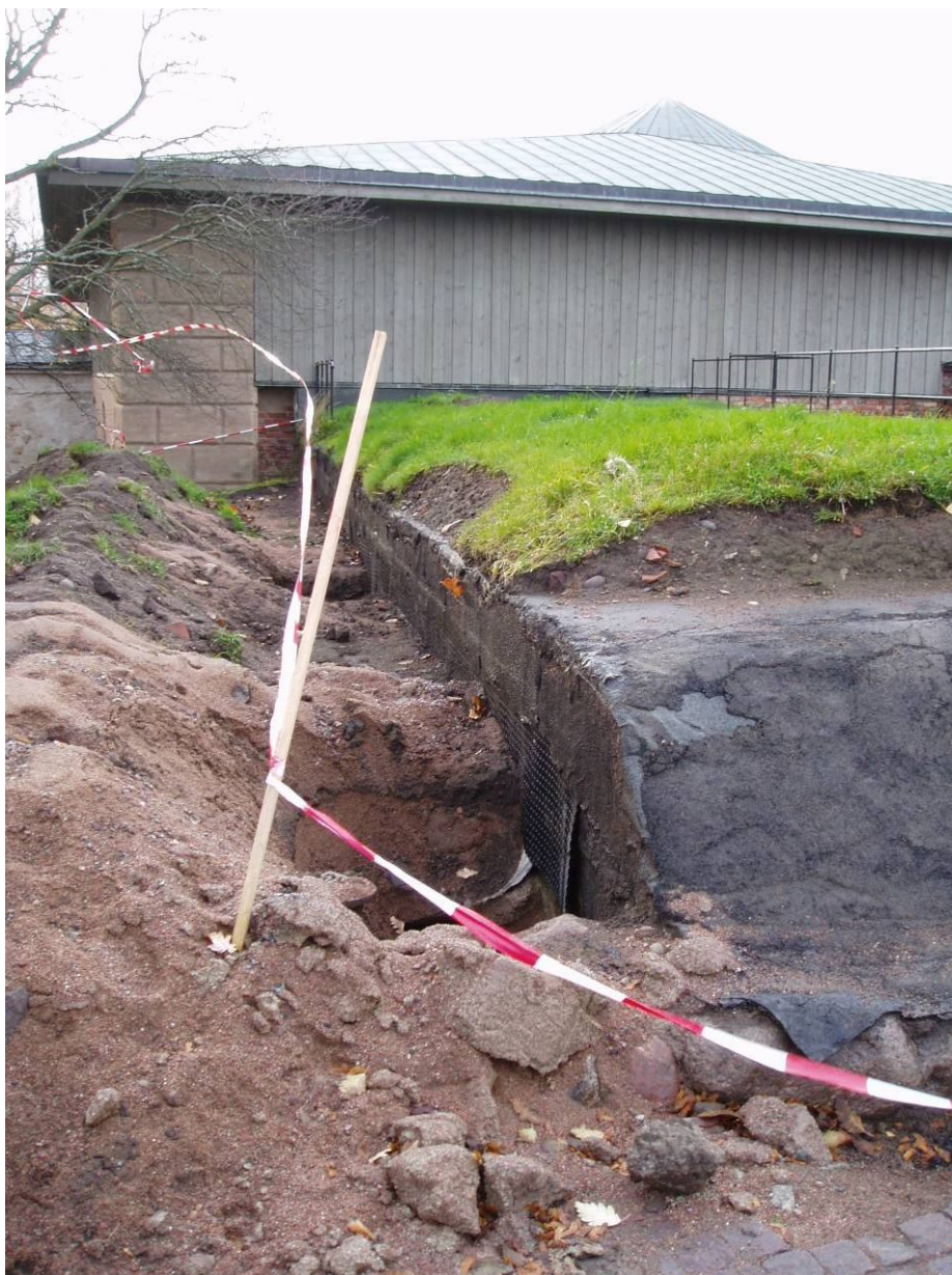
Figur 5. Den 28 oktober hade man schaktat av matjordslagret på norra delen av kurtinmuren och frilagt övre delen av den östra väggen. Foto (fr. N). I bildens framkant syns ett par stenar som kan utgöra en tvärgående mur med riktning åt öster.
