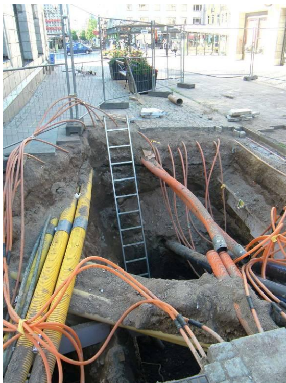
Figur 8. Schakt för VA-ledningar samt för fjärrkyla i hörnet Svartbäcksgatan – Påvel Snickares gränd. På fotot ses grop 2 fotograferat mot SSÖ och Stora torget av Joakim Kjellberg, Upplandsmuseet.
