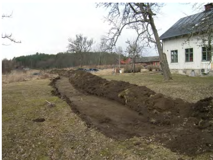
Figur 12. Sträcka A under avbaning. Här syns bl a grusgången A8/A9 som ett upphöjt stråk. Foto från sydöst.
