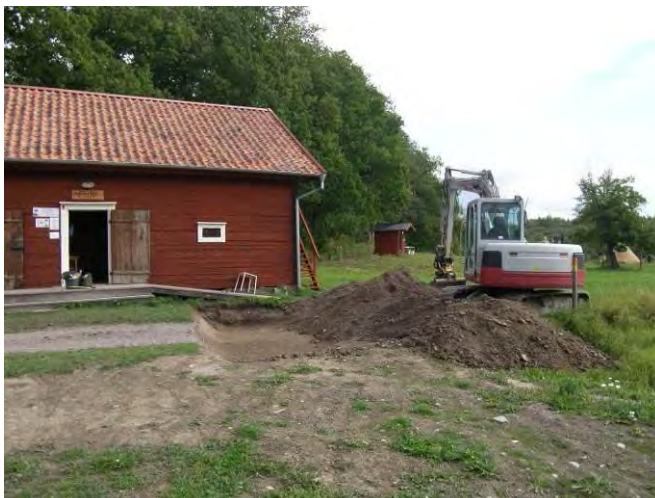
Figur 9. Kompletterande schaktningar i september 2009. Schaktet in till den så kallade Äppelboden (sträcka F). På de igenlagda schakten från april har gräs och ogräs börjat spira. Foto från öster.
