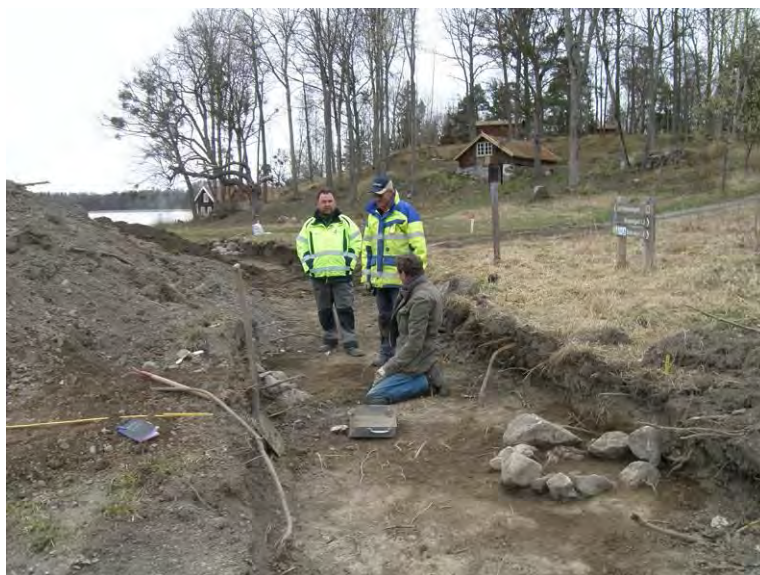
Figur 19. Lars G Henricson undersöker A60 med Dan Fagerlund och grävmaskinisten från AddSchakt som åskådare. I förgrunden syns A59, ett stort stenskott stolphål, i plan. Foto från söder.
