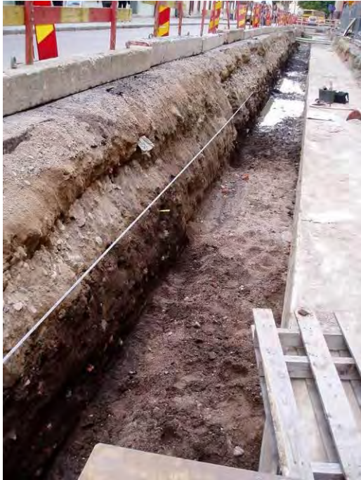
Figur 12. Schaktet vid ca 48 m och söderut.
