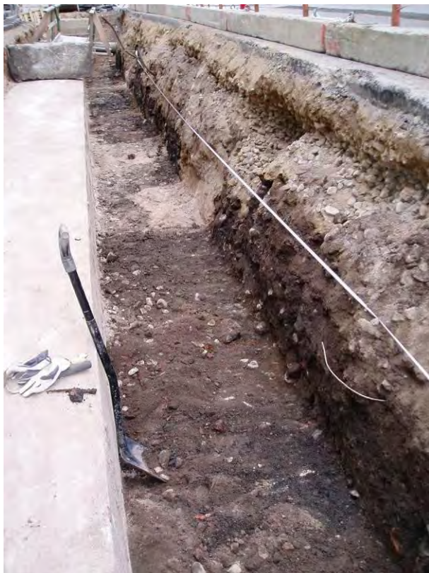
Figur 11. Schaktet vid ca 38 m och norrut. I botten syns det understa sand- och grusskiktet med kullerstenar. Troligen representerar detta en yta som varit öppen, kanske en gårdsplan.
