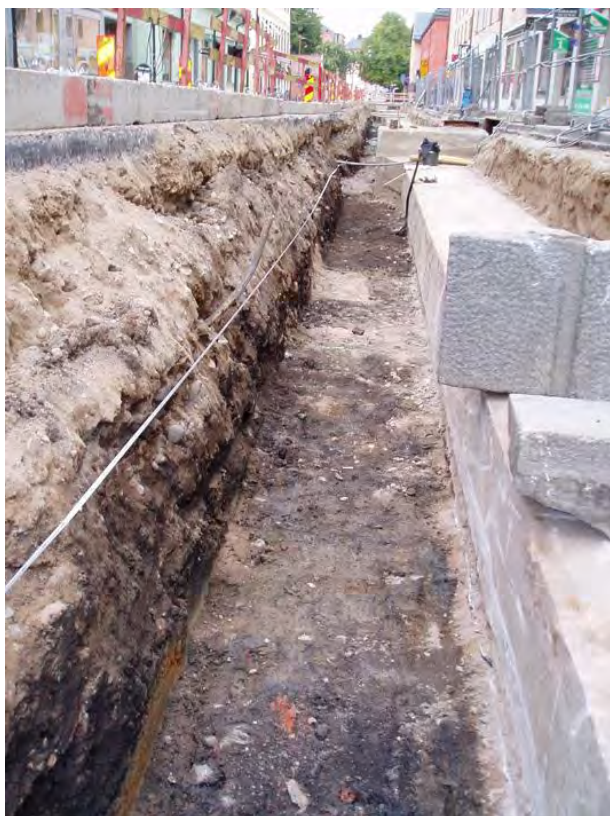
Figur 9. Schaktet vid ca 25 m och söderut.
