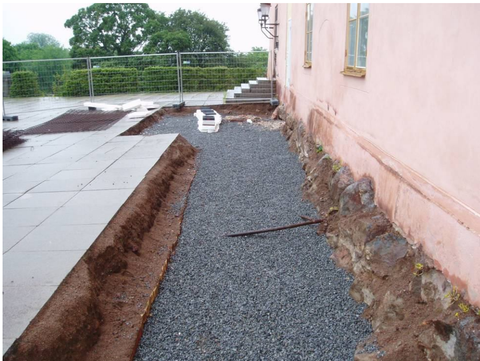
Figur 5. Efter avslutad schaktning grusades ytan innan gjutning för rampen påbörjades. Den äldre trappan är ännu inte riven. Foto mot norr, 2011-06-23.
