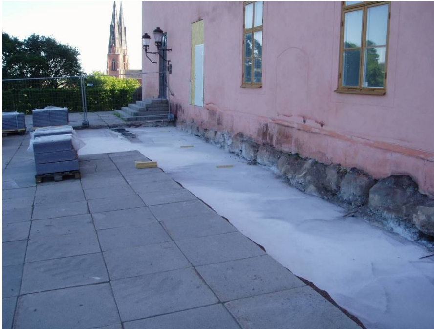
Figur 6. Gjutning av botten utförd. Foto mot norr, 2011-06-30.
