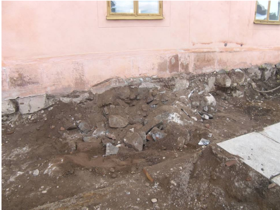
Figur 17. När stenarna i anläggning A schaktades bort kunde man se att detta fundament var kraftigt uppbyggt med flera stenar emellan de större synliga. Foto mot öster, 2011-06-20.
