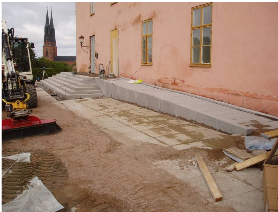
Figur 7. Rampen och den nya trappan färdiga. Återstår en del plattläggning, räcken och byte av dörrar. Foto mot norr, 2011-08-23.
