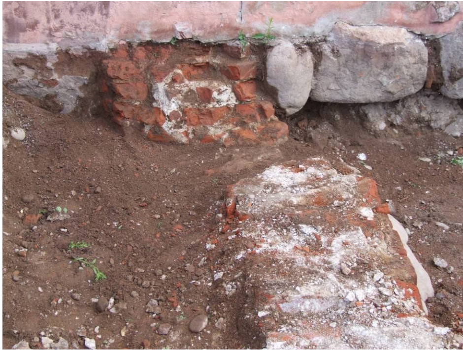
Figur 24. Detalj av tegelväggens anslutning till långhusets väggliv. Foto mot öster, 2011-06-21.
