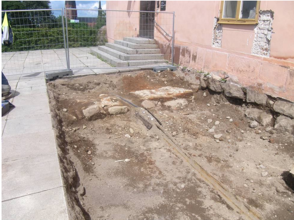
Figur 20. Anläggning B, grundmur. Foto mot norr, 2011-06-20.
