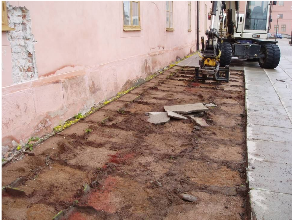
Figur 4. Plattorna har lyfts bort innan schaktningen börjar. Foto mot söder, 2011-06-14.
