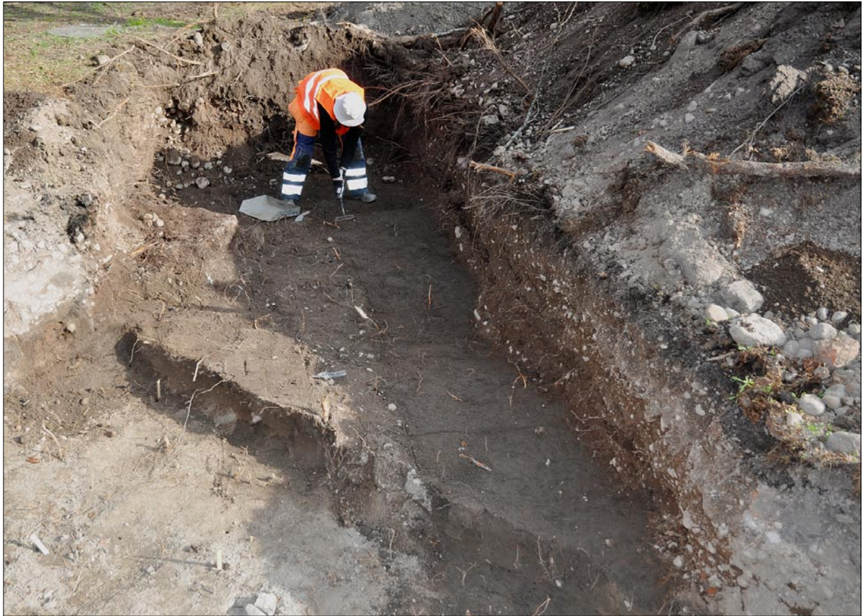
Figur 68. Rensning av lager 1368 pågår i schakt 641. Lagret var genomskuret av ett recent dike, men i övrigt väl bevarat. Längs schaktets kanter syns de ställvis tjocka fyllnadsmassorna. Foto från söder: Anton Seiler, RAÄ (U4480_28).
