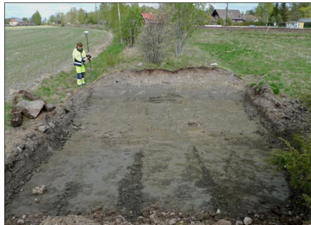
Figur 118. Schakt genom den äldre banvallen visade att denna anlagts ovanpå befintlig matjord. Därunder fanns bevarade anläggningar. Foto från söder: Jonas Wikborg, SAU (U4479_4).
