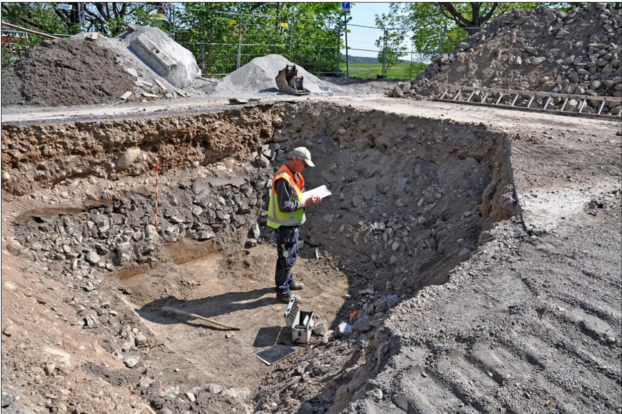
Figur 74. De tjocka fyllnadsmassorna under Groaplan krävde att schaktens kanter fick släntas av ordentligt. Foto från sydväst: Anton Seiler, RAÄ (U4480_89).
