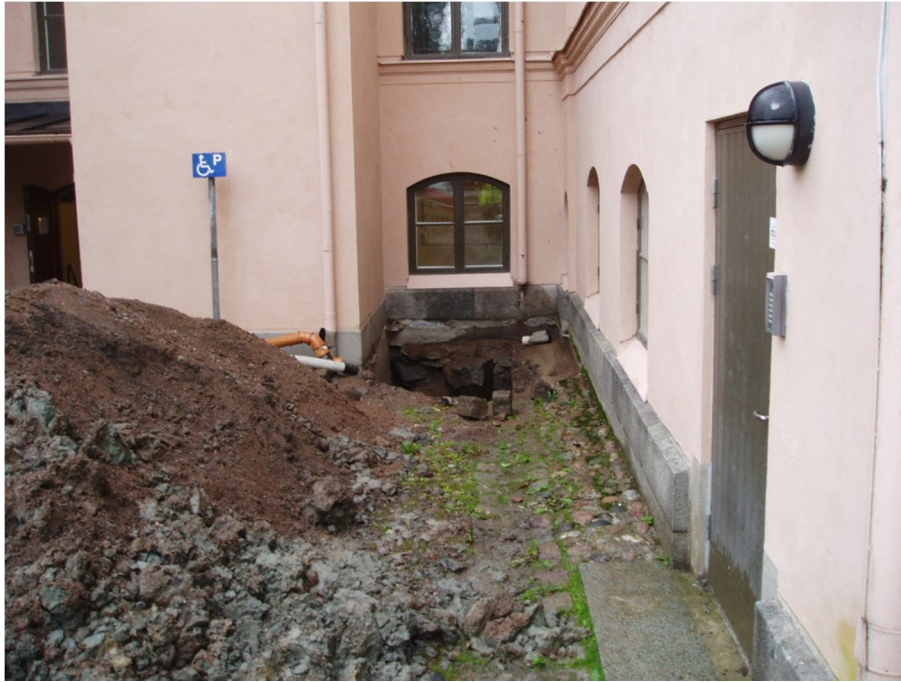
Figur 26. Grop E efter urschaktning. Foto 2011-09-06, mot sydost.
