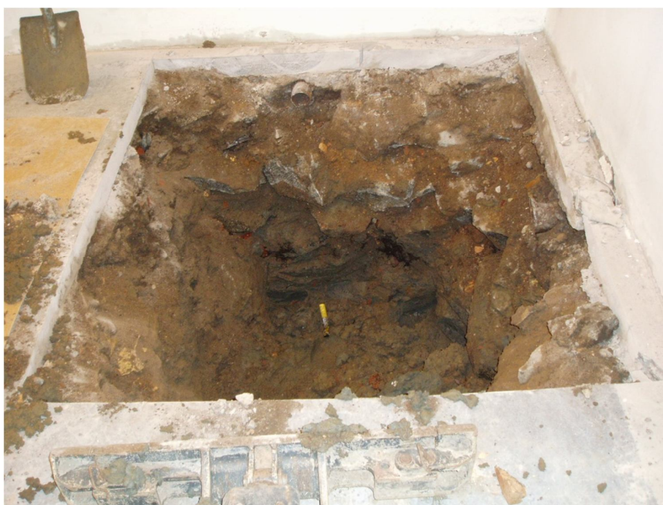
Figur 32. Grop E utschaktad en dryg meter. Grundstenar till hjärtväggen syns i mitten. Foto 2011-09-06, mot nordost.
