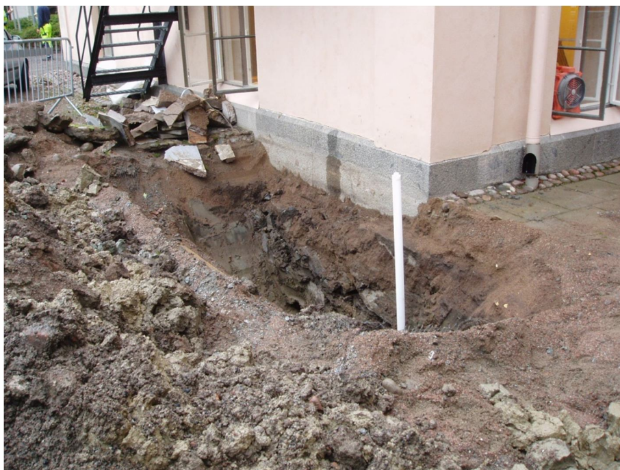
Figur 21. Grop D fotad mot öster. I södra delen av schaktet syns det kontrollrör för grundvattennivån som sattes ned. Foto 2011-09-06.
