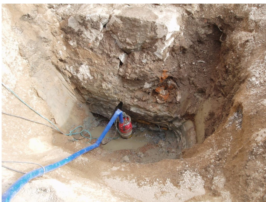
Figur 18. Grop C. Under grundmuren skymtar rustbädden av liggande timmer. Sandfyllningen närmast i bild kommer från ett nedgrävt schakt för avlopp. Foto mot nordost, 2011-09-02.
