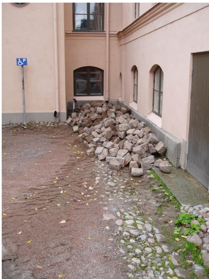
Figur 28. Platsen för grop E efter återfyllning. Gatstenar har lagts upp inför framtida återanvändning. Foto mot sydost, 2011-09-13.
