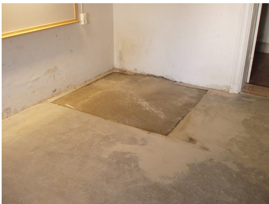
Figur 34. Platsen för grop F efter återfyllnad och gjutning av nytt golv. Foto mot öster, 2011-09-14.
