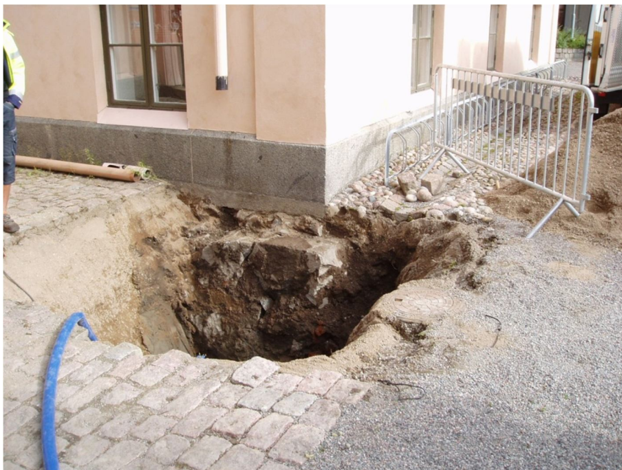
Figur 16. Grop C invid sydvästra hörnet till hus B. Foto mot nordost, 2011-09-02.
