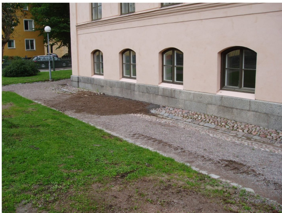
Figur 10. Platsen för grop A efter återfyllning. Foto mot väster, 2011-09-13.
