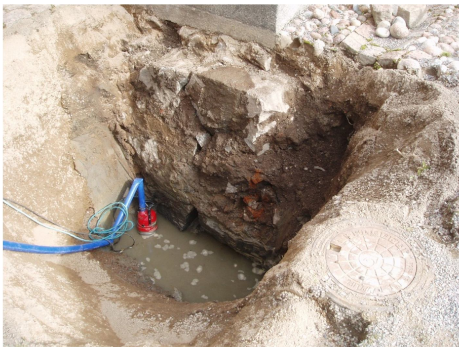
Figur 17. Grop C där grundvattnet trängde fram hela tiden. På bilden syns den kraftiga grundmuren. Foto mot nordost, 2011-09-02.
