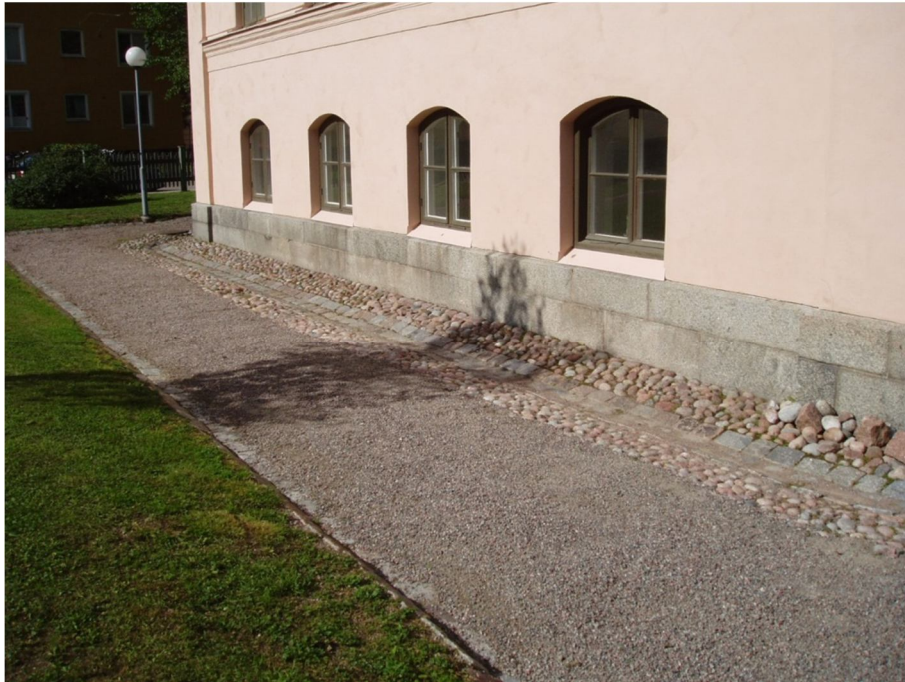
Figur 6. Platsen för grop A innan denna togs upp. Foto 2011-08-31, mot väster.
