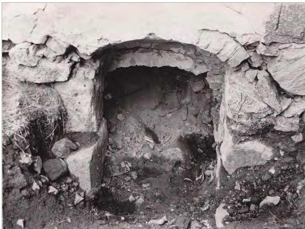
Figur 9. Blottlagd ingång till sakristians källare den 15 juli 1941. Ingången fanns på den västra sidan av sakristian. Den sattes igen 1941 och kom senare att putsas över utan att markeras i putsen. Foto, sannolikt Nils Sundquist, Upplandsmuseet. Fotoarkivet.
