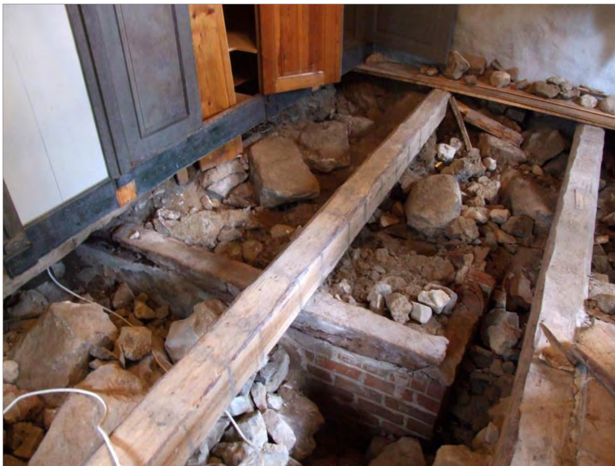
Figur 25. Den äldre sakristians västra mur samt ingången till källarrummet. Foto mot SV.
