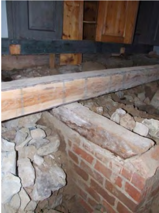
Figur 21. Den äldre sakristians västra källarmur (27) med tegelmurverk. Foto mot SV.
