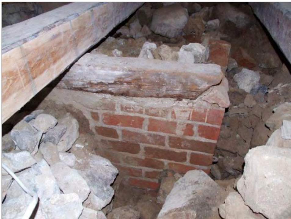
Figur 24. Den äldre sakristians västra källarmur (27). Observera dörrhaken vid tegelmurens högra kant. Foto mot V.
