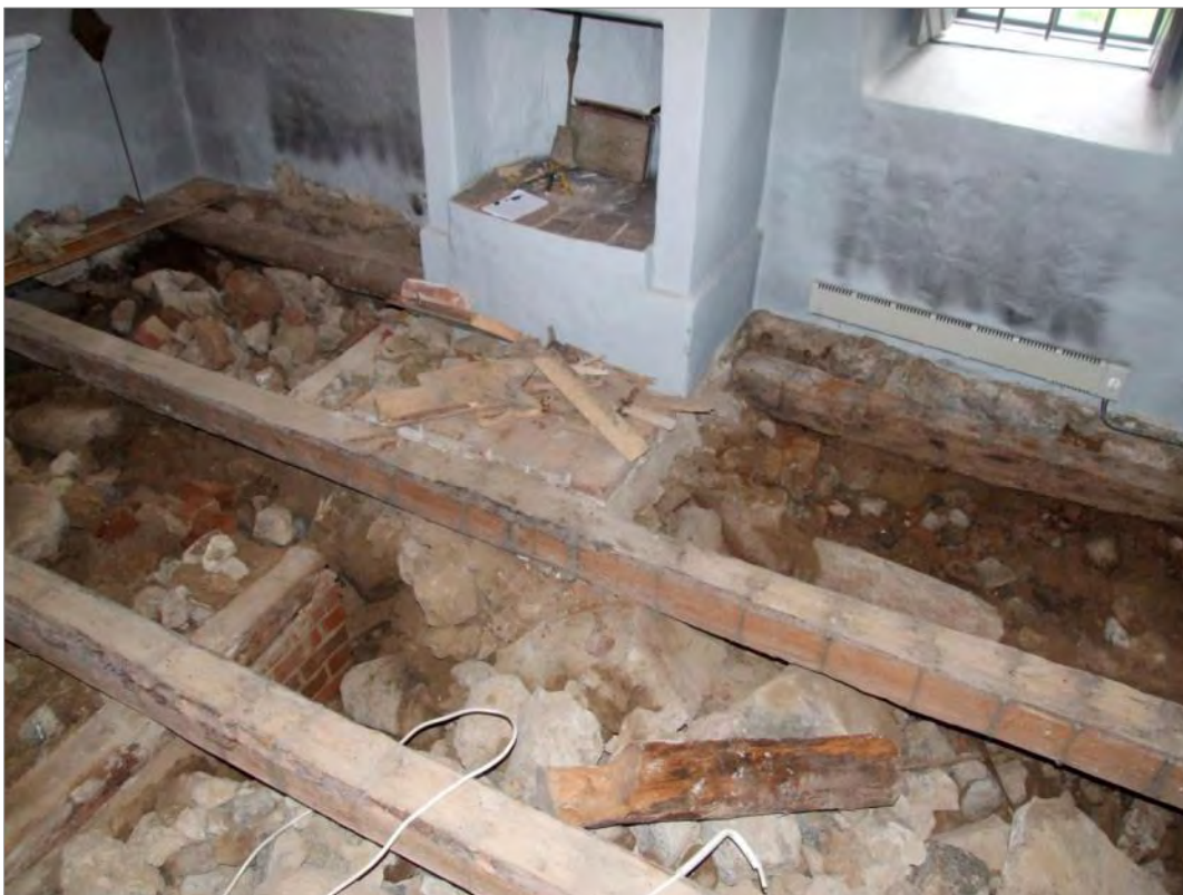
Figur 14. Sakristian efter avslutat torrsugsarbete. Foto mot NV.
