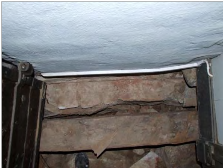
Figur 31. Västra delen av den äldre sakristians södra mur. Observera att muren fortsätter in under garderoben som ses till höger i bild. Foto mot S.
