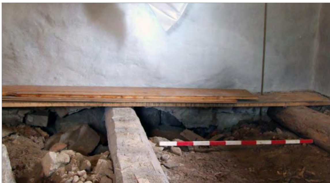
Figur 15. Igensatt äldre källaringång till sakristian i den västra ytterväggen. Foto mot V.
