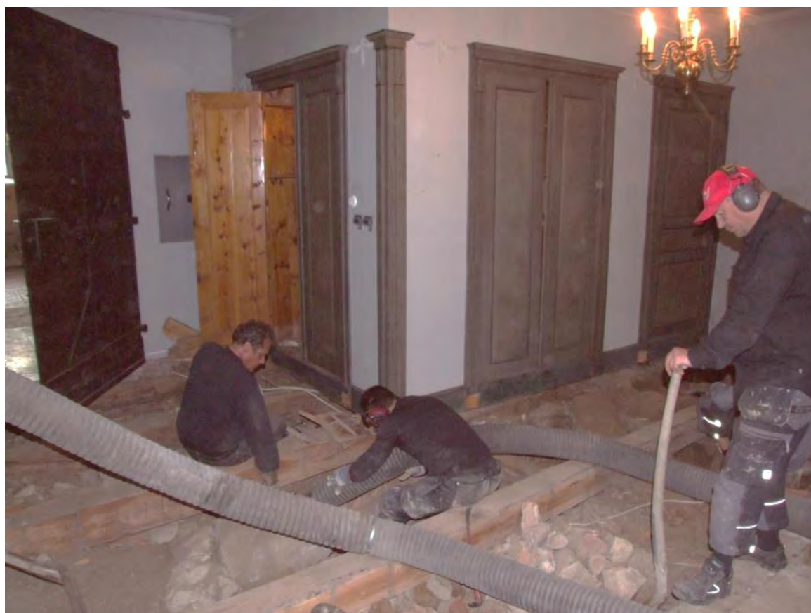
Figur 7. Fyllnadsmassorna i under sakristians golv avlägsnas med hjälp av en torrsug. Foto mot S.
