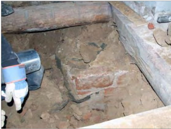
Figur 16 (t.v). Murverk från den äldre sakristians norra källarmur (26). Foto mot N. Figur 17 (t.h). Muren (26) var synlig ned till 1,1 m djup. På muren har den nya sakristians vägg byggts samt den öppna spisen. Foto mot NÖ.
