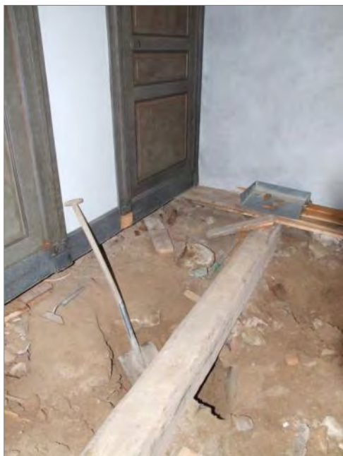
Figur 10. Provgrop 2. Provgroparna var svårgrävda p.g.a alla större stenar som fanns i fyllnadsmassorna samt alla golvbjälkar. Foto mot V.
