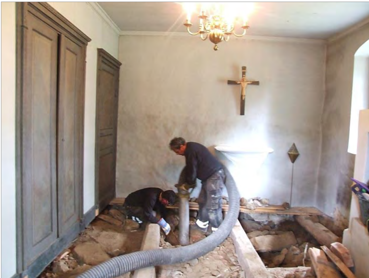
Figur 8. Allt material som är mindre än en knytnäve sugas lätt upp med hjälp av torrsugen. Foto mot V.
