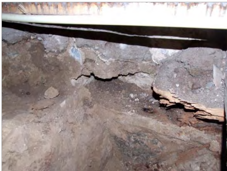
Figur 28. I sakristians nordöstra hörn sågs rester efter den träbjälke (31) som murats in i den norra källarväggen.
