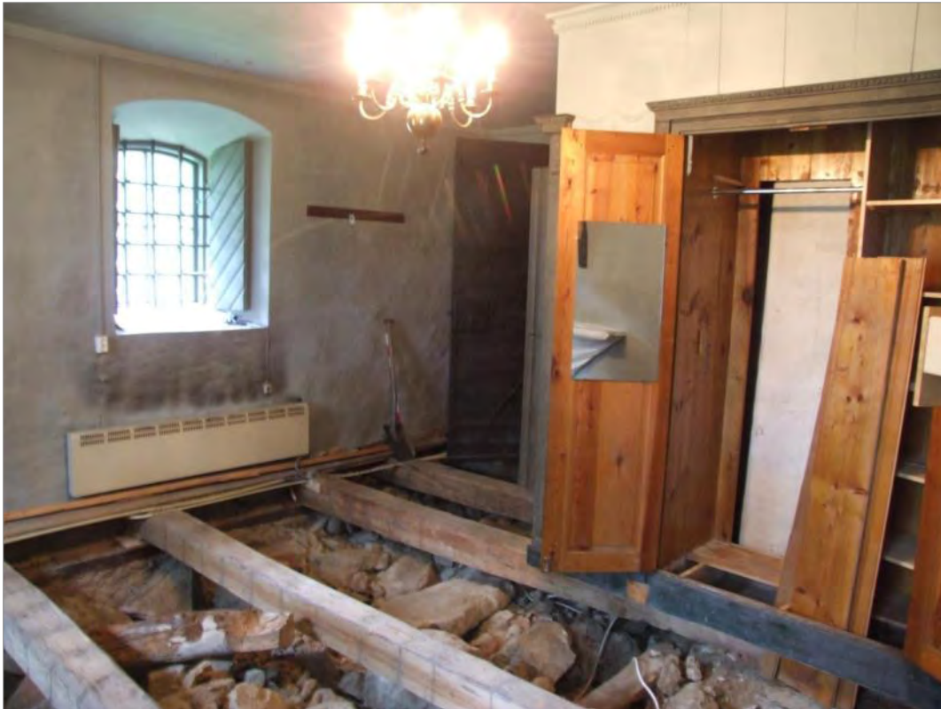
Figur 13. Sakristian efter avslutat torrsugsarbete. Av bilden framgår den på tidigare uppmätningar ej medtagna muren (28) bakom garderoben. Foto mot SÖ och sakristians ingång.
