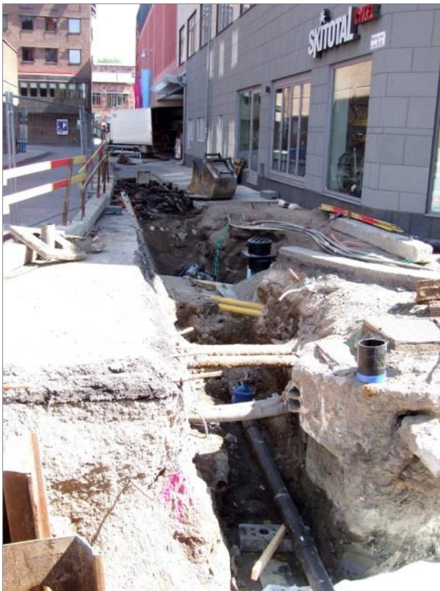
Figur 10. Schakt för fjärrvärme längs Smedsgränd. Foto mot NÖ och Kungsgatan.
