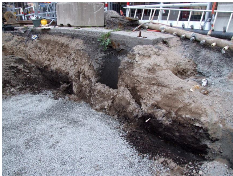
Figur 32. Sektion 5 i Dragarbrunnsgatan. Foto mot NNÖ.
