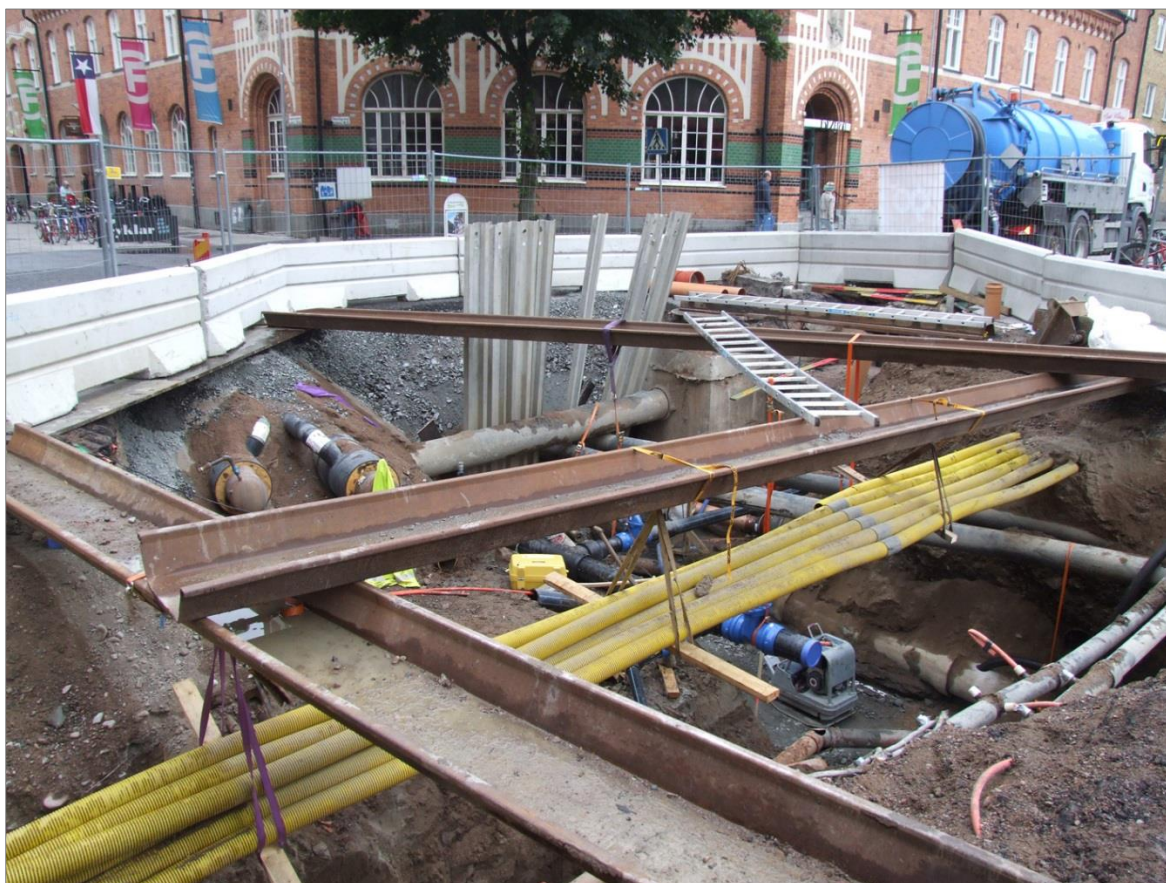
Figur 7. Schaktningsarbetet och den arkeologiska övervakningen försvårades avsevärt av alla äldre ledningsdragningar. På fotot framgår situationen i början av augusti vid korsningen Dragarbrunnsgatan-Smedsgränd. Foto mot S och Kv. Pantern.
