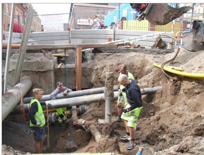
Figur 8. Del av arbetsstyrkan för schaktning och ledningsdragningar. Foto mot SV.
