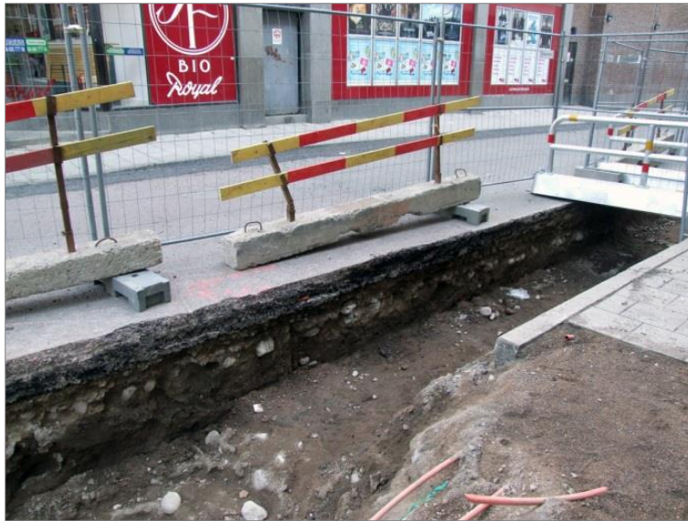
Figur 11. I schaktkanten i Smedsgränd framkom en äldre kullerstensläggning, troligen en äldre gatunivå. Foto mot N.
