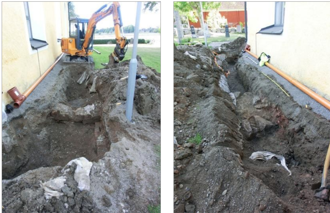
Figur 12. Den äldre sakristians östra grundmur i dagvattenschaktet på kyrkans norra sida. Foto mot V av Bent Syse, Upplandsmuseet.
