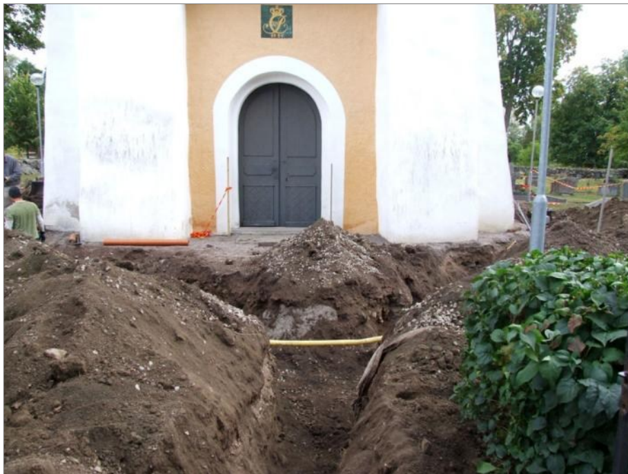
Figur 7. Arbetsbild över schaktet vid kyrkans torn. Foto från ingången, mot Ö av Anna Ölund, Upplandsmuseet.
