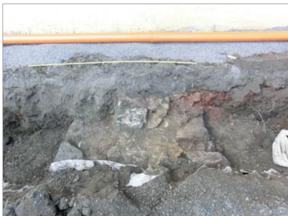
Figur 11. Den äldre sakristians västra grundmur. Foto mot S av Bent Syse, Upplandsmuseet.
