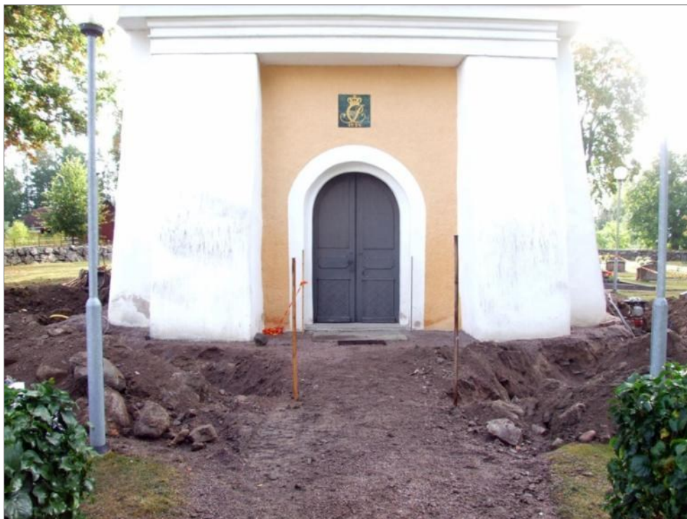
Figur 15. Åkerby kyrkas entré med dess strävpelarförstärkta torn. I schaktet runt tornet påträffades mycket stora stenar som sannolikt fungerat som grundförstärkning till tornet och strävpelarna. Foto mot Ö, Anna Ölund, Upplandsmuseet.
