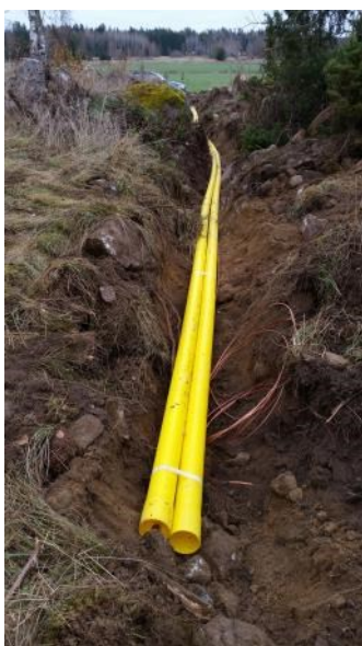
Figur 15. Schaktet söder om väg vid Rasbo 329:1-4. Foto mot öster, Bent Syse.
