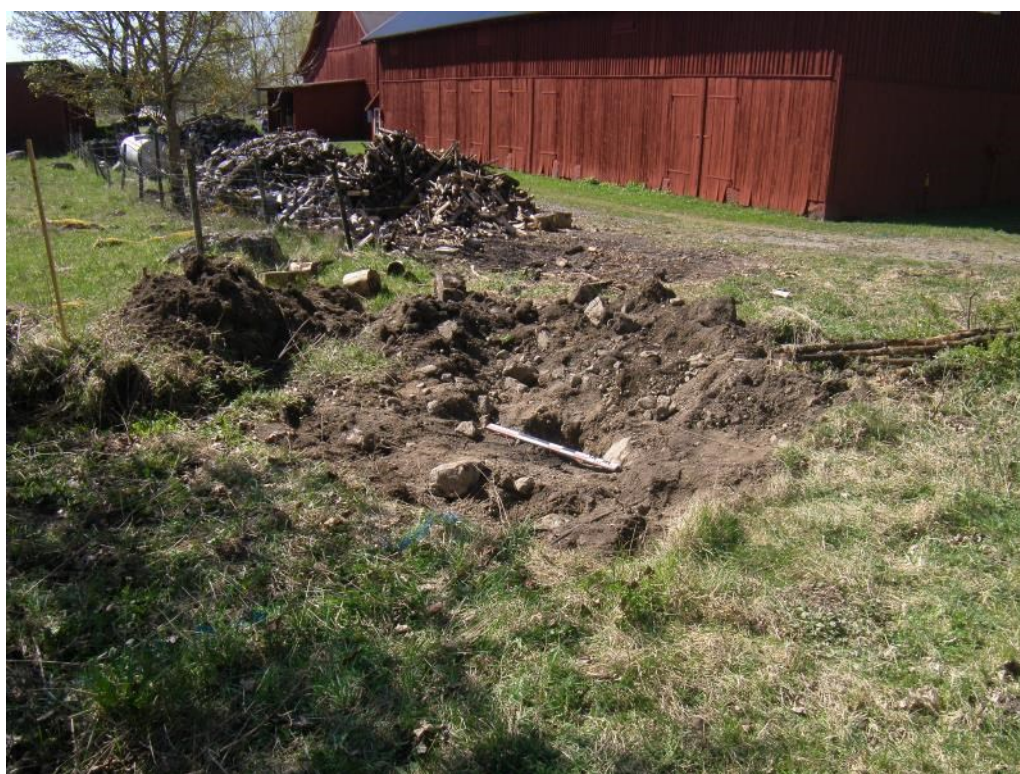
Figur 5. Schaktet söder om väg med A8 närmast i bild. Foto mot sydväst, Andreas Hennius.
