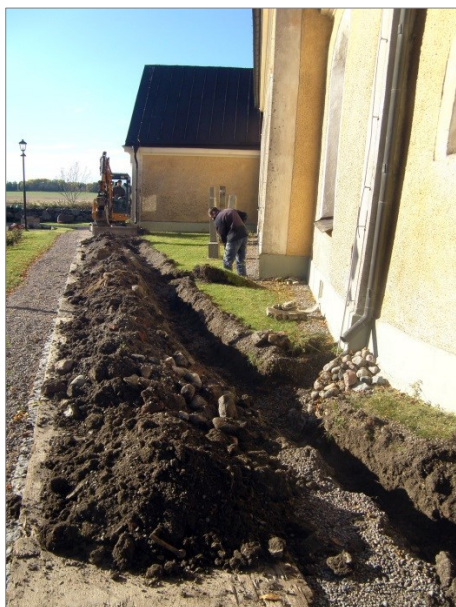
Figur 7 t.v. Schaktet för ringledaren på södra sidan kyrkan. Foto mot väster.
