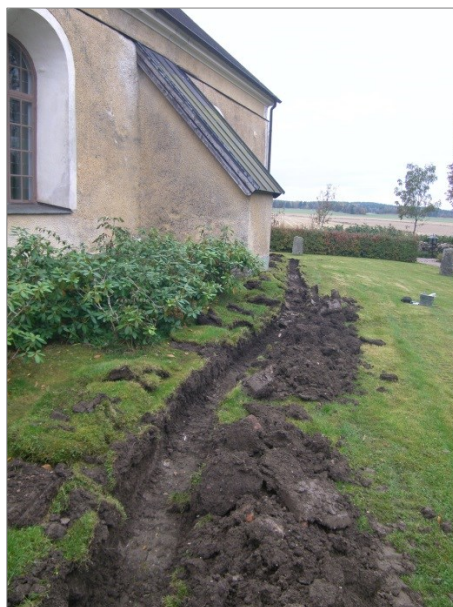
Figur 7 t.v. Schaktet för ringledaren på södra sidan kyrkan. Foto mot väster.
