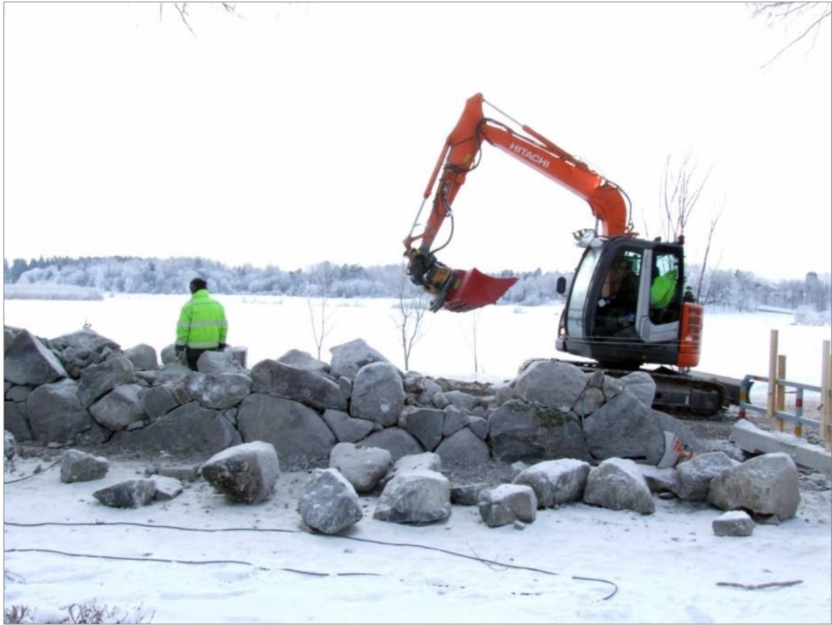
Figur 48. Arbete med omläggning av kyrkogårdsmur vid Svinnegarns kyrka. Foto mot S.
