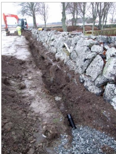
Figur 25. Del av dräneringsschakt A5 som löpte längsmed den södra kyrkogårdsmuren. Foto mot V.
