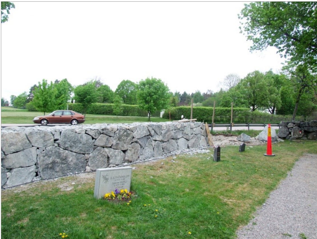
Figur 32. Den västra delen av kyrkogårdsmuren så gott som klar i slutet av maj 2013. I bakgrunden ses väg 55. Foto mot NV.
