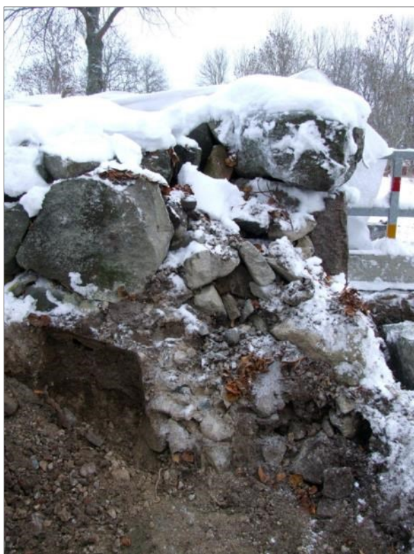
Figur 15. A1, Varmmurad kärna i kyrkogårdsmurens sydöstra hörn. Foto mot Ö.
