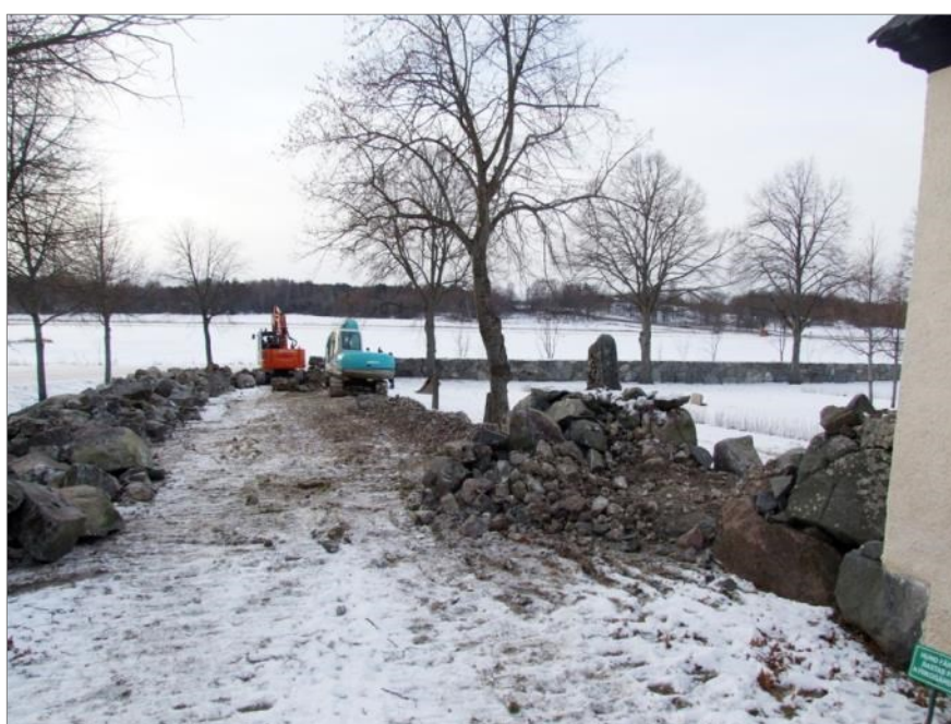
Figur 34. Den östra bogårdsmuren demonteras. Foto mot S.
