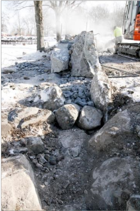
Figur 22 (t.v). Bottenskiftet av den äldre bogårdsmuren samt nymonterat parti. Parti ca 50 m från SÖ hörnet. Foto mot Ö, Ulrika Sahlsten, Upplandsmuseet.
