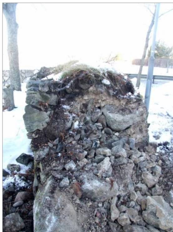
Figur 42 (t.v). Den äldre bogårdsmurens norra del borttogs delvis vid arbetet. På bilden framgår kvarvarande grundstenar. Foto mot Ö.
