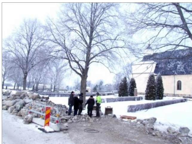
Figur 11. Byggmöte i bitande kyla vid Svinnegarns kyrka, i slutet av januari 2012. Foto mot NV.
