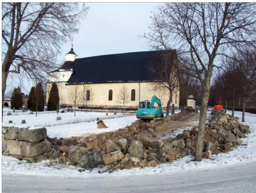
Figur 33. Den östra bogårdsmuren demonteras. Foto mot N.
