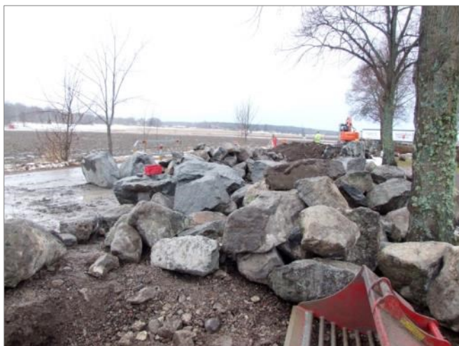
Figur 18. Arbetsituation vid nedmontering av kyrkogårdsmurens södra del. Foto mot SV.
