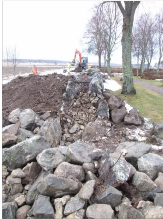
Figur 22 (t.v). Bottenskiftet av den äldre bogårdsmuren samt nymonterat parti. Parti ca 50 m från SÖ hörnet. Foto mot Ö, Ulrika Sahlsten, Upplandsmuseet.
