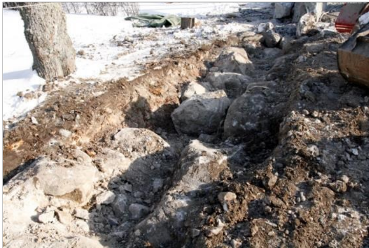
Figur 20. Bottenskiftet av den äldre bogårdsmuren. Parti ca 50-60 m från SÖ hörnet. Foto mot Ö, Ulrika Sahlsten, Upplandsmuseet.
