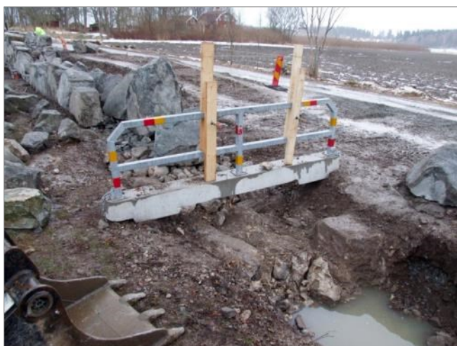
Figur 19. Del av den äldre bogårdsmuren, här delvis borttagen. Parti ca 25 m från SÖ hörnet. I bakgrunden ses montering av den nya muren. Foto mot SV.
