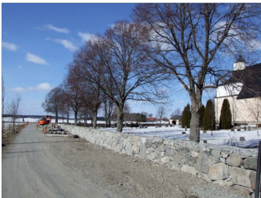
Figur 26. Den södra kyrkogårdsmuren nyomlagd och klar. Foto mot V.
