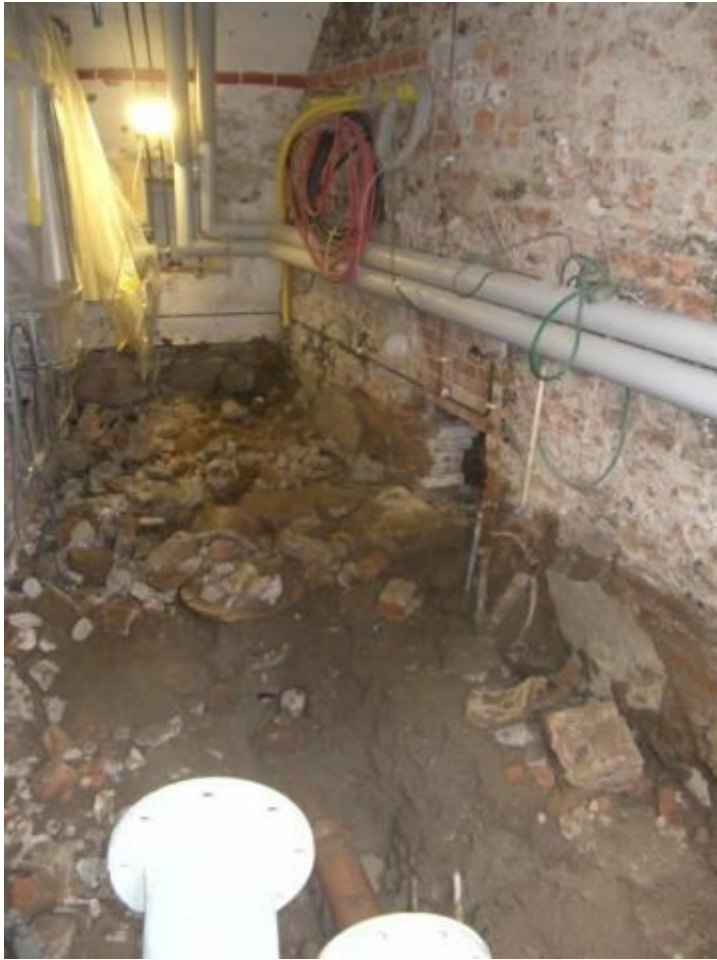
Figur 233. Foto av sprinklerrummet där ca 0,5 m av golvet och dess fyllning tagits bort. Foto mot sydost 2010-09-21.
