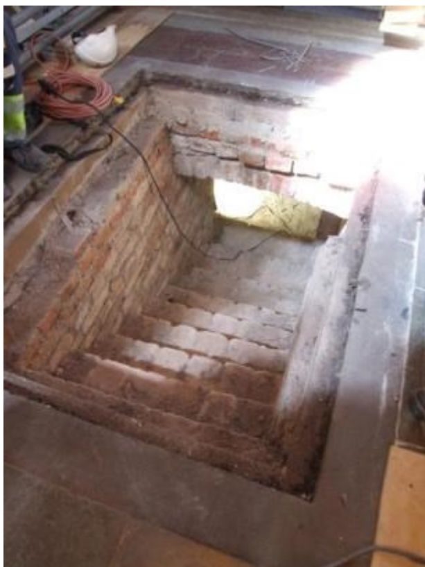
Figur 148. Trappan ner till gravvalvet. Foto mot norr 2011-05-23.
