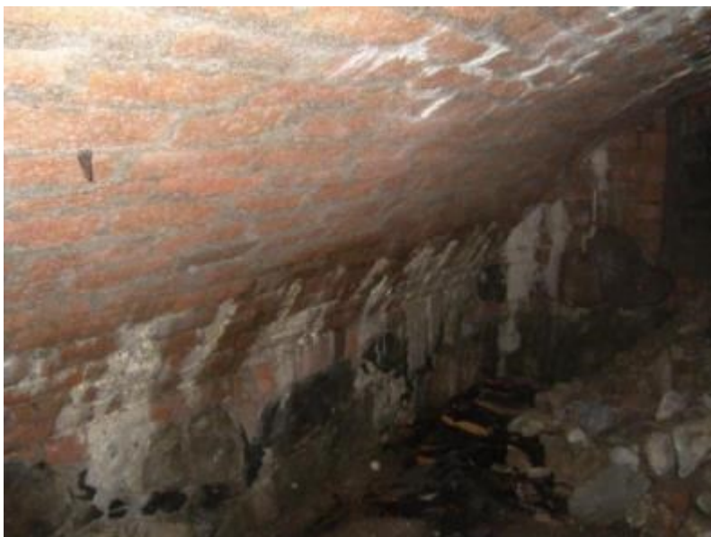
Figur 240. Östra väggen där valvet går nästan ända ner till den låga väggen uppbyggd av sten. Foto mot sydost, 2010-09-21.
