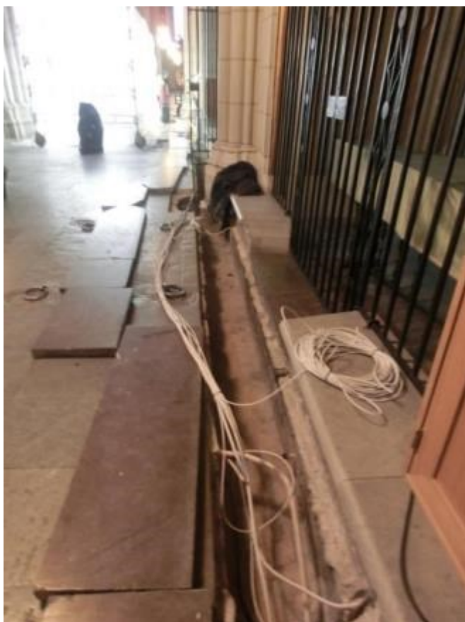
Figur 222. Rensning av befintlig tegelkanal i korets norra sidoskepp. Foto mot väster 2014-02-05.
