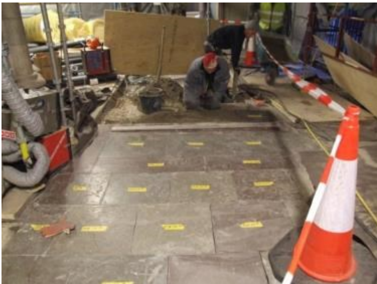
Figur 78. Stenplattorna i norra sidoskeppet läggs på plats. Foto mot väster 2011-02-23.
