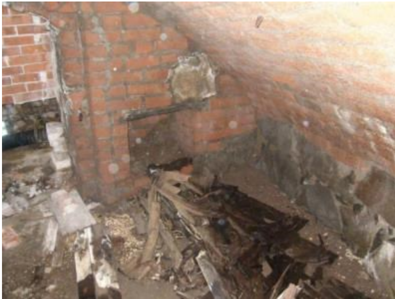
Figur 239. Östra sidan om ingången där nischen i norra väggen syns. Foto mot norr, 2010-09-21.
