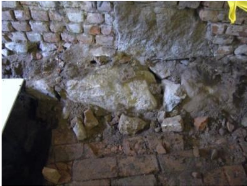
Figur 235. Detalj av grundstenar till nordöstra väggen. Foto mot nordost 2010-09-21.
