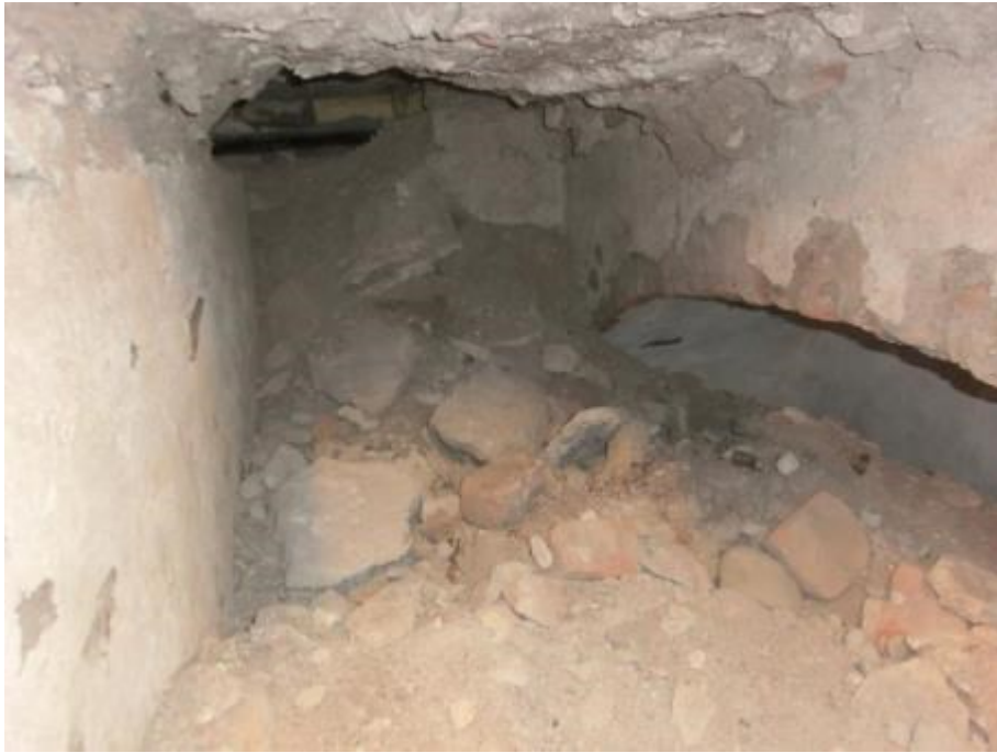
Figur 205. Den norra delen av gravkammare I med öppningen in till den valvslagna delen till höger i bild. Längst bak i kammaren syns hur en tidigare dragen vattenledning slagit hål i taket. Foto mot sydost 2013-02-07.
