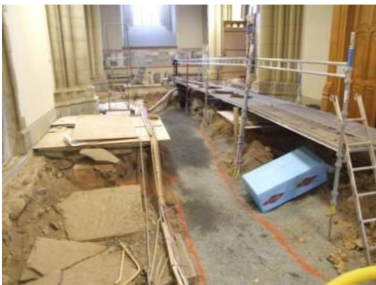
Figur 20. På fotot syns kommande placering av ledningskulverten. Foto mot söder 2011-02-02.
