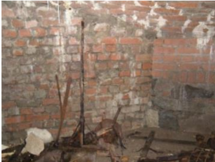
Figur 241. Västra sidan om ingången. Foto mot nordväst, 2010-09-21.
