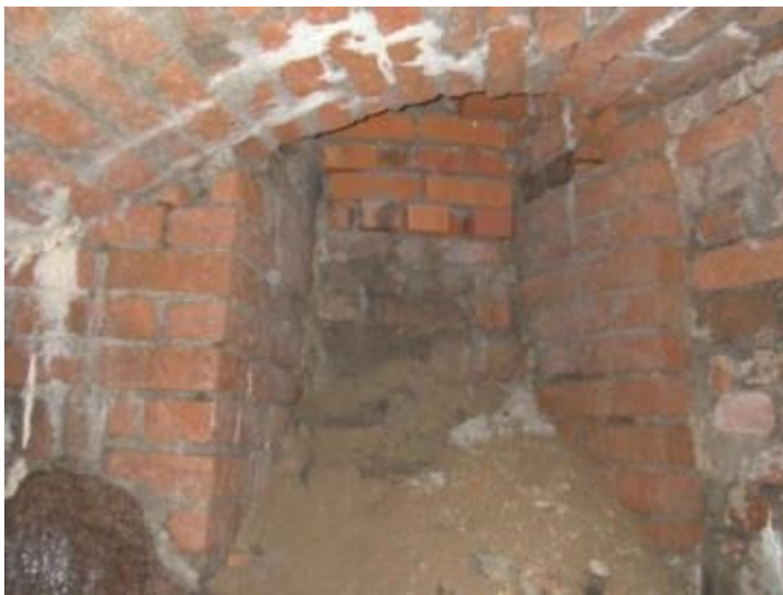
Figur 242. Schaktet i södra delen av källaren. De översta stenarna är ditlagda i sen tid. Foto mot söder, 2010-09-21.
