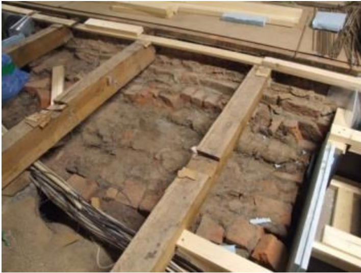
Figur 100. Gravkammare F. Foto mot sydost 2011-02-01.
