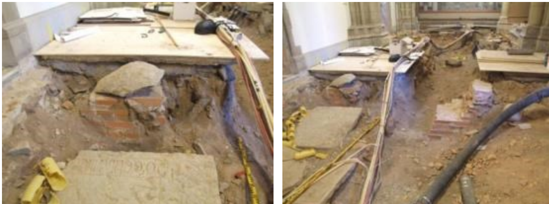
Figur 68 och 69. Till vänster tegelfundament nr 12. Eventuellt finns här också samma sidopåbyggnad som i nr 8. Till höger syns fundamenten nr 12 och 10. Bägge fotona mot söder, 2011-01-31.
