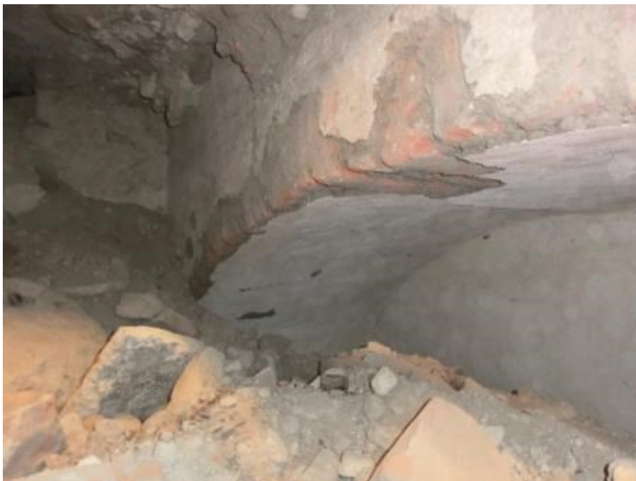
Figur 206. Detalj av den valvslagna södra delen gravkammare I. Foto mot sydost 2013-02-07.
