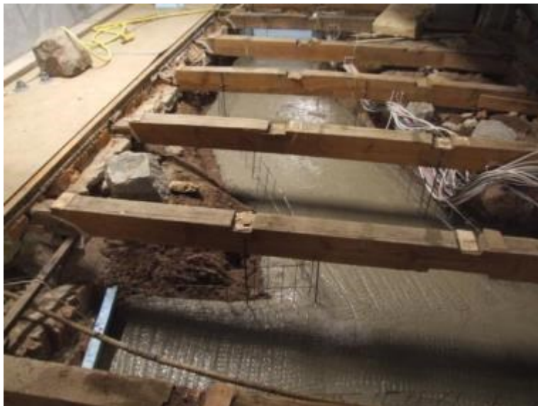
Figur 85. Den gjutna kulvert botten sedd mot väster. En avstickare är förberedd mot söder och avslutas vid den blåa frigolitkivan i vänstra hörnet. Foto mot väster 2011-01-27.
