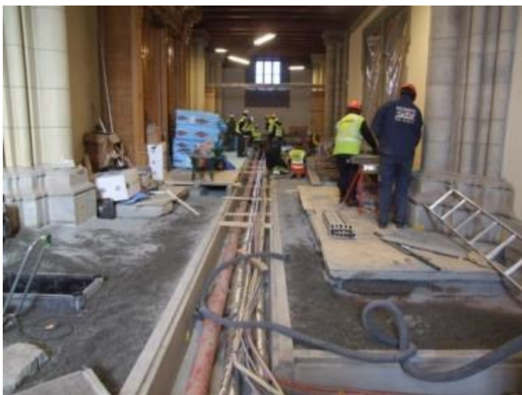
Figur 23. Fyllningsarbeten kring ledningskulverten pågår 2011-02-23. Foto mot norr.
