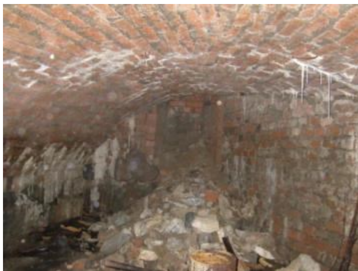
Figur 243. Källaren sedd mot söder. Foto 2010-09-21.
