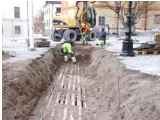
Figur 8. Schaktet med de framrensade äldre ledningarna. Foto mot nordväst 2011-03-30.
