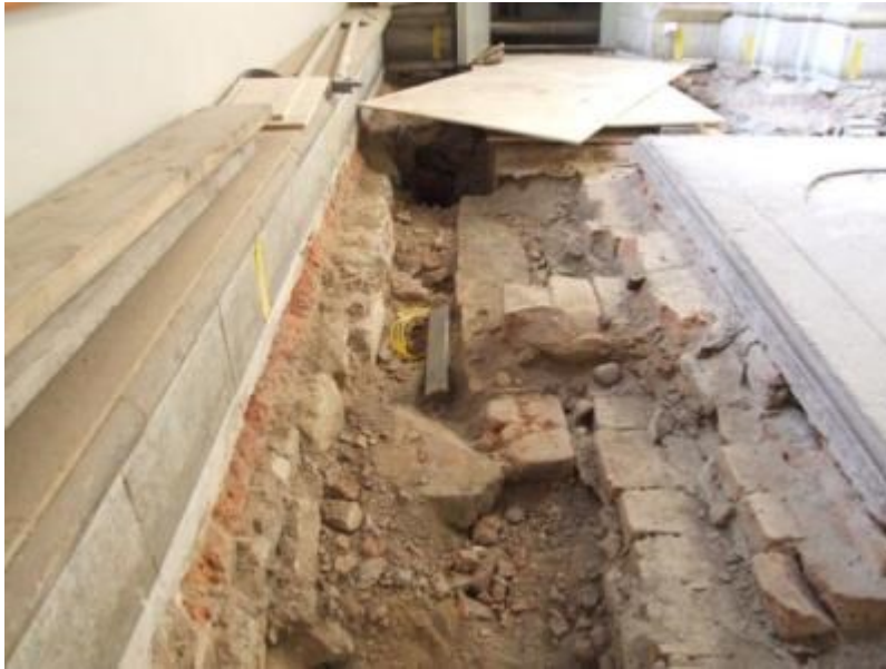
Figur 36. Strax norr om södra väggen i tornet fanns en smalare ränna som kan ha utgjort en tidig värmekulvert. Till höger syns gravkammaren. Foto mot väster, 2011-01-31.
