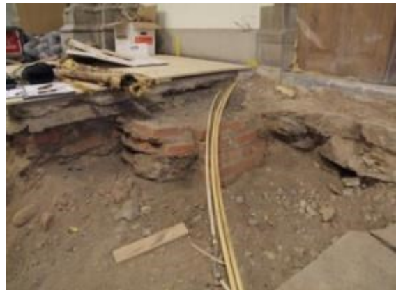
Figur 63 och 64. Tegelfundament nr 8. Till vänster, foto mot öster. Till höger, foto mot nordost 2011-01-31. Den främre tegeluppmurningen är nr 9 som inte sitter i förband med den bakre nr 8.
