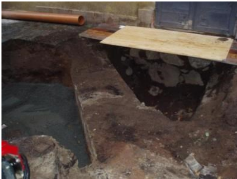
Figur 236. Upptaget schakt utanför ingången till sprinklerrummet. Fotot visar grundstenarna under dörren till sprinklerrummet. Foto mot sydost 2010-10-06.
