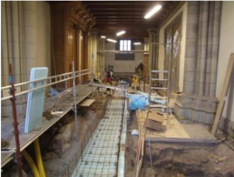
Figur 21. Isolering och armering har påbörjats inför gjutningen av ledningskulverten. Foto mot norr 2011-02-03.
