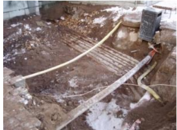
Figur 6 och 7. Två arbeten med provgropen påbörjats 2010-11-08 (foto mot sydost av Anna Ölund) och överst syns de äldre sprinklerledningarna efter det att hissfundamentet tagits bort. Foto mot sydost 2010-11-11.
