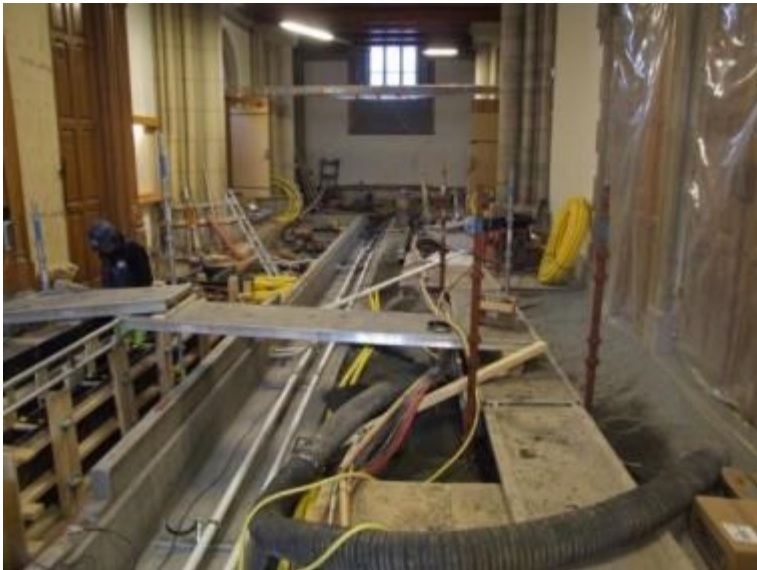
Figur 22. Ledningskulverten färdig och sprinklerrören finns nedlagda. Foto mot norr 2011-02-17.
