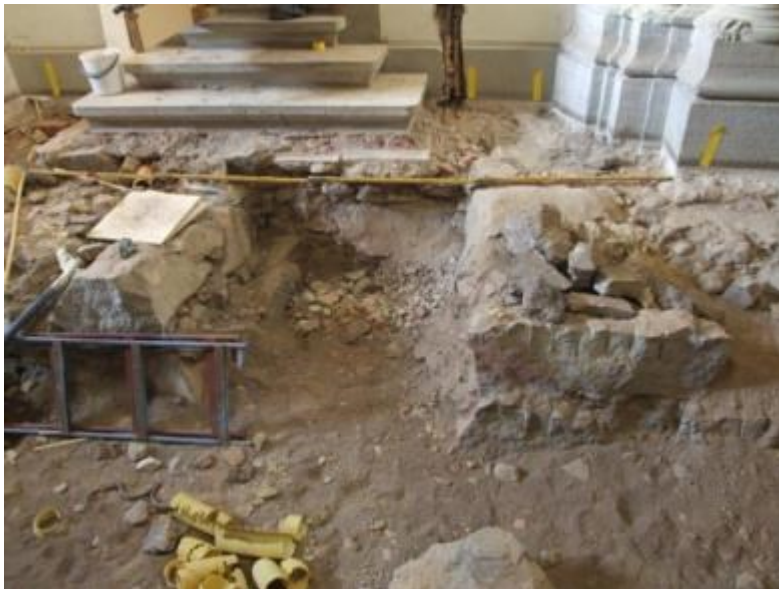
Figur 33. Till höger syns den kraftiga grundmuren under pelare C1, med synliga borrhål i östra kanten. Det samma gäller för den södra delen, nr 15. I mitten ett parti utan spår efter grundmurar. Foto mot väster, 2011-01-31.
