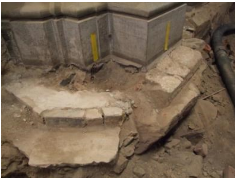
Figur 30. Fundamentet kring pelare B1, med fint lagda tegelstenar på den södra sidan. Foto mot nordväst, 2010-01-31.
