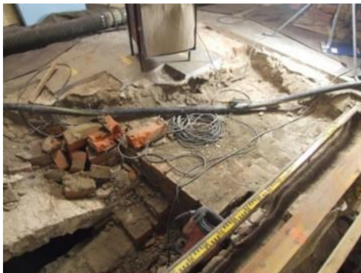
Figur 98. Endast delar av det platta taket frilades på gravkammare E. Till vänster i bild syns det välvda taket på gravkammare D. Foto mot nordost 2011-01-27.
