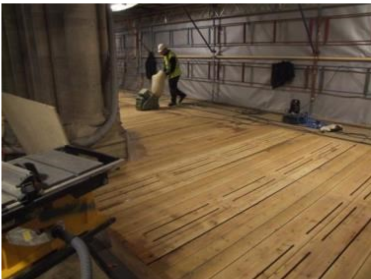
Figur 79. Golvet slipas innan byggnadsställningar och inplastningen rivs. Foto mot nordväst 2011-02-23.
