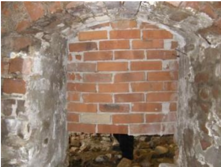
Figur 245. Detalj av den igenmurade öppningen till källaren, sedd från insidan. Foto mot norr, 2010-09-21.
