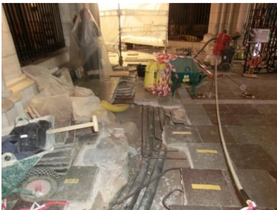
Figur 223. Upptagande och dragning av nya rör vid de installationer som gjordes på 1970-talet. Här sker arbetet i koromgången. Foto mot norr 2014-03-04.
