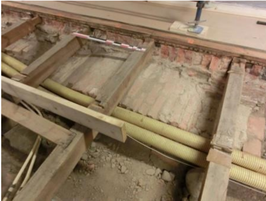
Figur 211. Gravkammare L med det vällagda tunnvalvet. Foto mot nordväst 2013-02-06.
