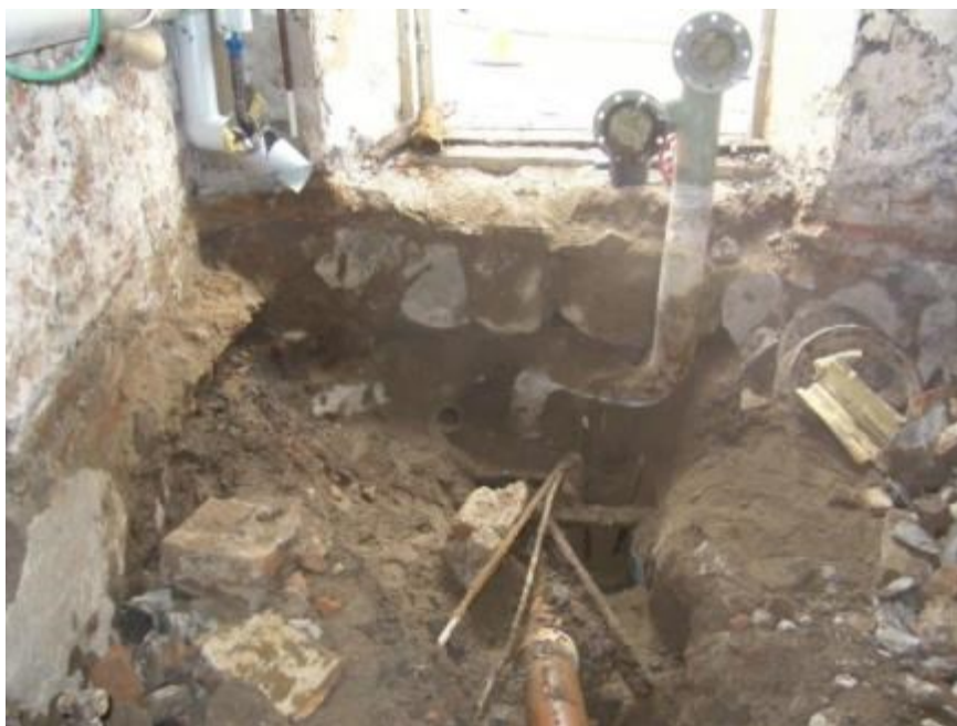
Figur 232. Schaktning för sänkning av golvet har påbörjats. Foto mot ingången i nordväst visar tidigare nedgrävda VA-ledningar. Foto 2010-09-21.
