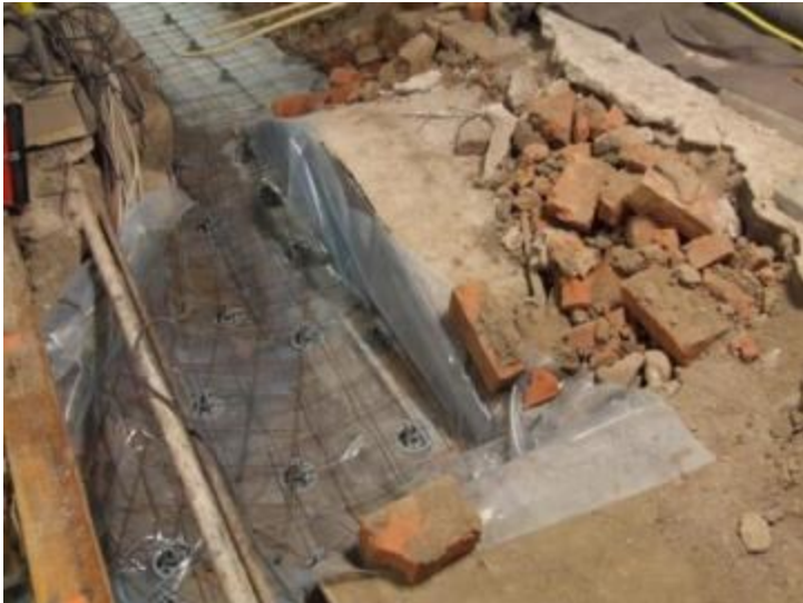
Figur 95. Gravkammare D där gavelsidan har försetts med en plåt och därefter plastats in. Foto mot nordväst 2011-02-01.
