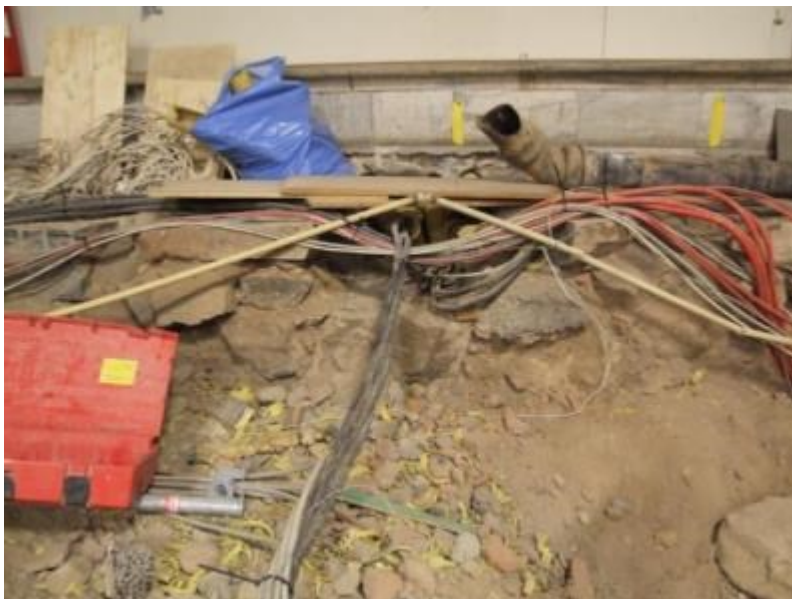
Figur 28. Genomföring av bl.a. elkablar i norra grundmuren i förhallen. Foto mot norr, 2011-01-31.
