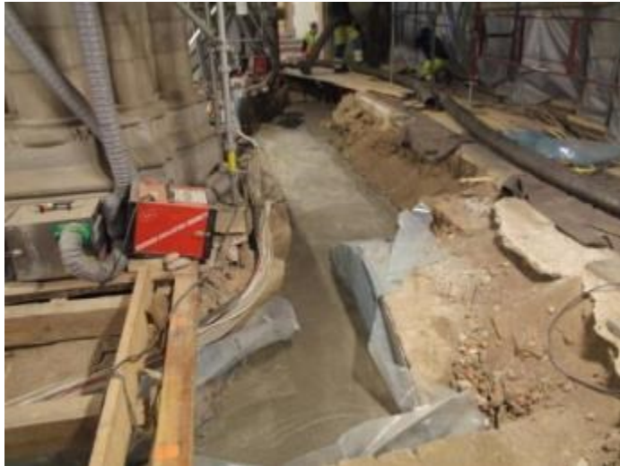
Figur 74. Bottenplattan klar i kulverten i västra delen av norra sidoskeppet in mot förhallen. Foto mot väster 2011-02-02.
