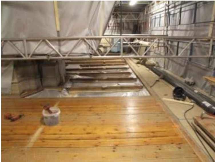
Figur 77. Golvet under norra bänkraden läggs på plats. Foto mot öster 2011-02-21.
