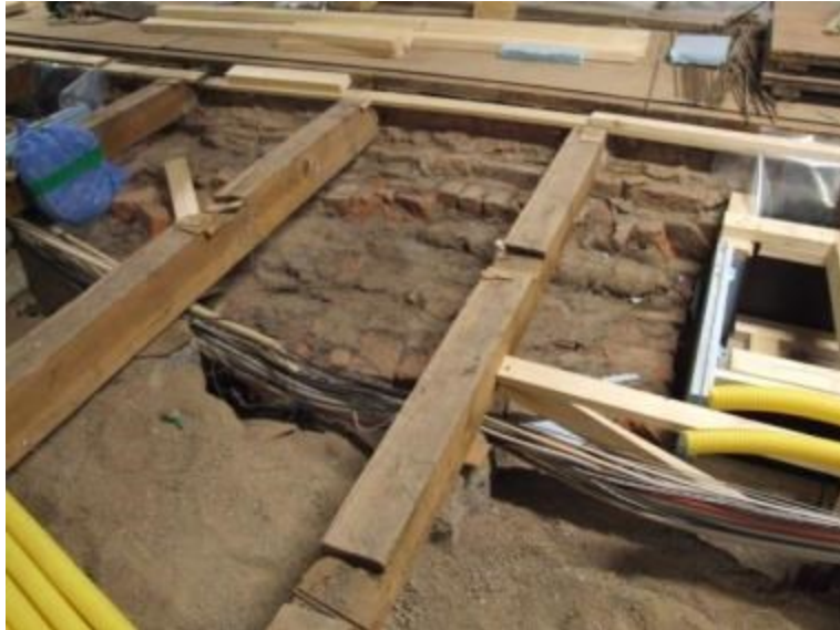
Figur 84. Taket på gravkammare F. Formen för ledningskulverten slutar strax till höger i bild. Foto mot söder 2011-02-01.
