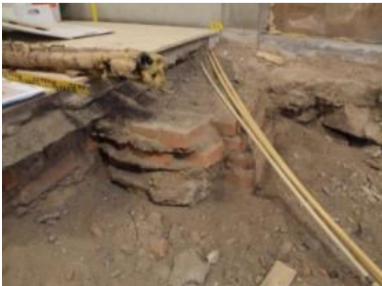
Figur 63 och 64. Tegelfundament nr 8. Till vänster, foto mot öster. Till höger, foto mot nordost 2011-01-31. Den främre tegeluppmurningen är nr 9 som inte sitter i förband med den bakre nr 8.
