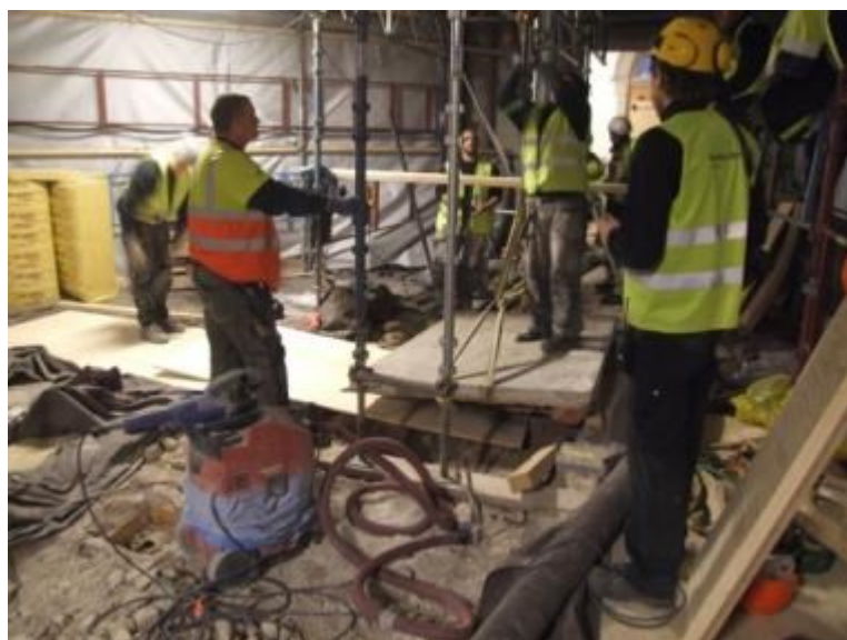
Figur 81. Arbetet med att flytta gravhällen i travé 32 krävde att antal personer och en sinnrik lyftanordning. Foto mot väster 2011-01-25.
