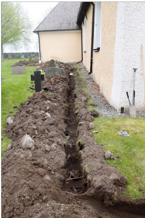
Figur 11. Längs långhusets norra vägg fanns i schaktet rikligt med naturstenar. In mot långhuset syntes i schaktkanten att marken var omgrävd och uppfylld med ett sandlager. Troligtvis härrör det från de dräneringsarbeten som utfördes runt delar av kyrkan under 1920-talet. Foto mot Ö.
