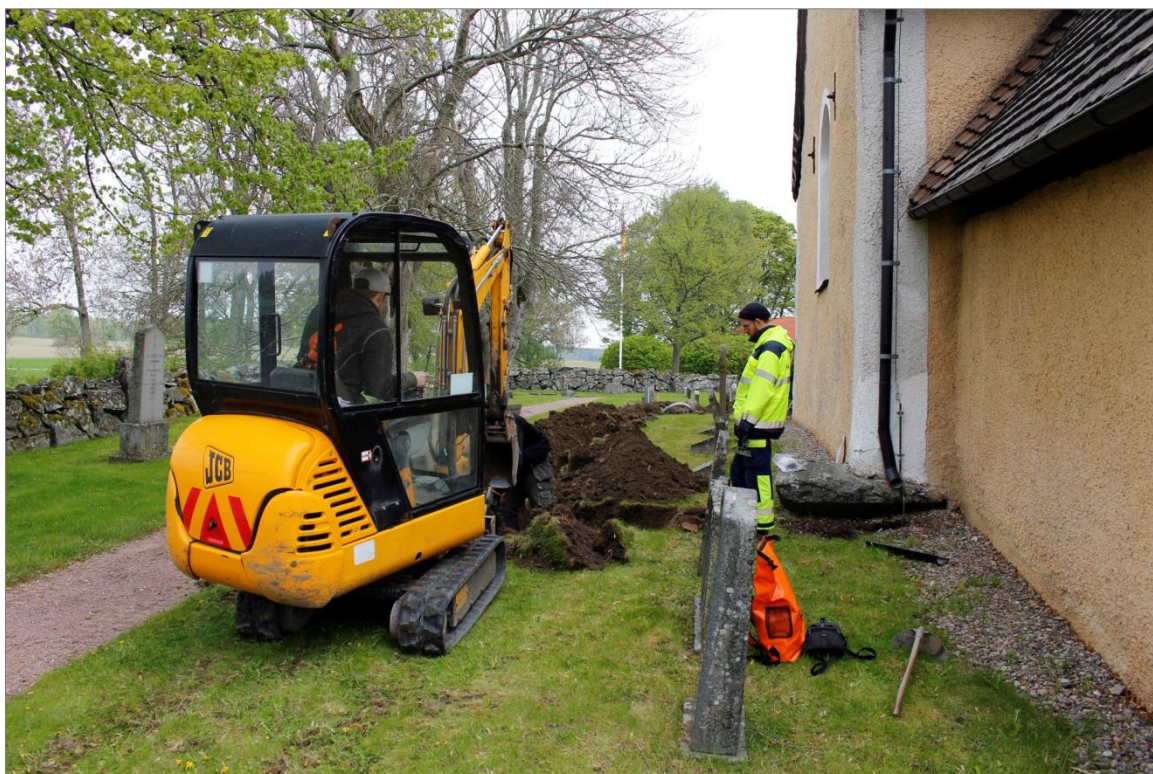
Figur 8. Pågående schaktningsarbeten västgaveln på Hacksta kyrka. Foto mot S.
