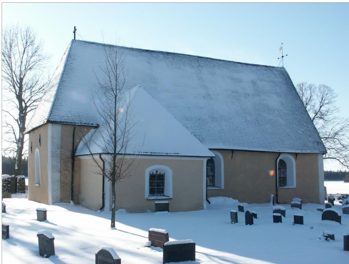
Figur 2. Hacksta kyrka från sydväst. Koret var ursprungligen lägre och smalare än långhuset. Foto mot SV, Johan Dellbeck, Upplandsmuseet.
