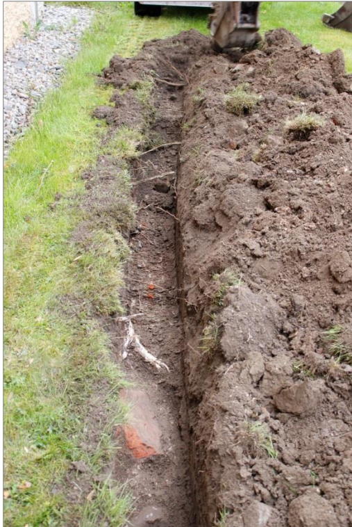
Figur 6. Vid korets södra sida fanns i schaktet ett raseringslager bestående av kalkbruk och tegelkross. I östra delen av lagret fanns en hel tegelsten. Foto mot Ö.
