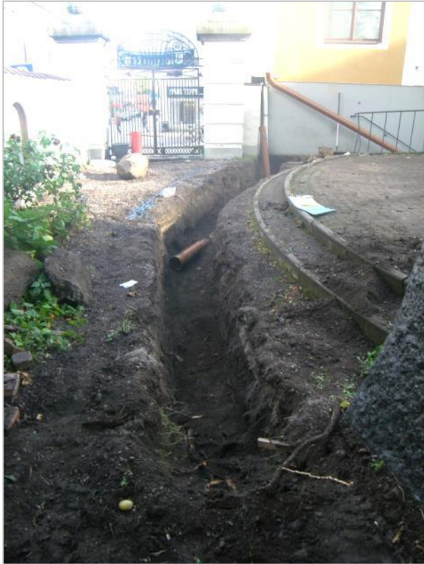
Figur 7. Översikt över schaktets östra del. Schaktningen påbörjades på innergårdens östradel för anslutning till nationshusets källare. Foto mot Ö.
