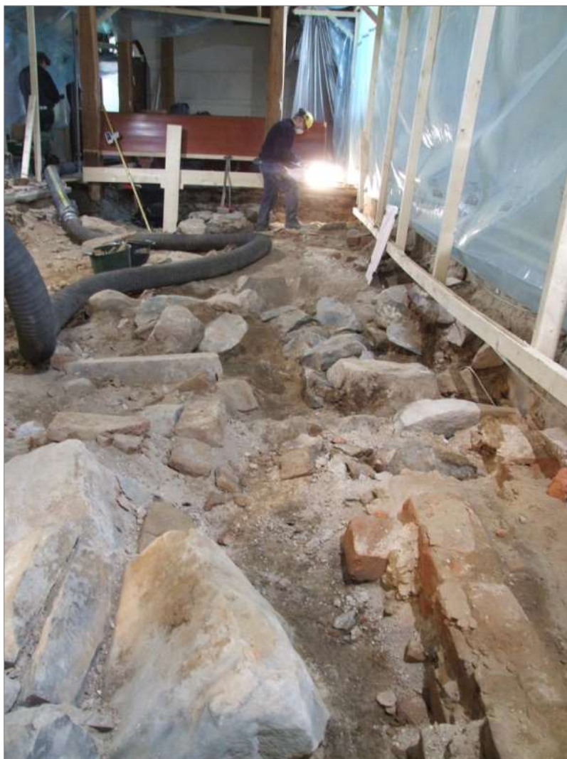
Figur 90. Långhusets äldre grundmur planritas. Foto mot V.
