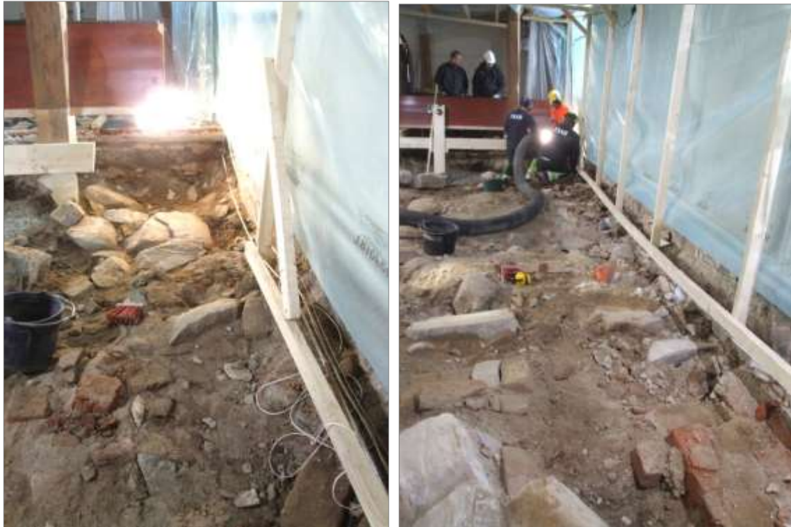
Figur 87. Delar av en kraftig grundmur friläggs. Foto mot V.
