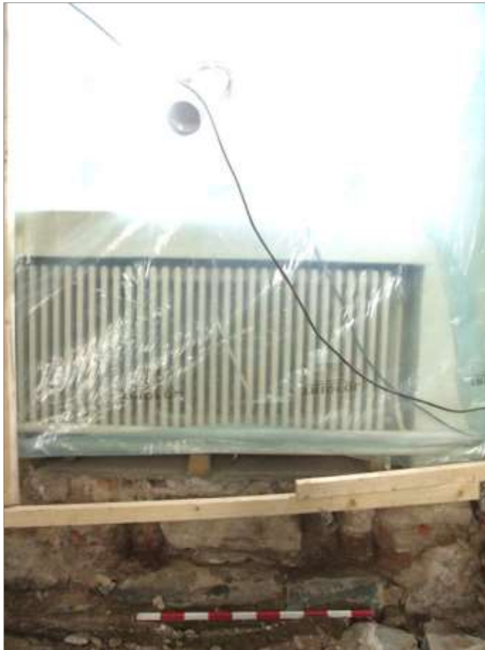
Figur 80. NA14, den äldre sakristians portal delvis bevarad under elementet vid långhusets nordöstra fönster. Foto mot N.
