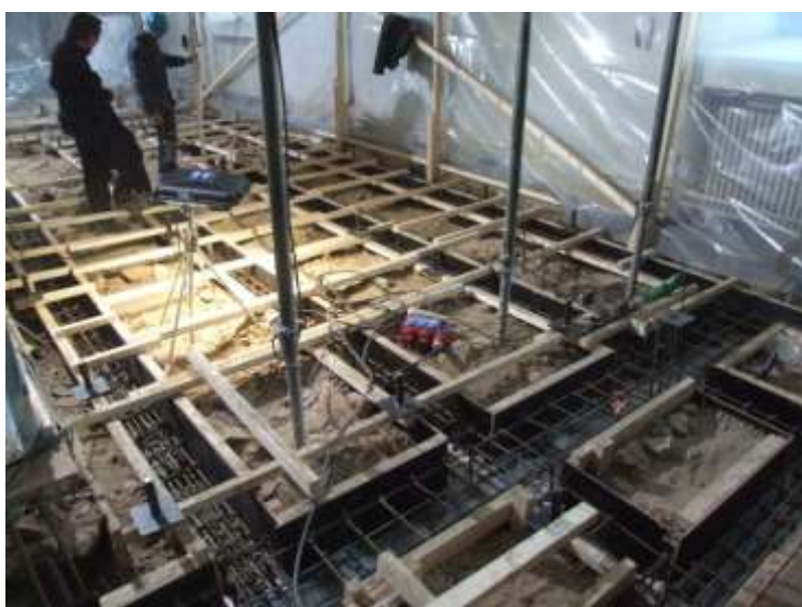
Figur 58. Gjutlådor med armering på kyrkans södra sida. Foto mot SÖ av Sverker Larsson.
