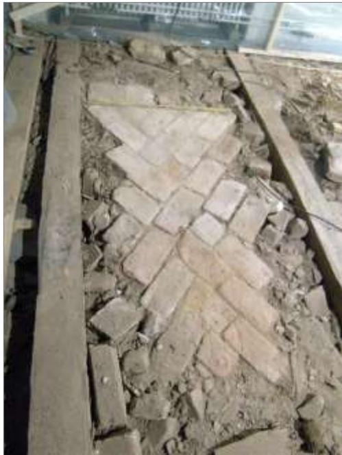
Figur 46. SA1- bit av äldre tegelgolv mellan två golvbjälkar. Foto mot S. Figur 47. SA1- planritning av äldre tegelgolv. Skala 1:40.
