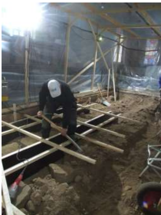
Figur 56. Konstruktion av gjutlådor på kyrkans södra sida. Foto mot NÖ.
