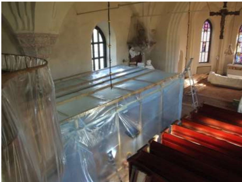
Figur 60. Inför undersökningen på norra sidan av Enåkers kyrka hade ytan tätats med ett plasttält. Foto mot NÖ.
