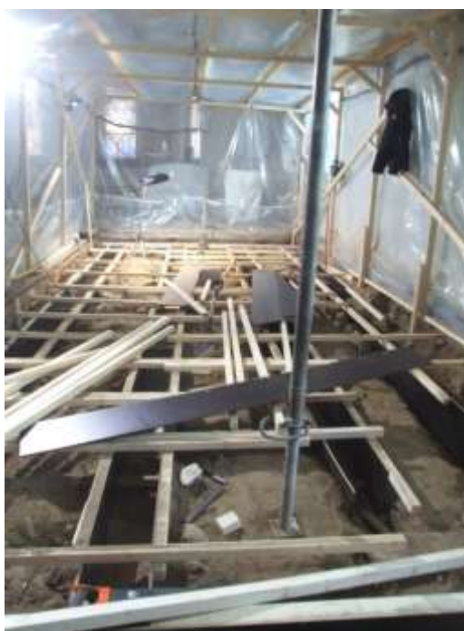
Figur 56. Konstruktion av gjutlådor på kyrkans södra sida. Foto mot NÖ.
