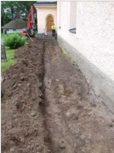
Figur 21. Dräneringsschakt längsmed kyrkans norra sida. I bakgrunden ses sakristian och bårhuset. Foto mot Ö.
