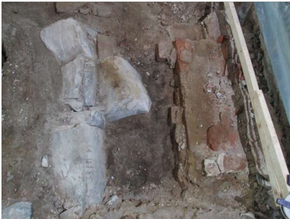
Figur 97. Kormuren sedd uppifrån. På fotot framgår tydligt att muren kollapsat inåt åt söder. Bildens överkant mot V.
