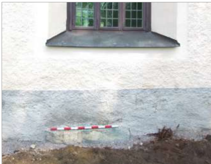
Figur 31. Den äldre tröskelstenen mellan vapenhuset och långhuset ses i kyrkans sydfasad. Foto mot N.
