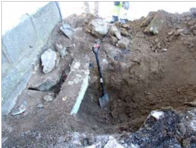
Figur 26. Schakt för ventilationsbrunn och ny el vid kyrkans norra tornmur. Foto mot V.
