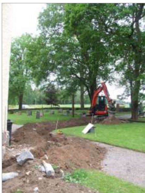
Figur 38. Elschakt väster om kyrkan. Foto mot SSV.
