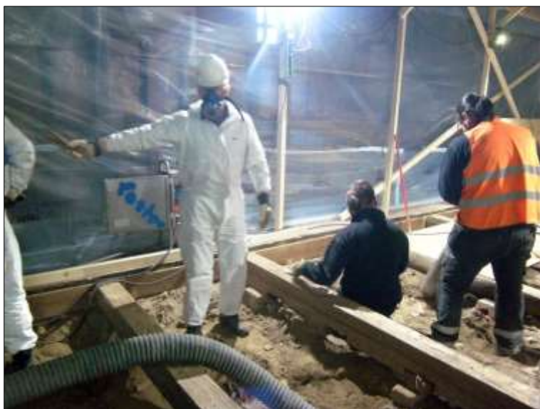
Figur 49. Arbetsbild vid SA4. Gravens nedgrävningskant ser i bildens nederkant. Foto mot NÖ.
