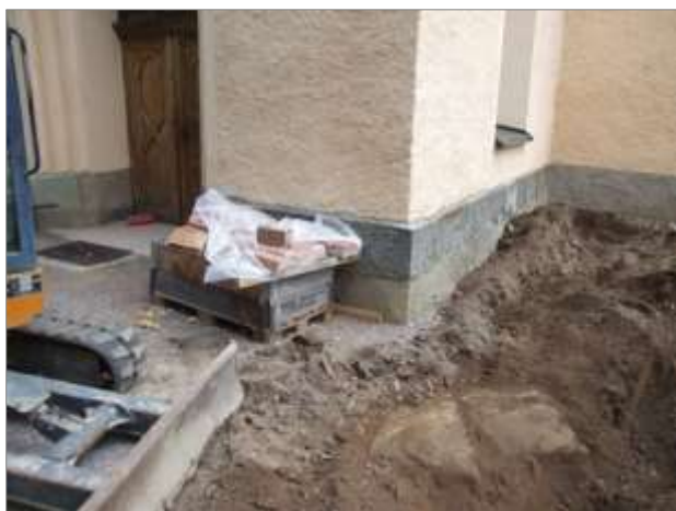
Figur 32. Stora grundstenar vid tornets sydvästra hörn. Foto mot NÖ.
