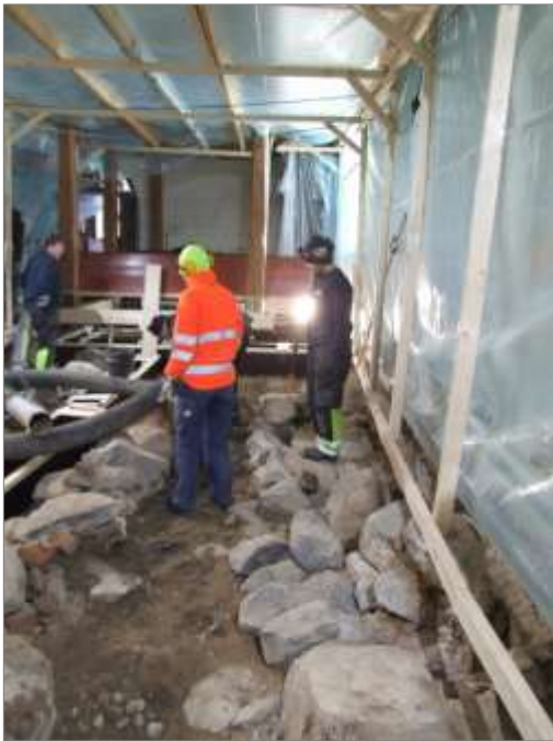
Figur 105. Övervakning av lager NA21 under stenblocken till grundmuren i de rännor som anlades för att konstruera gjutlådor till betongbalkar. Foto mot V, Dan Fagerlund, Upplandsmuseet.
