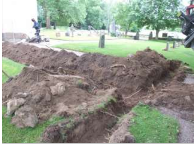
Figur 24. Elschakt för belysning väster om kyrkans ingång. Foto mot Ö.
