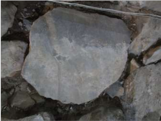
Figur 91. Avtryck efter kalkbruk med raka utsidor vilket sannolikt markerar placeringen av långhusmuren på grundmuren.
