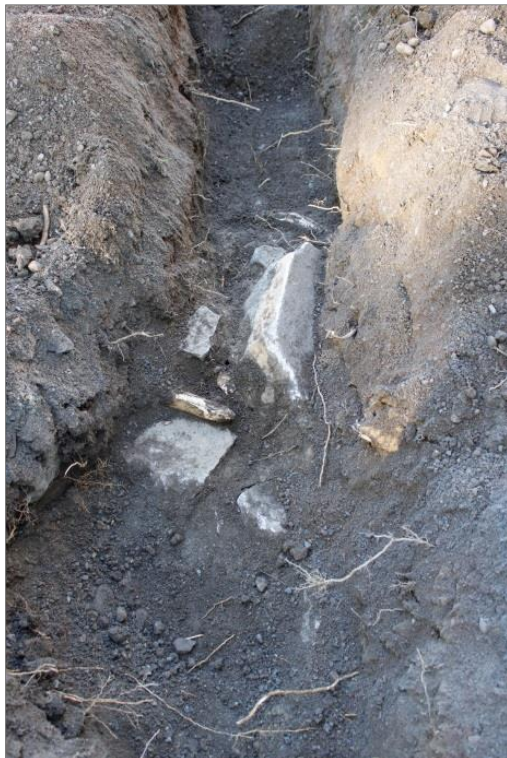
Figur 8. Längs långhusets södra sida påträffades ett parti med huggna gråstenar, B. Dessa låg ca 0,25 m under mark och utgör troligtvis raseringsmaterial från den medeltida kyrkan. Foto mot V.
