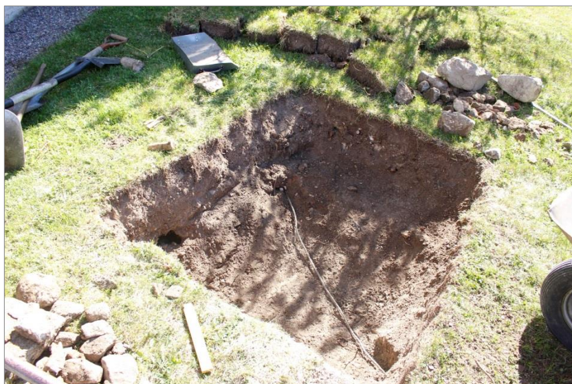
Figur 46. Där runstenen skulle placeras låg en befintlig ringledare vilket gjorde att schaktet endast kunde grävas 0,5 m som djupast. Detta bedömdes dock vara tillräckligt. Marken där schaktet grävdes var således till stora delar omrörd. Foto mot NÖ.
