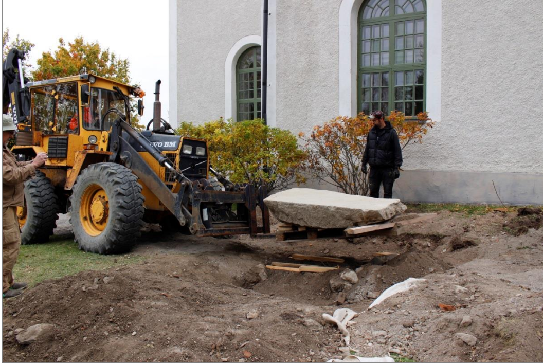
Figur 34. Runstenen flyttades sedan med hjälp av en hjullastare försedd med gafflar. Foto mot NV.
