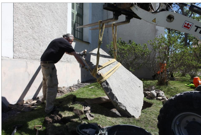
Figur 51. Runstenen lyftes stegvis och placerades i schaktet. Foto mot NÖ.
