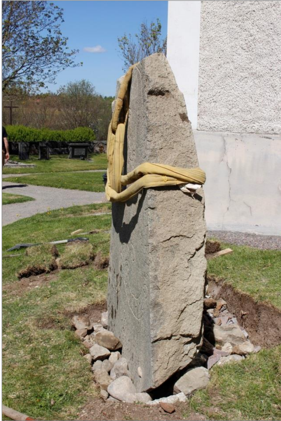
Figur 55 (t.v.). Runstenen stabiliserades med stenar och därefter med den uppgrävda jorden. Till slut lades grässvålen tillbaka på sidorna och bakom stenen. Foto mot V. Figur 56 (t.h.). Runstenen på sin nya plats. Foto mot Ö.
