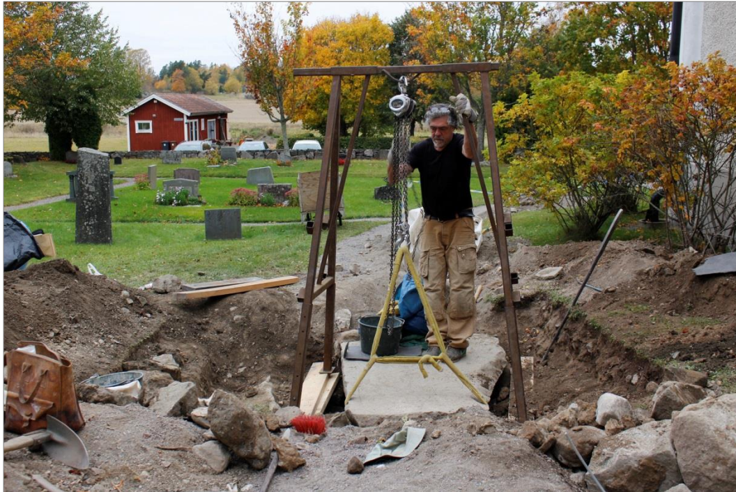
Figur 30. Runstenen lyftes stegvis med hjälp av en vinschanordning där spännband fästes runt den. Foto mot V.
