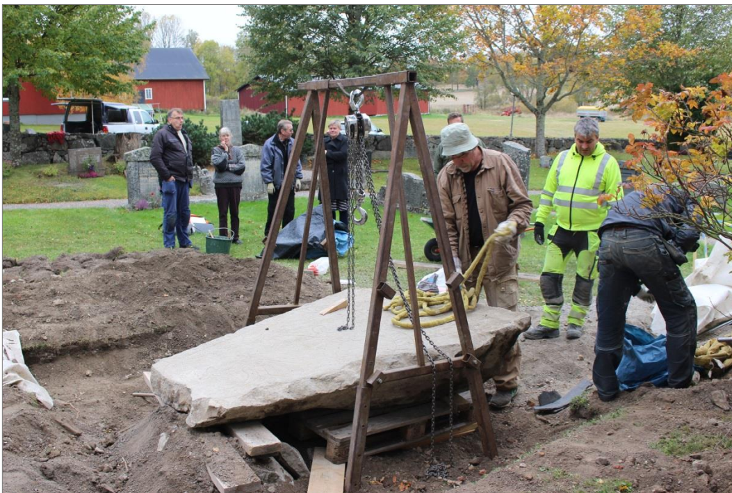
Figur 33. När runstenen hissats upp till strax över marknivån var det manuella lyftet färdigt. Den placerades på en lastpall för att kunna flyttas med en hjullastare. Foto mot SV.
