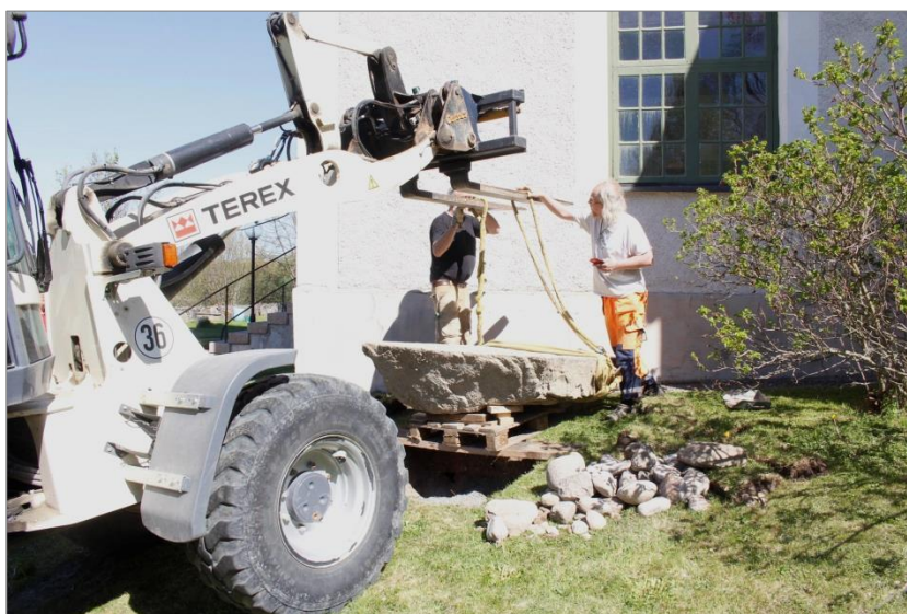
Figur 49. Runstenen placerades ovan schaktet och spännbanden fästes på hjullastarens gafflar. Foto mot NV.
