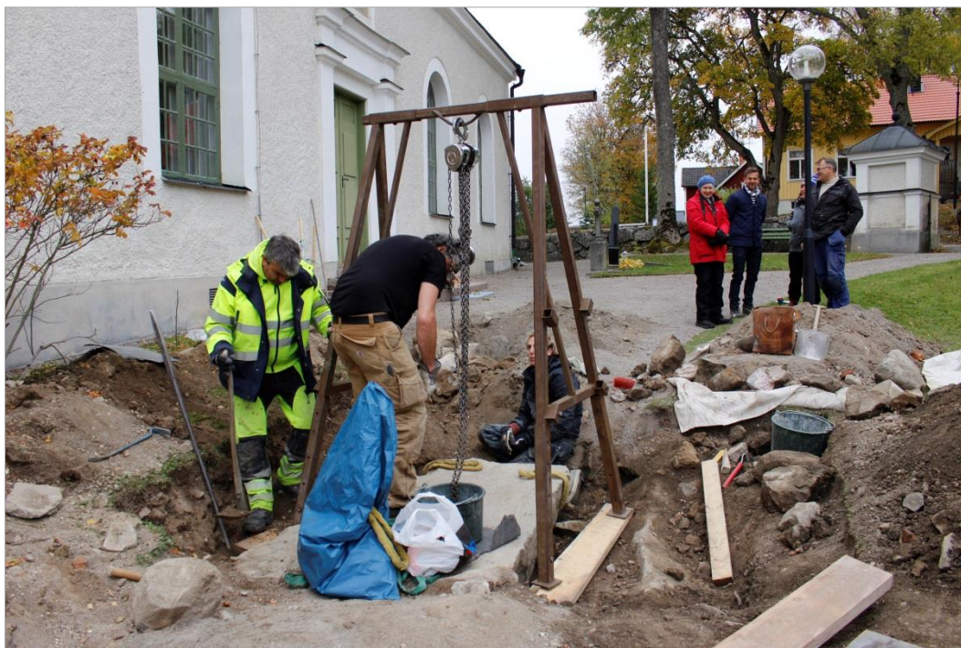
Figur 29. Pågående montering av ställning och vinschanordning. Foto mot Ö.
