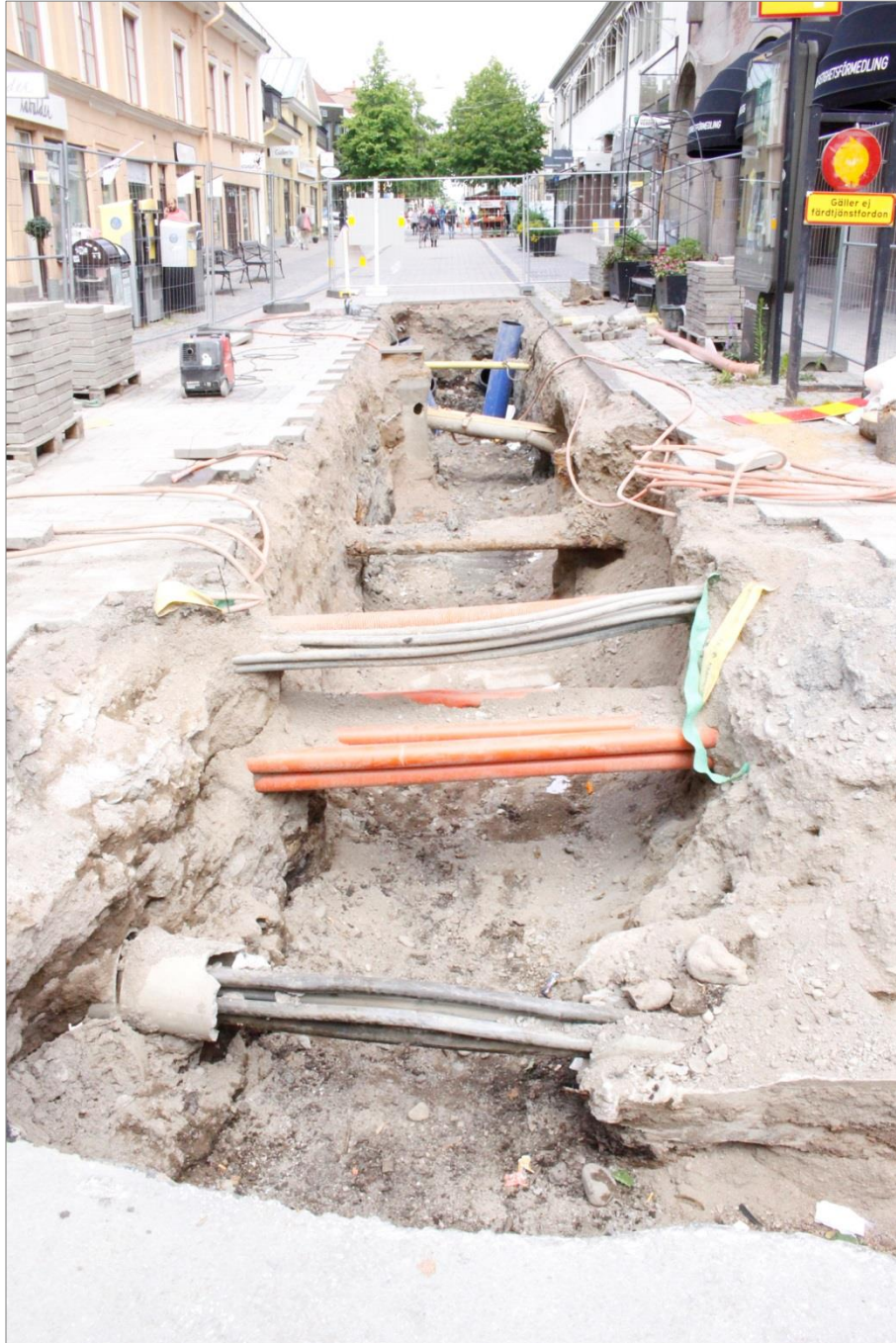
Figur 37. Det färdiggrävda schakt 2. Här syns de många befintliga ledningar vars schakt skadat äldre kulturlager och konstruktioner längs denna sträcka. Foto mot NV.
