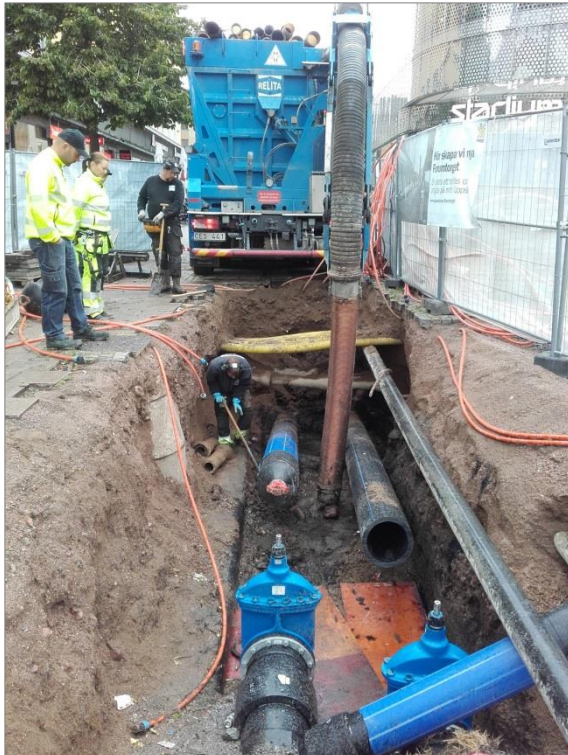
Figur 34. Etapp 3 i schakt 1 grävdes med sugbil för att frilägga de nya ledningarna. Foto mot NV.
