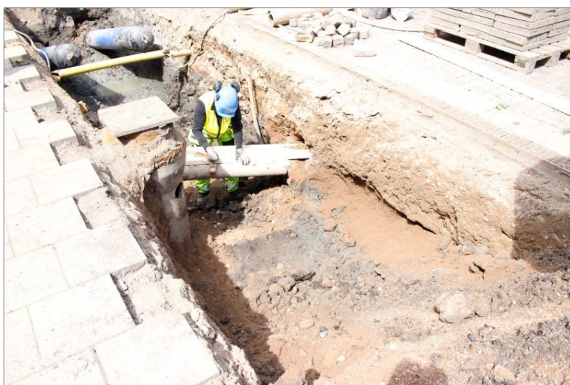
Figur 43. Pågående arbete på etapp 2 som var påverkad av flera moderna ledningar. Foto mot N.
