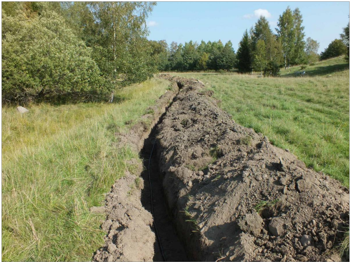
Figur 3. Schaktet för elledningen grävdes i gammal åkermark. Till höger i bild ses impedimentet med gravfältet Ununge 2:1. Bakom träden till vänster ligger gravfältet Ununge 1:101. Foto mot N.
