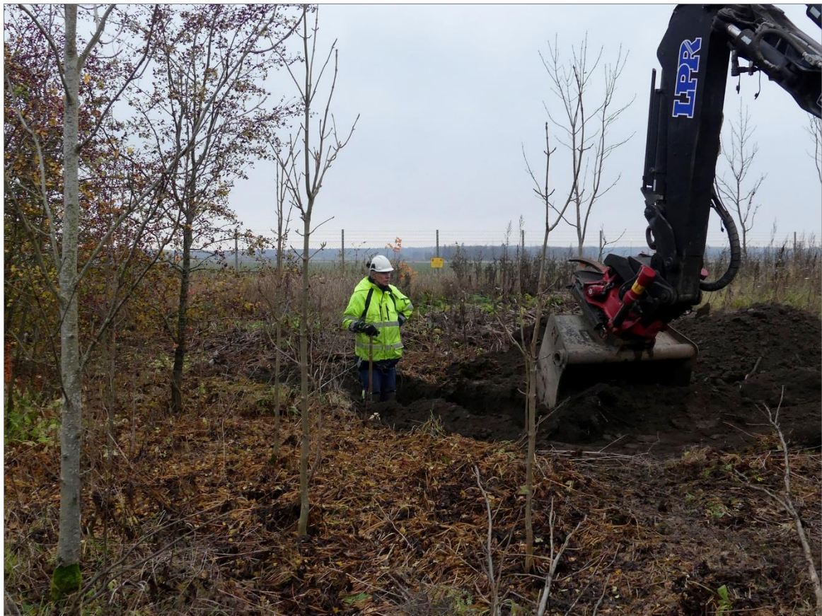
Figur 2. Schaktning i det västra området.
