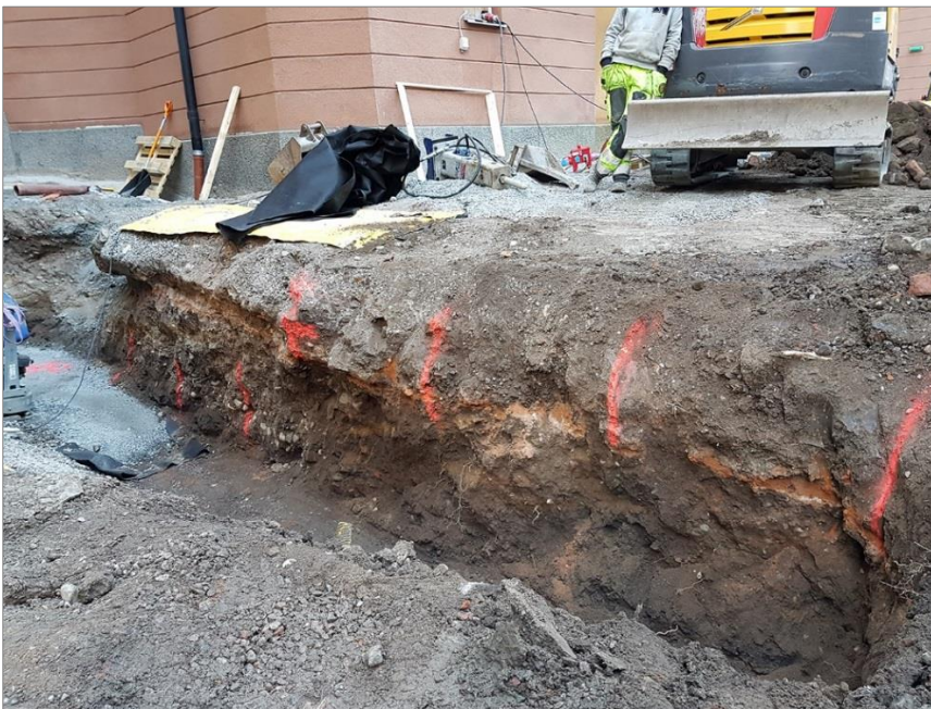
Figur 23. A5 Tegellagd yta som endast var synlig i schaktkanten på 0,5 m djup. Under denna i schaktets södra del ses A6 som utgjordes av en fragmentarisk stenläggning. Foto mot S, Emelie Sunding Upplandsmuseet.
