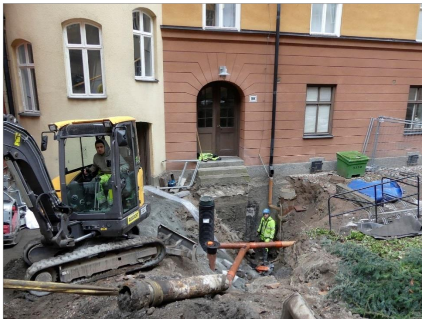
Figur 17. Oplanerat byte av äldre ledning till gårdshuset. Foto mot NV, Emelie Sunding, Upplandsmuseet.
