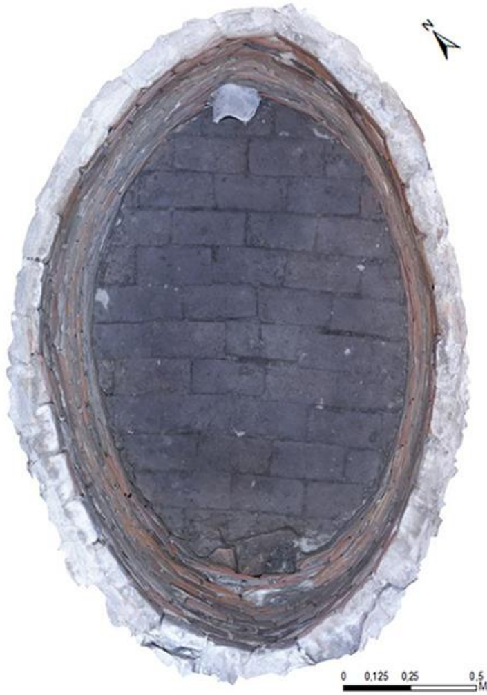
Figur 42. Lodbild av brunnen tömd, med den tegellagda bottnen och öppningarna i brunnens kortändor. Bilden genererad genom 3D-fotogrammetri. Foto och bearbetning: Robin Lucas, Upplandsmuseet. Skala 1:120
