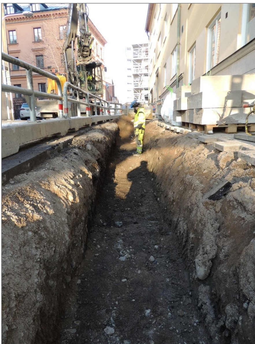
Figur 19. Fjärrvärmeschaktet längs schaktsträcka B på Klostergatan. Foto mot NÖ, Robin Lucas Upplandsmuseet.
