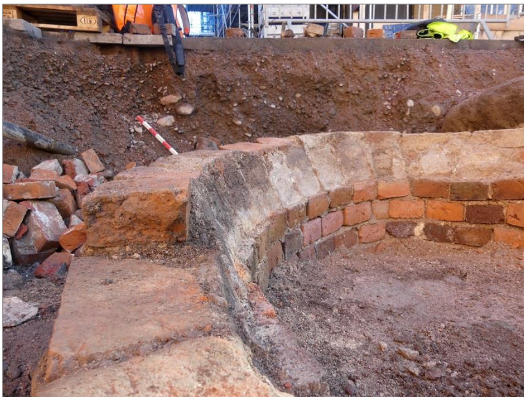
Figur 35. Detalj av valvets bas. Tegelstenar i löp längs murens krön. Foto: Emelie Sunding, Upplandsmuseet.
