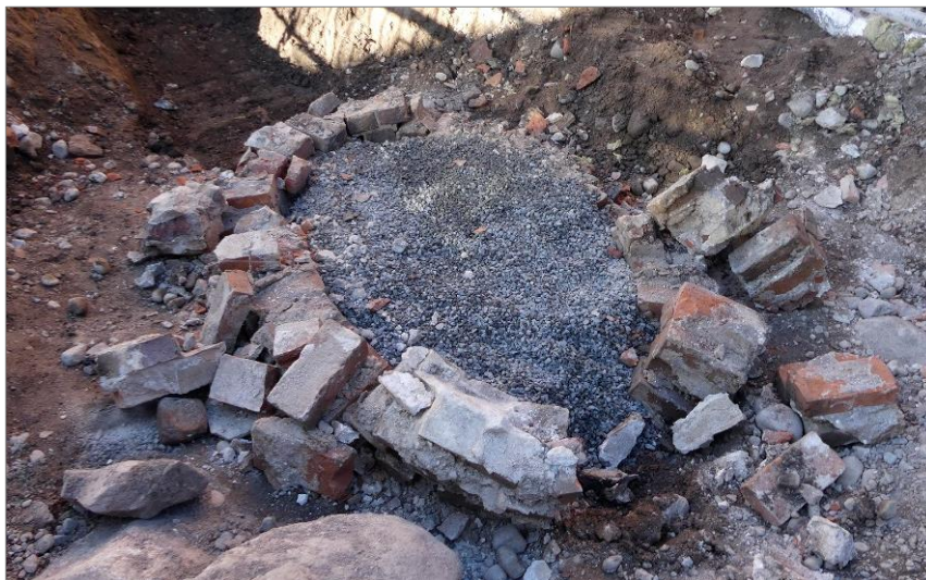
Figur 45. Brunnen fylldes med singel och revs ned till 1,2 m under markytan. Foto Emelie Sunding. Upplandsmuseet.
