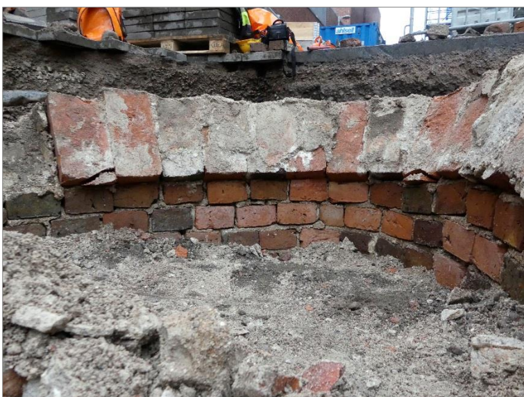
Figur 36. Detalj av valvets bas: Stående tegelstenar murade i vinkel. Foto: Emelie Sunding, Upplandsmuseet.
