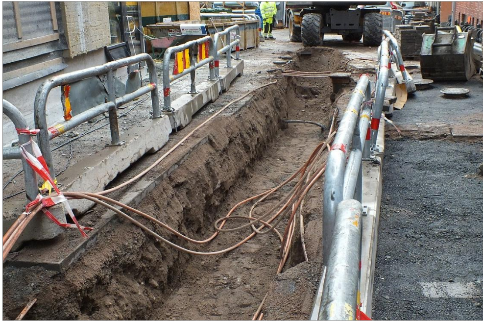
Figur 47. Fjärrvärmeschaktet i NÖ delen av Klostergatan. Foto mot SV, Robin Lucas, Upplandsmuseet.
