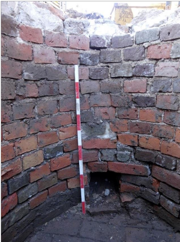
Figur 40 & 41. Överst brunnens nordöstra kortsida, med instucket stengodsror genom öppningen. Till höger brunnens sydvästra kortsida. Notera avsaknaden av bruk mellan de fem lägsta skiften, synligt på båda bilderna. Foto: Emelie Sunding, Upplandsmuseet.
