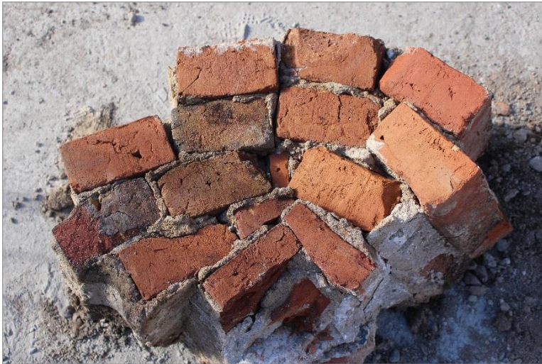
Figur 34. Delar av det avlägsnade valvet. Notera att ett par av stenar är sekundärbrända. Foto: Emelie Sunding, Upplandsmuseet
