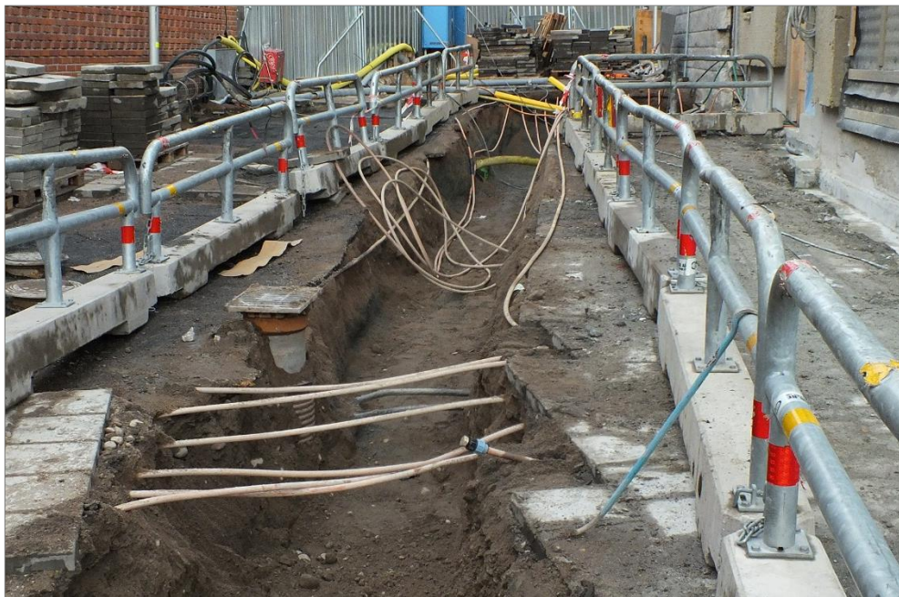
Figur 48. Sista sträckan av fjärrvärmeschaktet i Klostergatan där det inte fanns några bevarade kulturlager. Foto mot NÖ, Robin Lucas, Upplandsmuseet.
