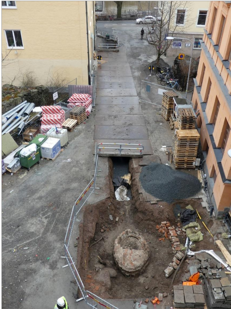
Figur 44. Klostergatan under pågående schaktning för fjärrvärme i april 2018. Brunnen (8) ligger mitt i Klostergatans sträckning. Foto Robin Lucas, Upplandsmuseet.
