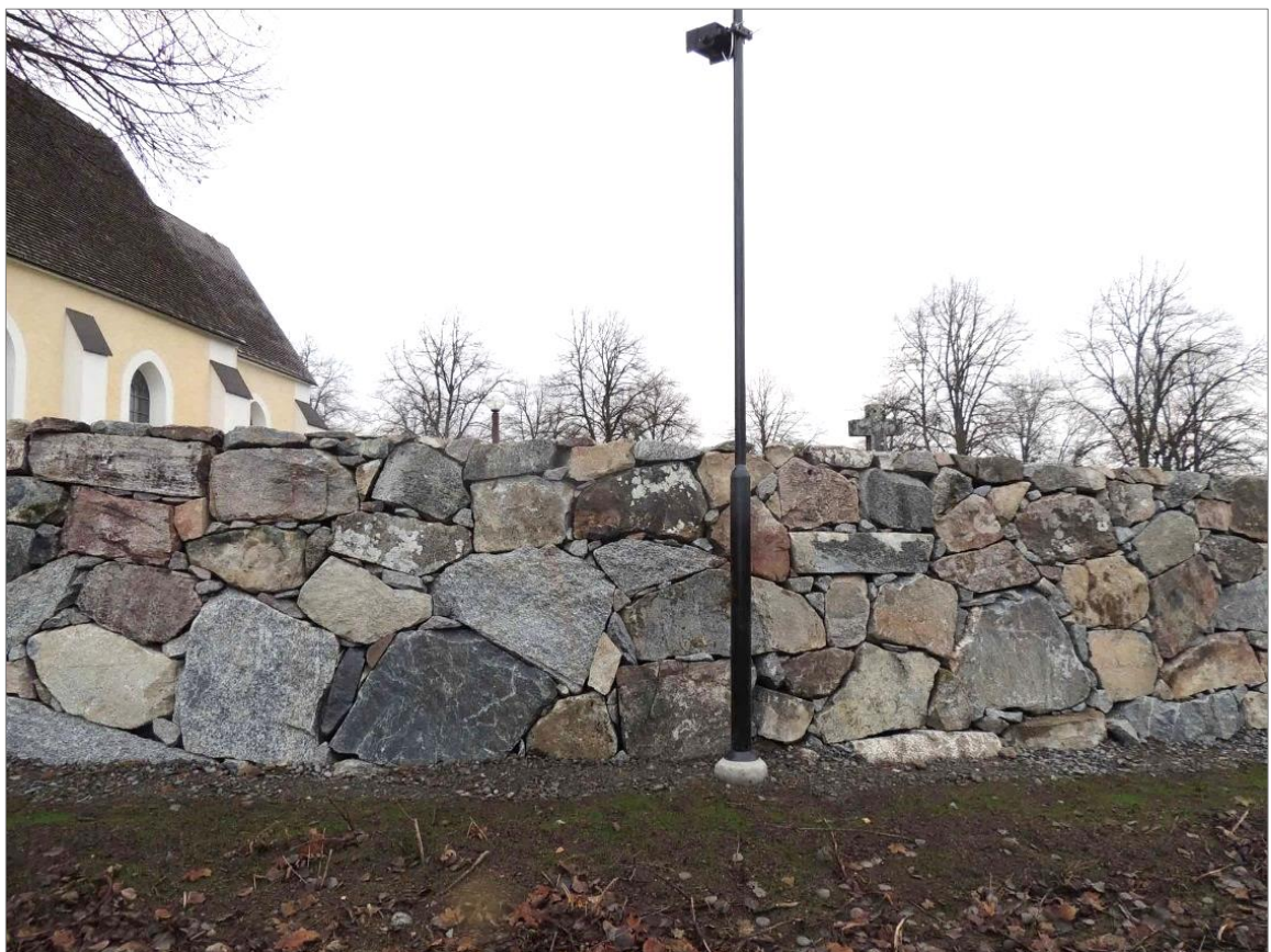
Figur 21. Samma parti efter renoveringen av muren. Foto mot Ö, Anna Ölund, Upplandsmuseet.
