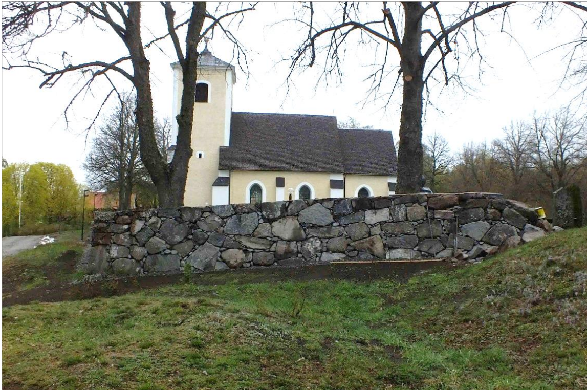
Figur 23. Den södra murens västra del efter renoveringen. Foto mot N.
