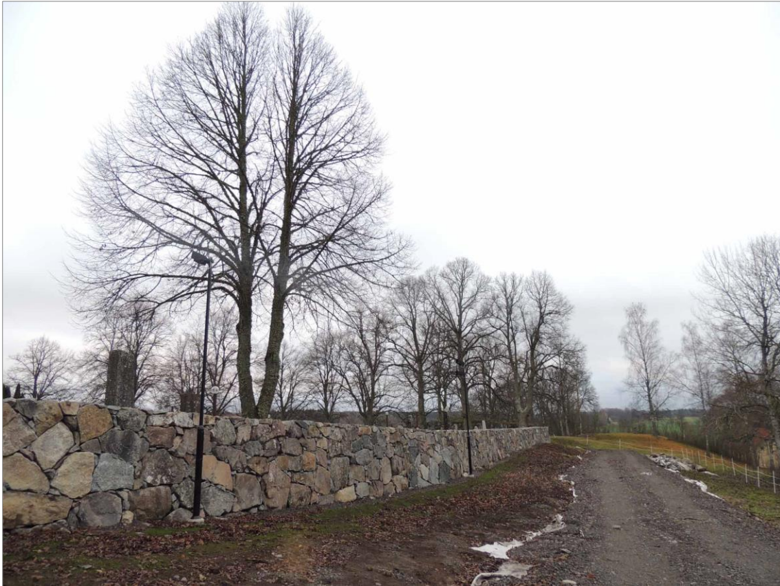
Figur 19. Den västra muren efter renovering och omläggning. Foto mot S, Anna Ölund, Upplandsmuseet.
