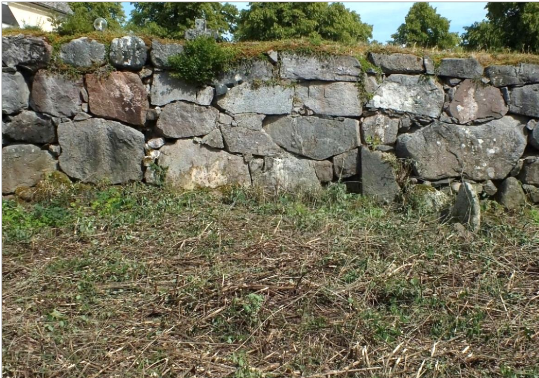
Figur 13. Muren före renovering där två stötfogar på ca 2,5 m avstånd samt stenar med ljusare färg och avvikande bearbetning visar platsen för en ingång på västra sidan. Denna ingång sattes igen under 1800-talet. Till höger gränsmärket A4. Foto mot Ö.
