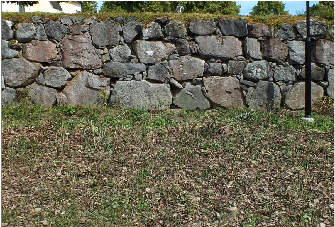
Figur 20. Parti av muren norr om platsen för stigluckan före renoveringen av muren. Foto mot Ö.
