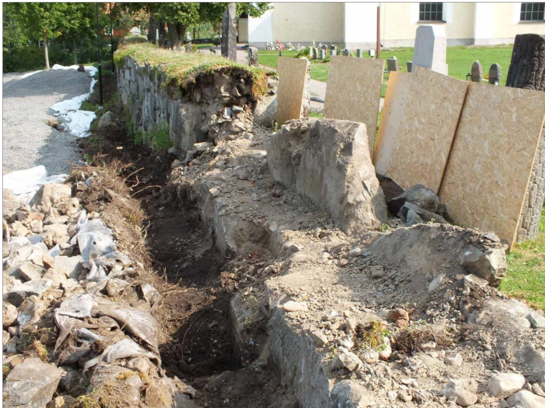
Figur 18. Den västra muren var en skalmur i murbruk. Stenarna in mot kyrkogården utgjordes ofta av flata hällar ställda på högkant. Här i delen strax söder om den tidigare stigluckan. Foto mot N.
