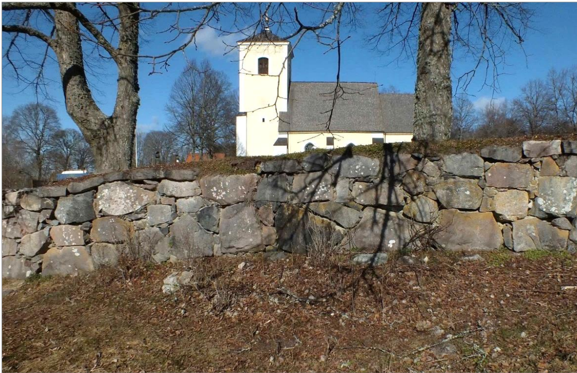
Figur 22. Södra murens västra del före renoveringen. Foto mot N.
