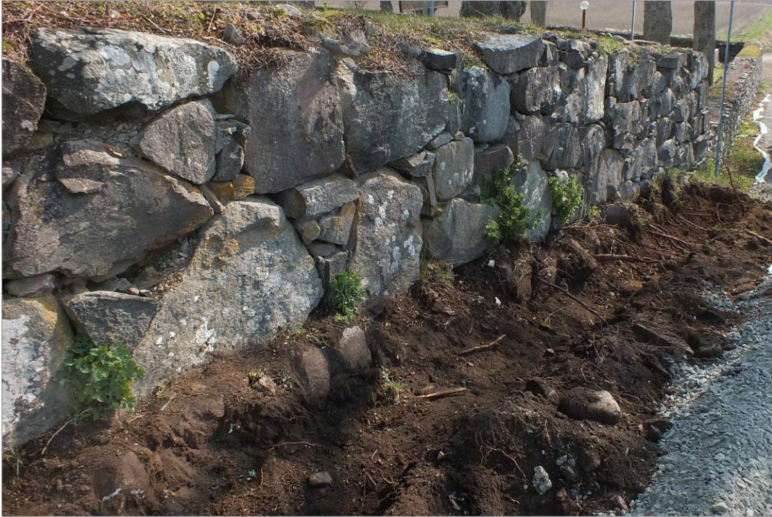
Figur 16. Schaktet längs södra muren visade att det fanns ett fundament av stenar som stack ut utanför murens bottenskiift. Foto mot NO.
