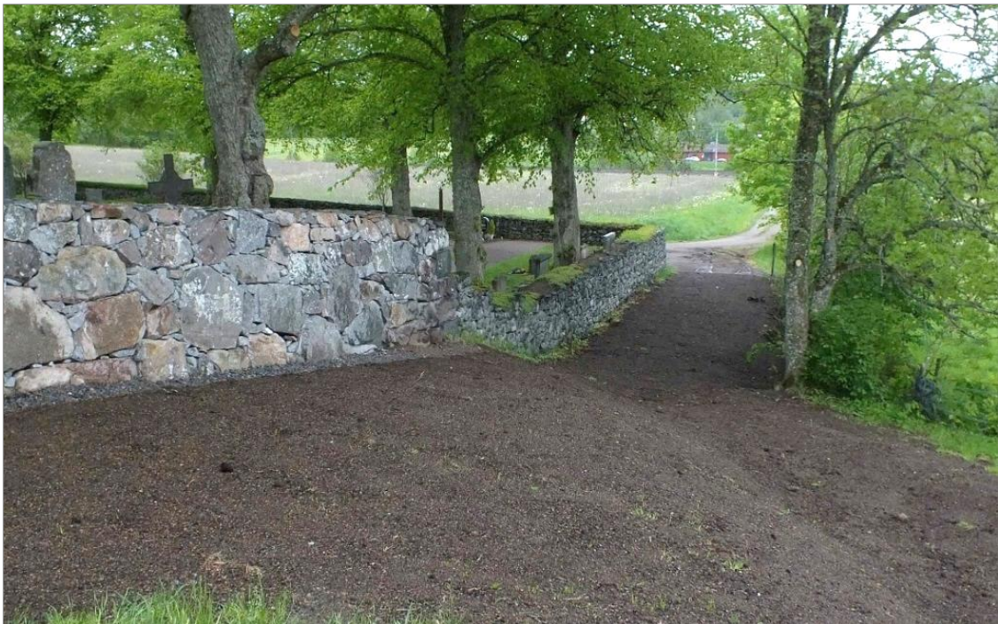
Figur 11. Ytan vid murens sydöstra del och hålvägen A8 (L2019:2338) (till höger) efter att renoveringen av muren var klar och arbetsvägen tagits bort. Foto mot Ö.
