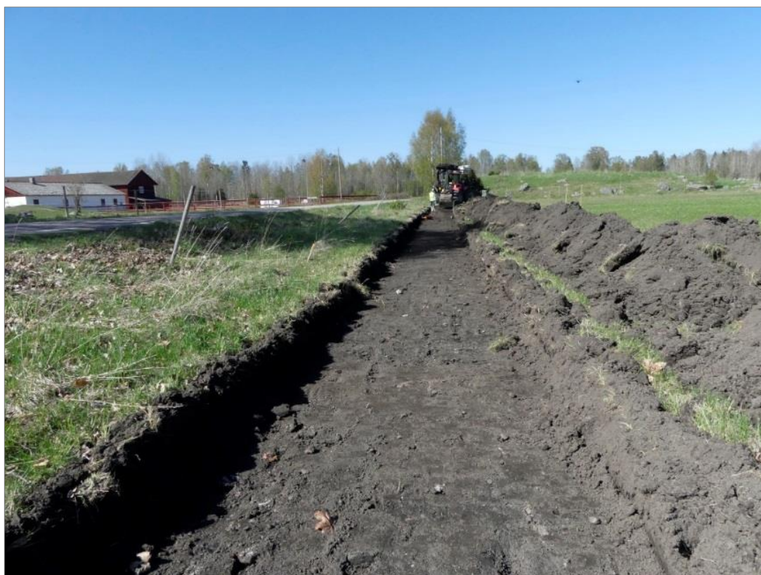
Figur 4. Hans Göthberg schaktar fram kulturlagret 2170 under utredningen i maj 2018. I bakgrunden gravfältet Skuttunge 77:1. Foto mot N, Malin Lucas, Upplandsmuseet.
