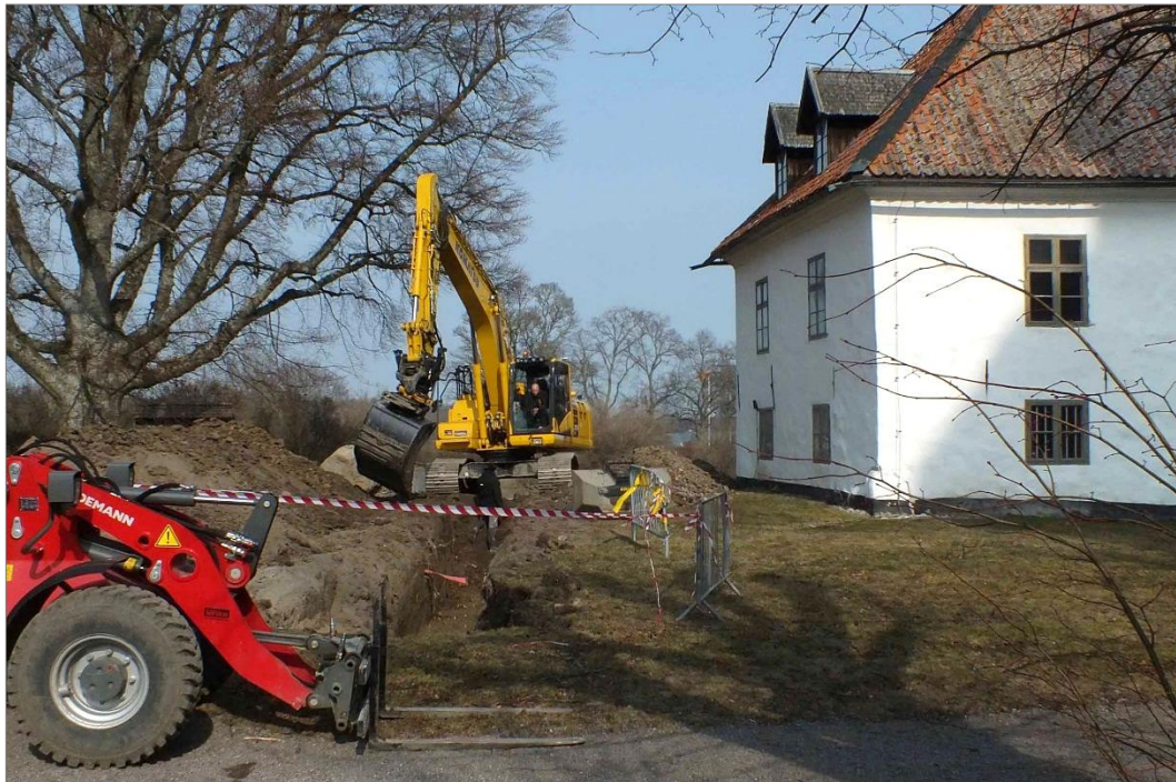
Figur 12. I schaktet omedelbart väster om Stenhuset påträffades enbart enstaka lämningar, men desto fler sentida ledningar. Foto mot N.
